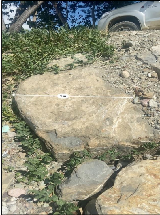
Figura 9: Longitud de la roca del enrocado existente
