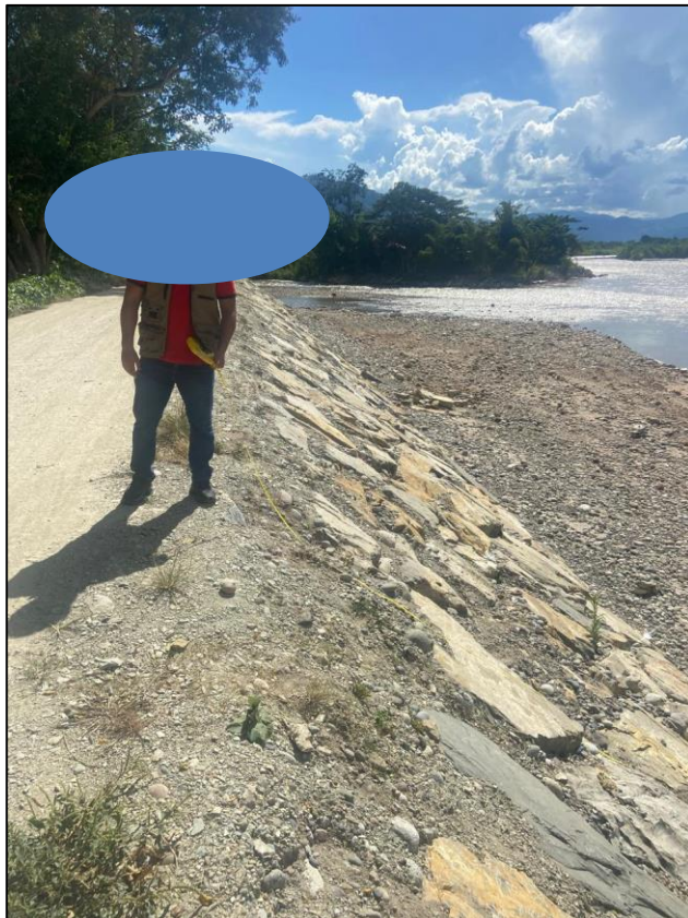
Figura 2: Verificación del tramo a intervenir del enrocado existente
