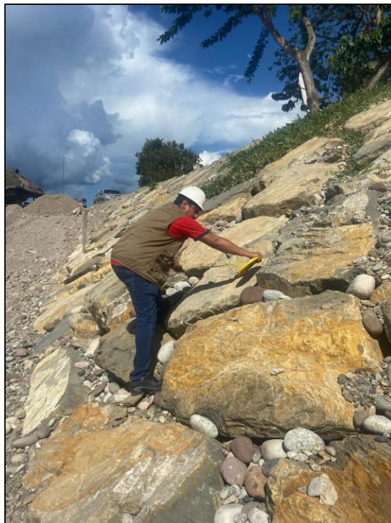
Figura 4: Medición de la longitud del enrocado existente
