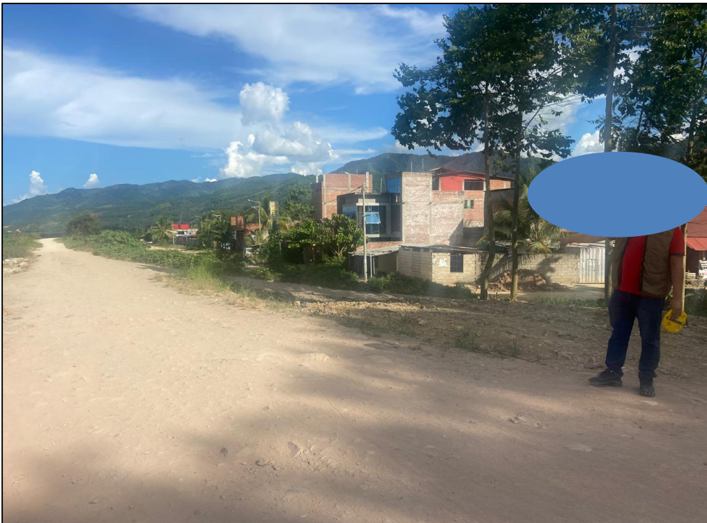
Figura 12: Carretera al lado del enrocado existente
