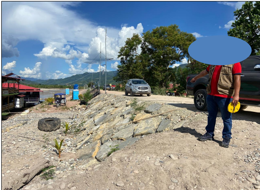
Figura 14: Vista del enrocado existente
