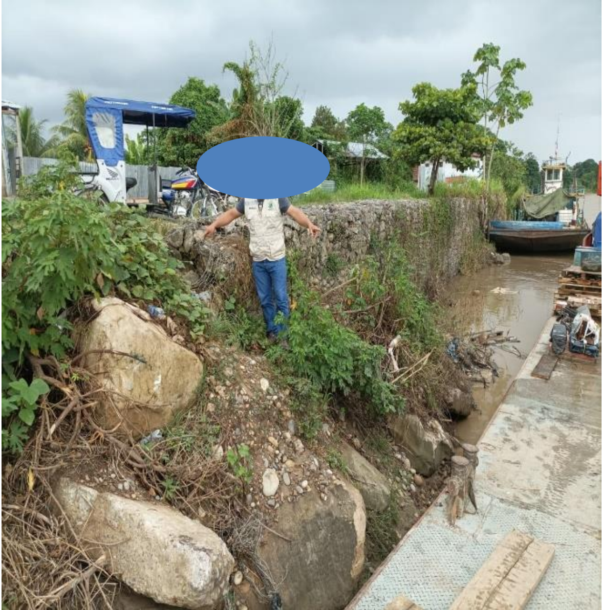
Figura 10: Inicio del muro de gavion
