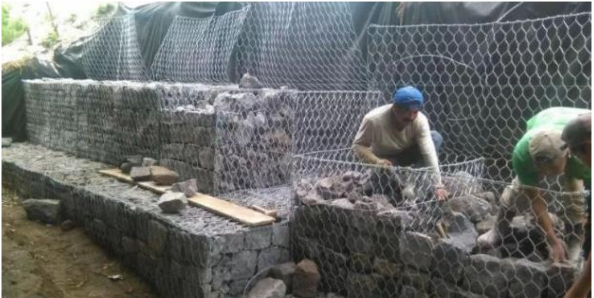
Imagen 5: llenado de los gaviones y colocado de tensores.
