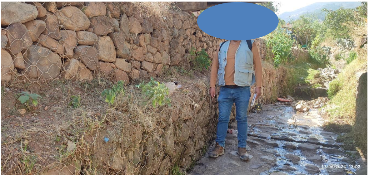
Imagen 17: vista panorámica del muro de gaviones del margen derecho. Fuente: imagen propio
