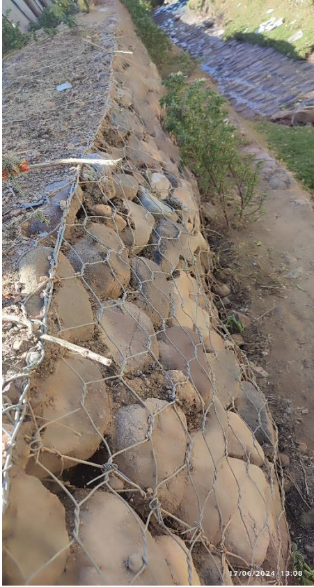
Imagen 20: presencia de desplazamiento (izquierda) y sedimentos encima de la malla (derecha) en el muro de gaviones.
