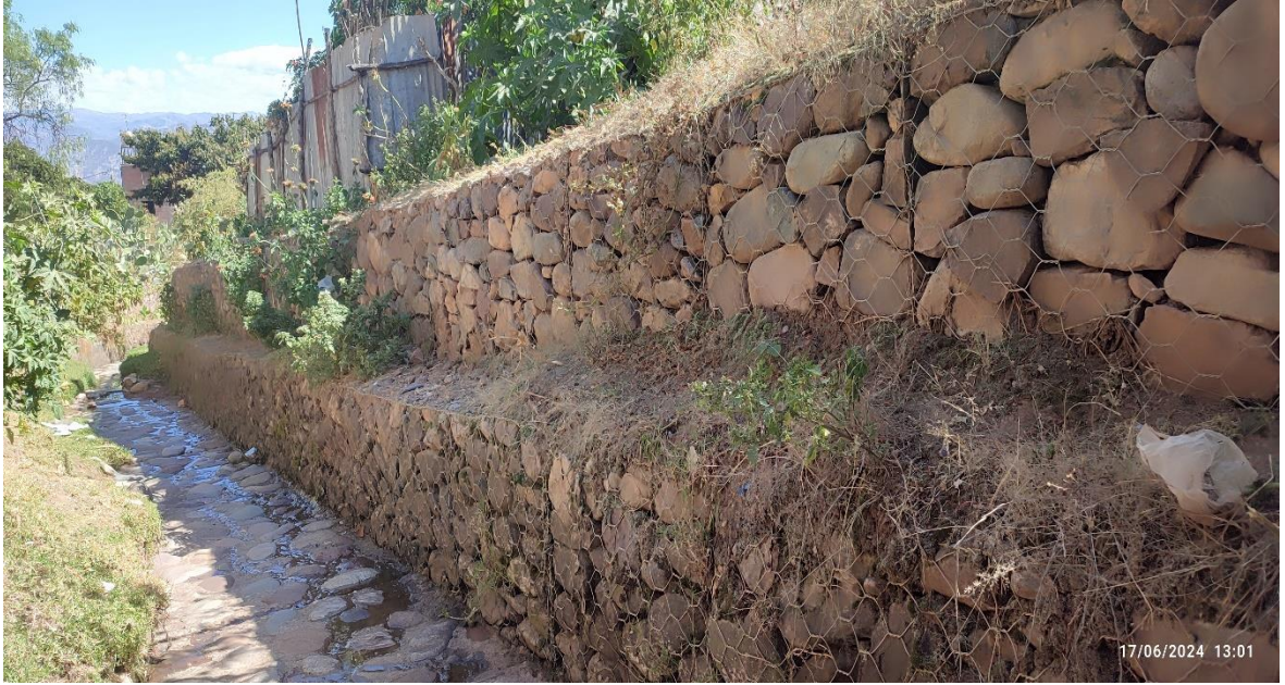
Imagen 16: vista panorámica del muro de gaviones Fuente: imagen propio
