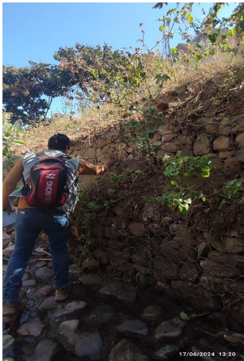
Imagen 25: presencia de pastos en la malla (derecha) y acumulación de desmonte (izquierda) en el muro de gaviones. Fuente: imagen propio
