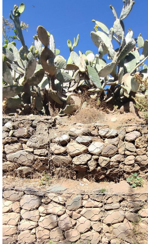
Imagen 24: presencia de plantación de tunales (derecha) y reemplazo de la malla rota por concreto (izquierda) en el muro de gaviones. Fuente: imagen propio
