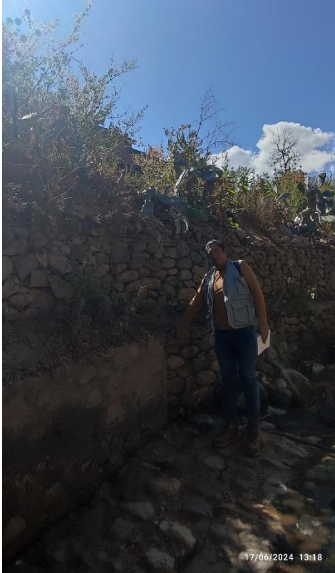
Imagen 24: presencia de plantación de tunales (derecha) y reemplazo de la malla rota por concreto (izquierda) en el muro de gaviones. Fuente: imagen propio
