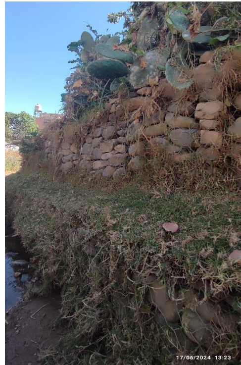
Imagen 25: presencia de pastos en la malla (derecha) y acumulación de desmonte (izquierda) en el muro de gaviones. Fuente: imagen propio
