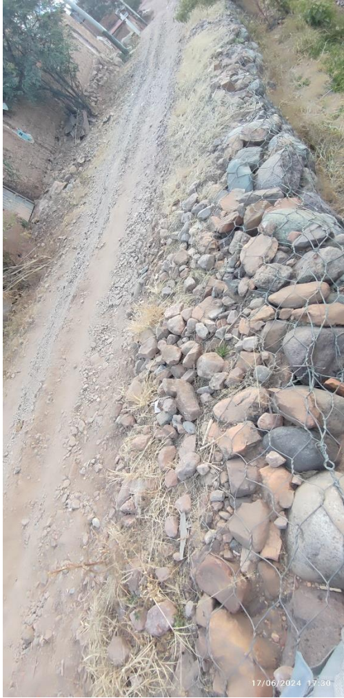
Imagen 26: presencia de desplazamiento (derecha) y deformación de la malla (izquierda) en el muro de gaviones. Fuente: imagen propio
