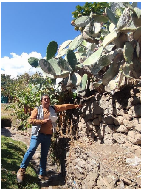
Imagen 11: desplazamiento del muro de gavión.
