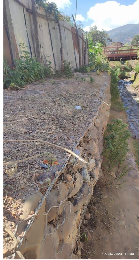
Imagen 20: presencia de desplazamiento (izquierda) y sedimentos encima de la malla (derecha) en el muro de gaviones.
