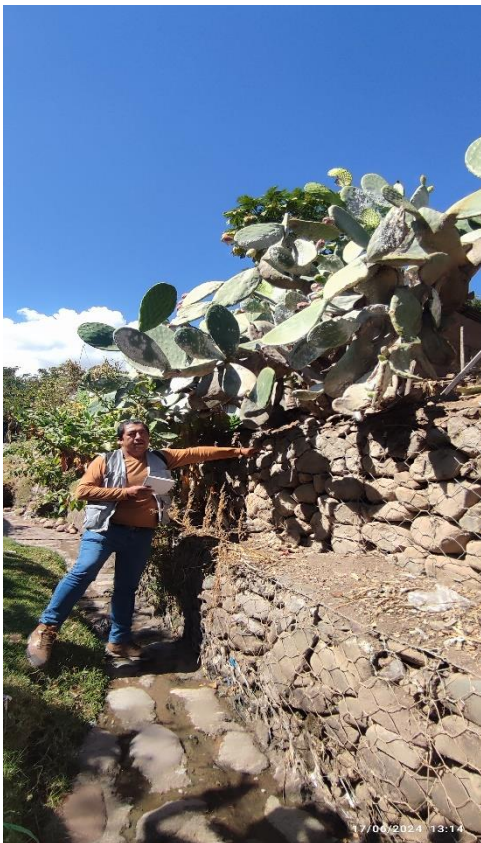
Imagen 23: presencia de plantación de tunales y acumulación de basuras en el muro de gaviones. Fuente: imagen propio
