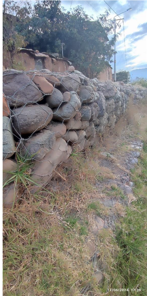
Imagen 26: presencia de desplazamiento (derecha) y deformación de la malla (izquierda) en el muro de gaviones. Fuente: imagen propio
