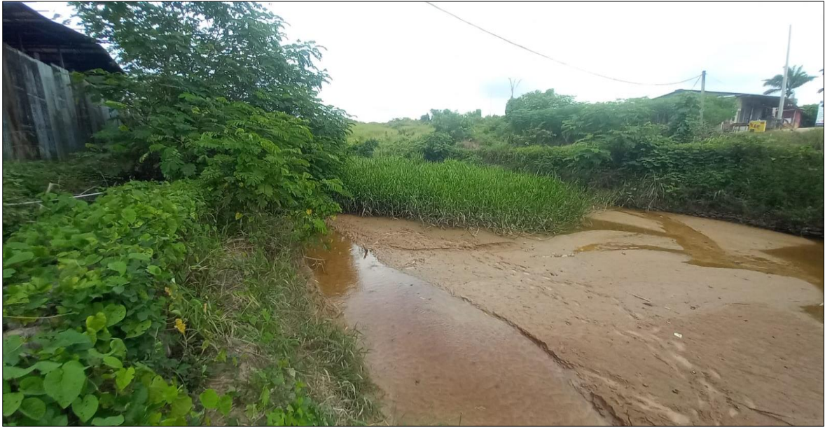
Figura 15: Se aprecia mucha vegetación en todo el tramo de muro de gavión
