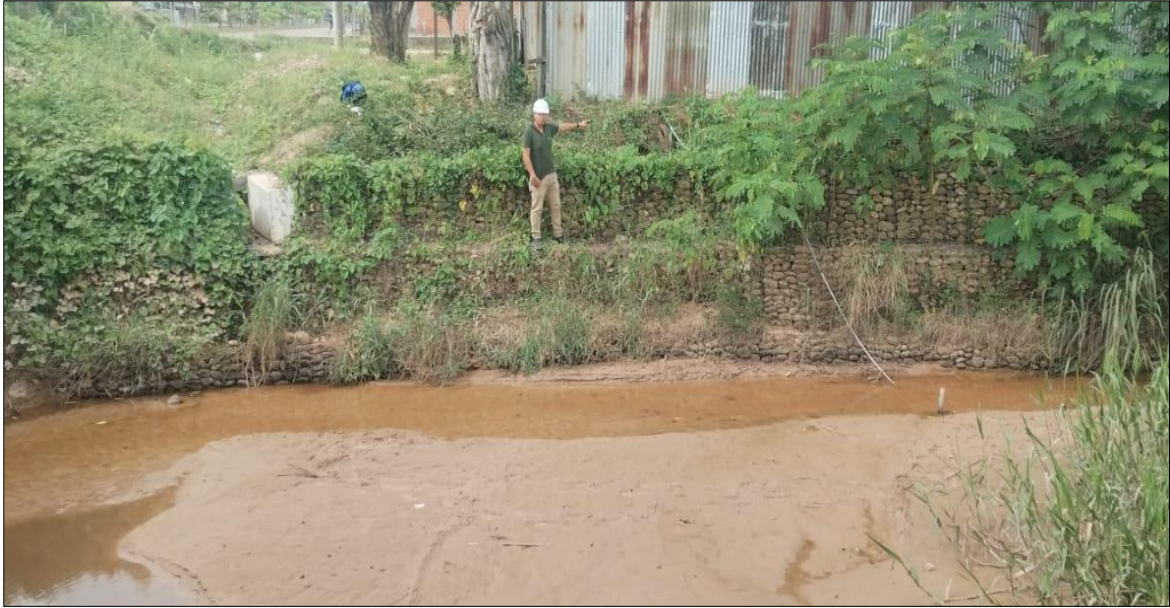
Figura 7: Margen izquierda del muro de gavión
