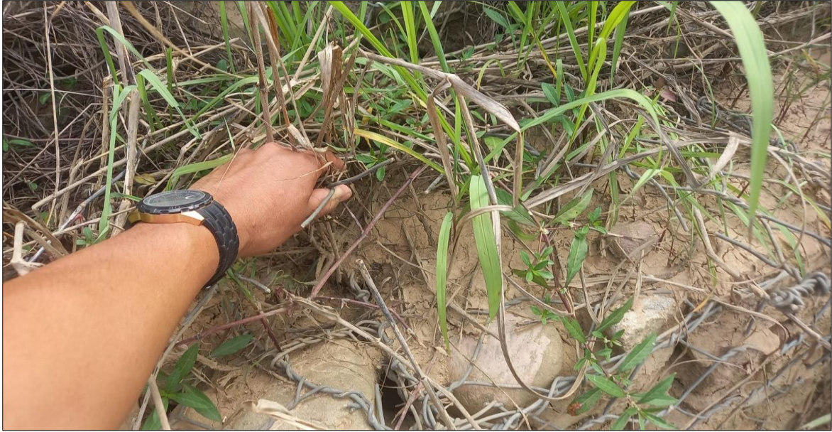
Figura 9: Malla hexagonal del muro de gavión lado izquierda
