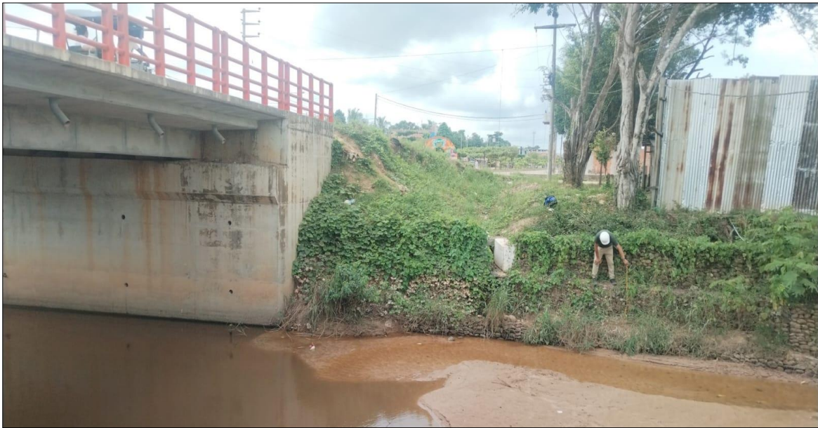
Figura 10: Se aprecia la medición del muro de gavión tipo caja
