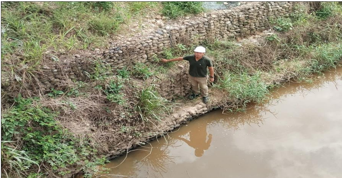
Figura 6: Margen derecha del muro de gavión
