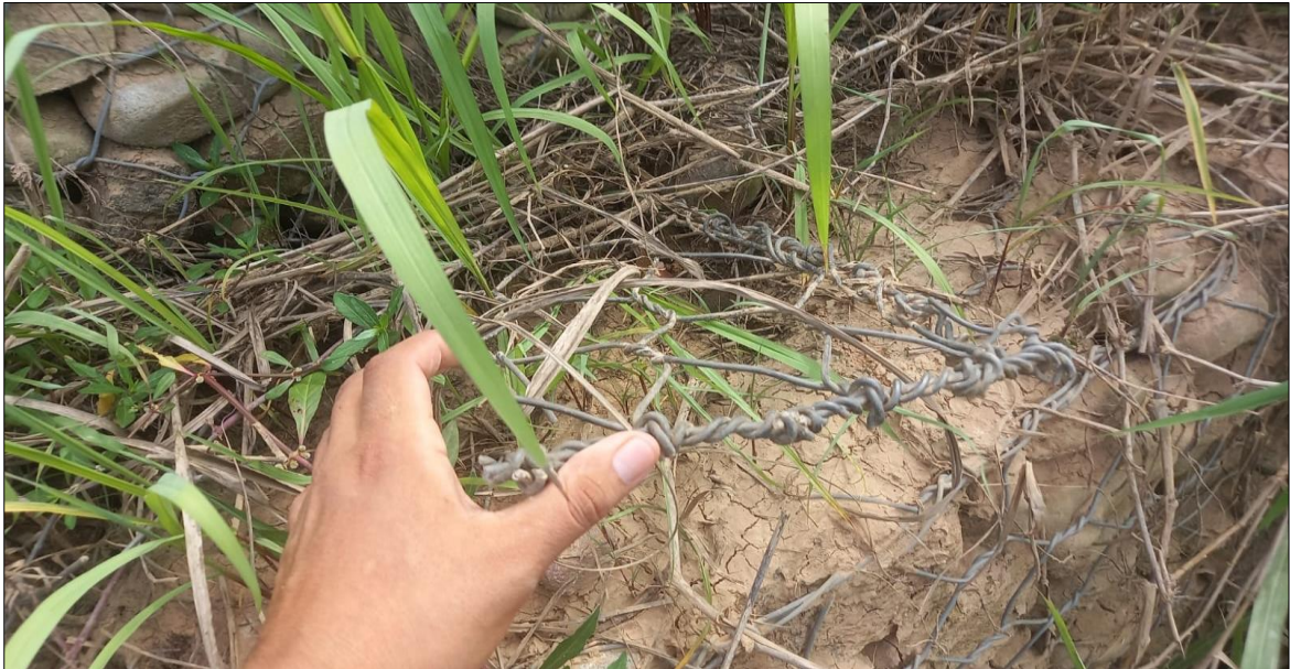
Figura 8: Malla hexagonal del muro de gavión lado derecho
