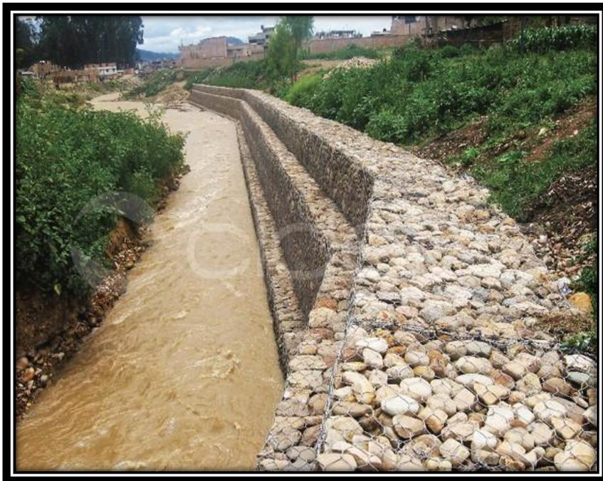
**Figura 1:** Muro de gavión
