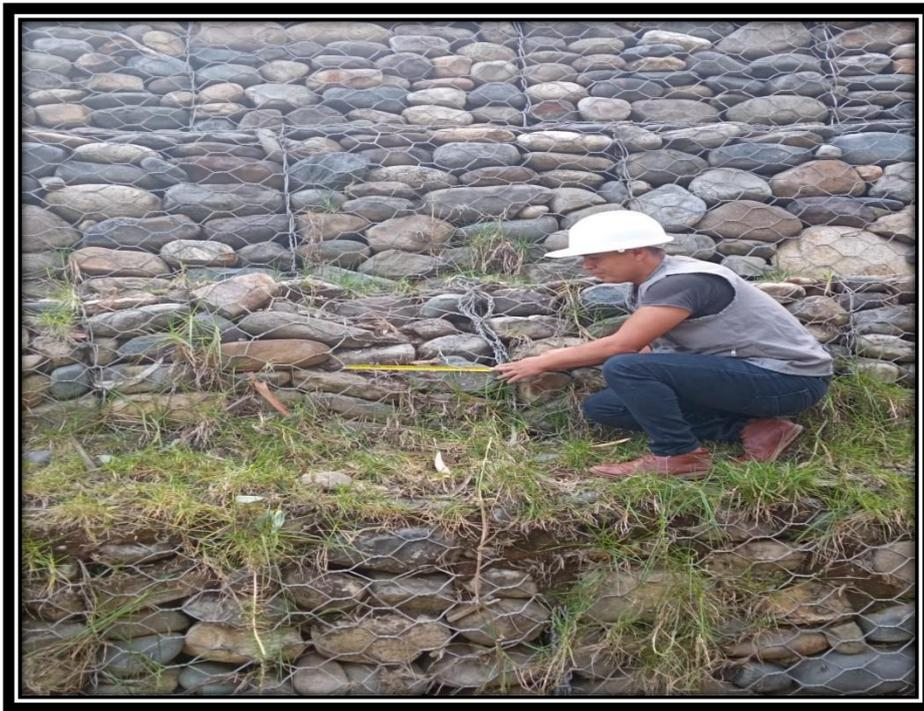
**Figura 14:** Desprendimiento en la progresiva 1+080 a 1+100
