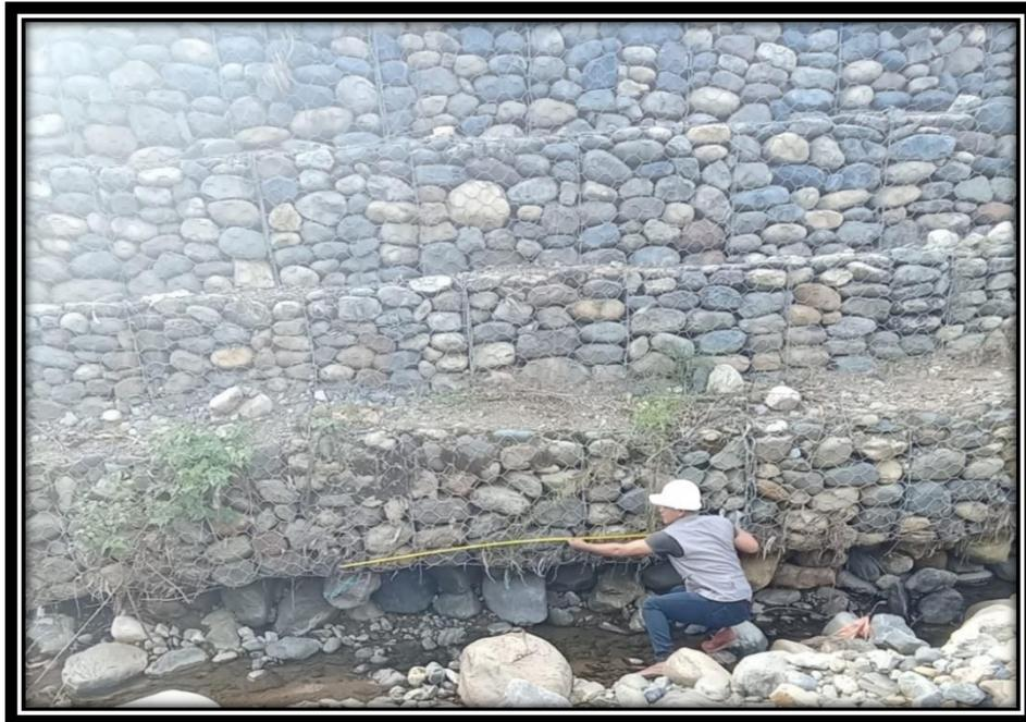
**Figura 10:** Socavación en la progresiva 1+000 a 1+020
