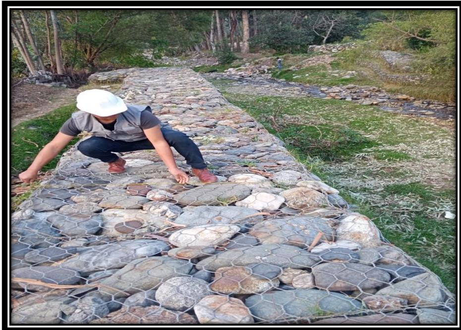
**Figura 9:** Realizando la medición del muro de gavión
