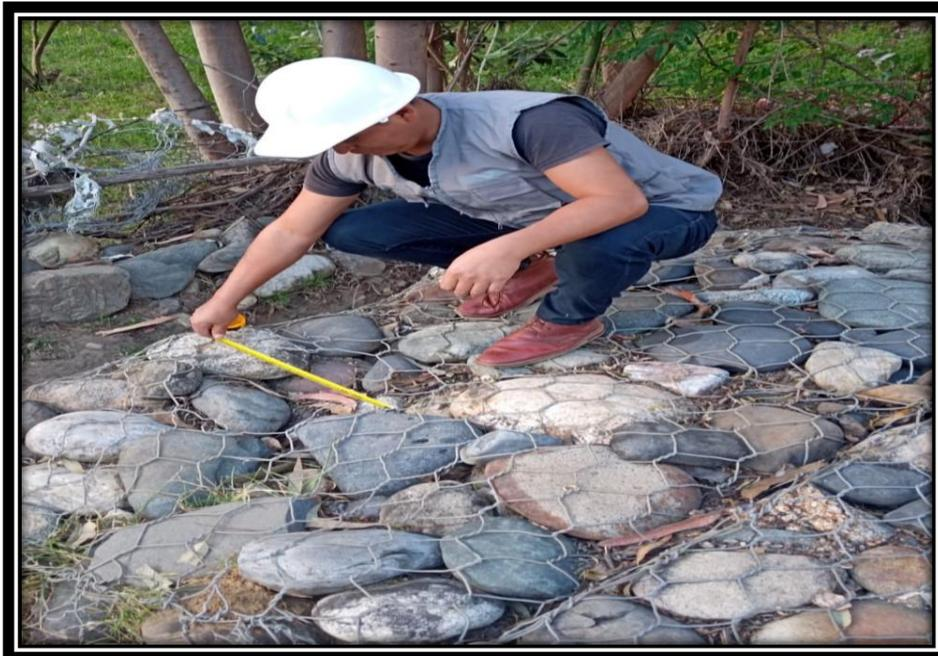
**Figura 12:** Rotura de malla en la progresiva 1+040 a 1+060
