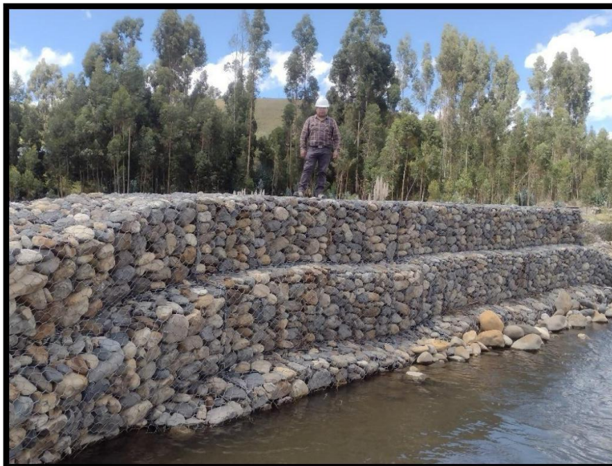
EN LA IMAGEN N° PODEMOS OBSERVAR EL UNICO MURO DE GAVION QUE TODABIA SE CONSERVA EN UNOS 50MS
