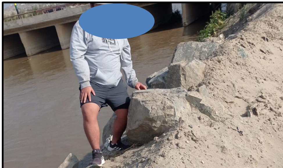
Figura 12: Inicio del tramo km 0+800
