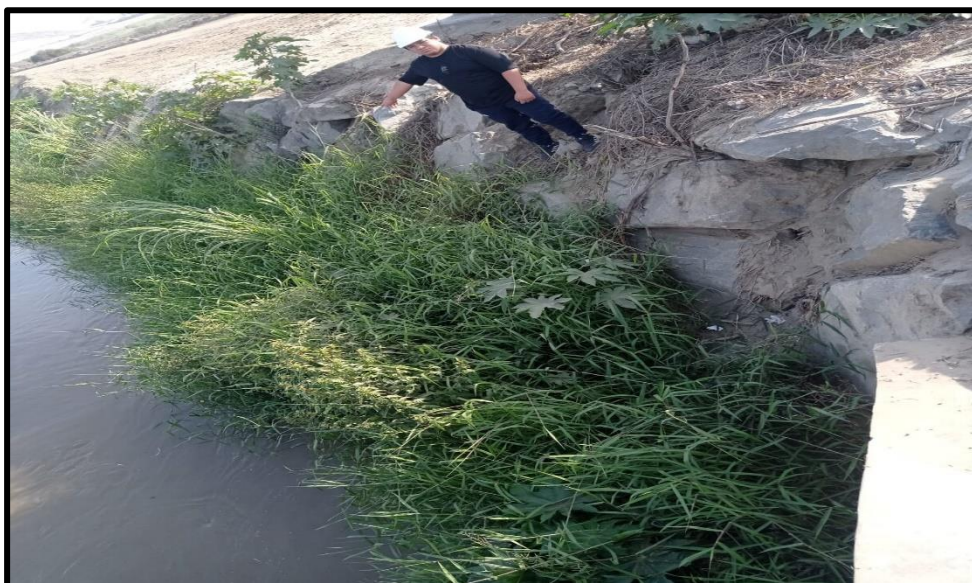
Figura 18: Final del enrocado km 1+950
