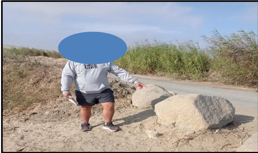
Figura 15: Zona deteriorada por desprendimiento de roca
