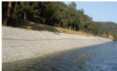
Figura 2. Gaviones para contención fluvial. Fuente:(A Bianchini, 2017).
