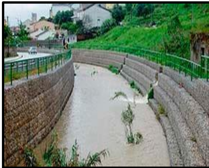
Figura 7: Muro de gavión
