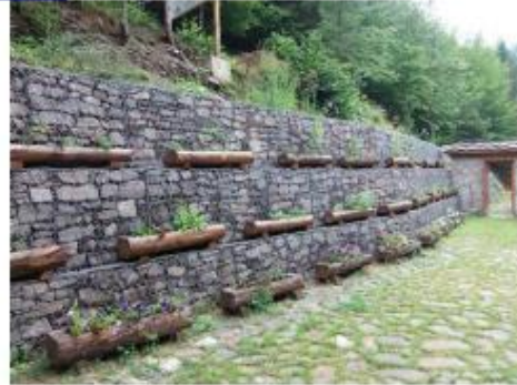
Figura 1. Estructura con gaviones. Fuente: http://www.solucionesespeciales.net/MedioAmbiente/Gaviones/Gaviones.aspx
