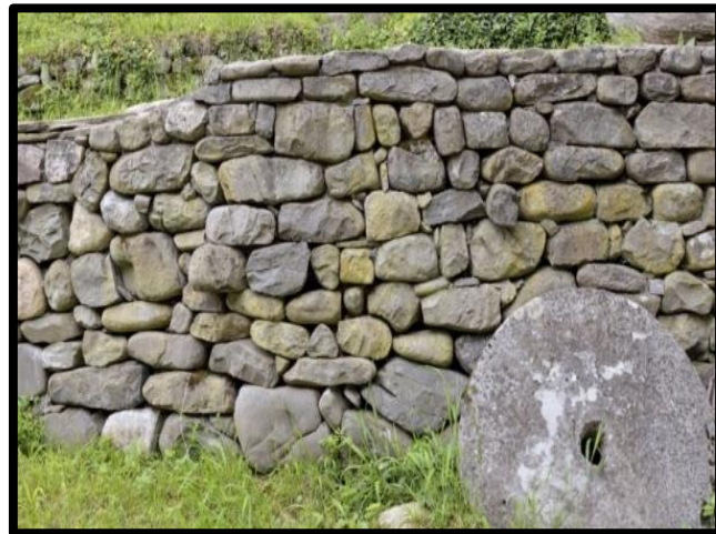
Figura 13: Piedras para muro de gavion
