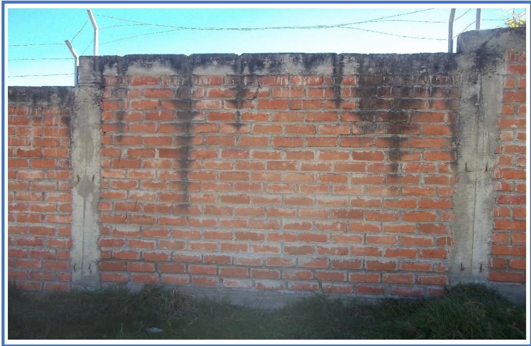
Imagen N° 11 Fotografía de Moho en Vigas y Muros
