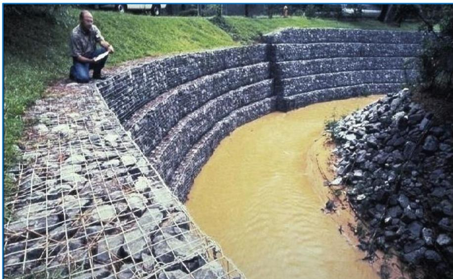
**Figura 7.** Gaviones en un margen de un río (25)
