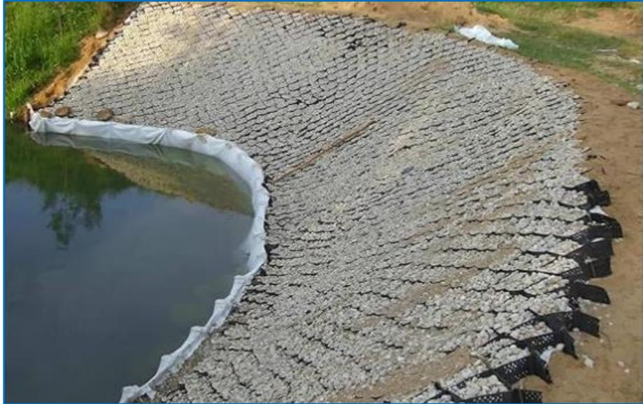
**Figura 6.** Defensa ribereña con Geoceldas. Fue extraído de Beneficios de las Geoceldas (23)
