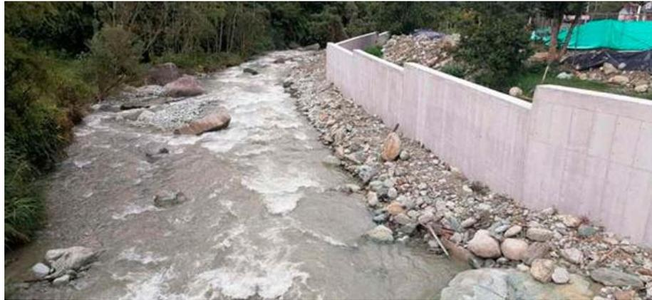
**Figura 11.** Muros de concreto armado (29)
