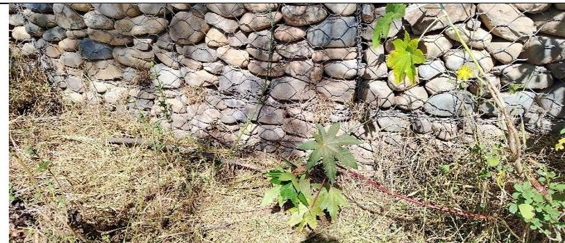
0+600 – 0+662 Se evidencia la presencia de sedimentos, que cubren la base de los gaviones. Con una altura promedio de 15 cm de altura desde la base de los gaviones.
