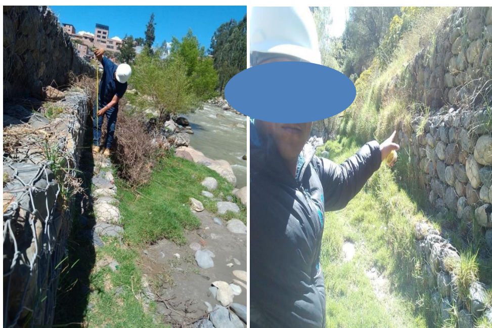
Figura 6: Evaluación de muro en campo
