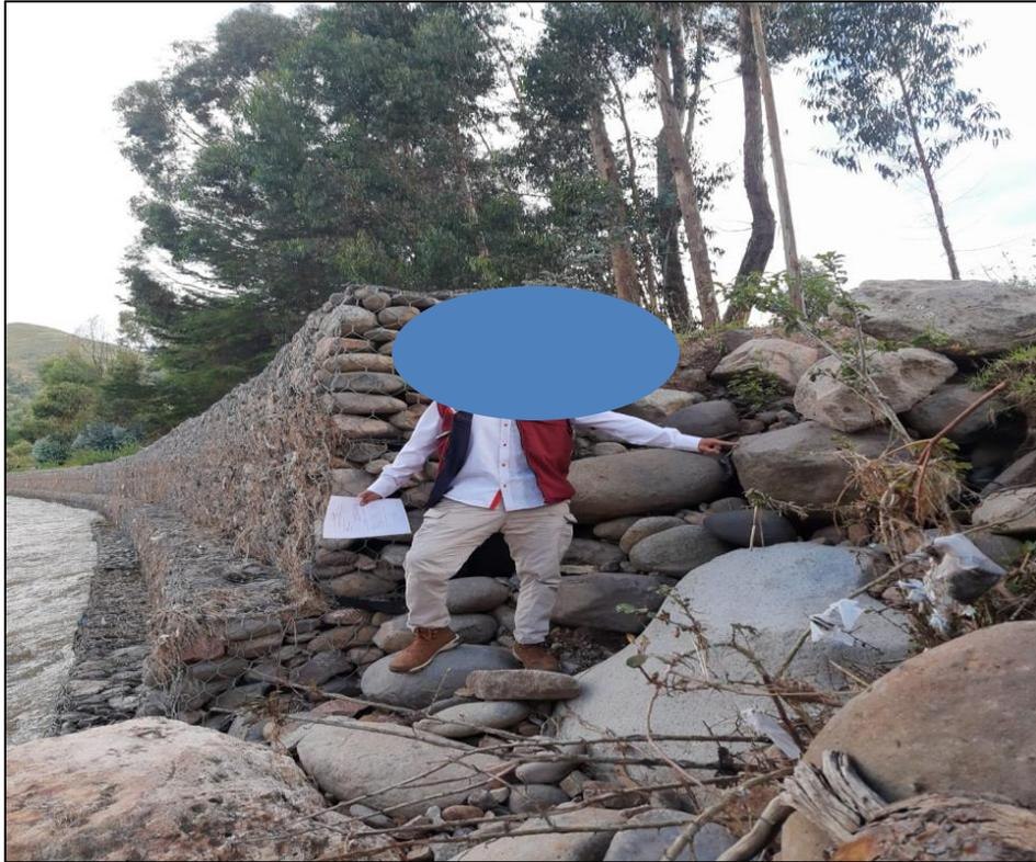
**Imagen 1:** vista de los tres niveles de gaviones que conforman el muro.
