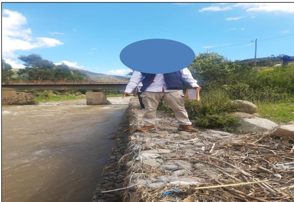
**Imagen 19:** se observa en el km 0+650 presencia de vegetación y basural encima del tercer nivel del muro de gaviones.
