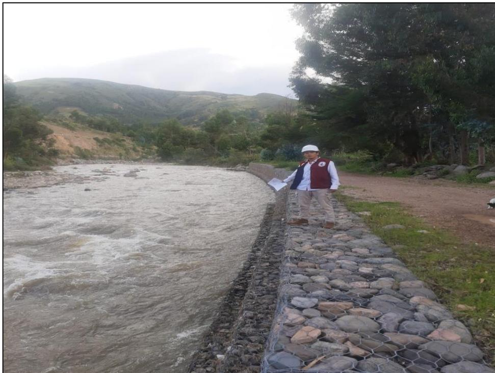
**Imagen 2:** vista amplia en la que se observa la presencia de la crecida del río Cachi que llega el caudal hasta el 2 nivel de muro de gavión.
