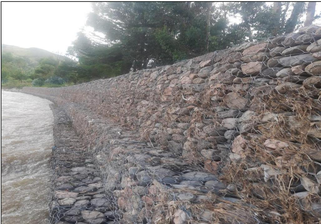
**Imagen 6:** se observa en el km 0+900 presencia de vegetación en los segundo y tercer nivel.
