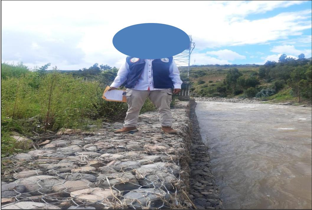
**Imagen 21:** se observa en el km 0+660 presencia de vegetación que esta siendo afectado el tercer nivel del muro de gaviones.
