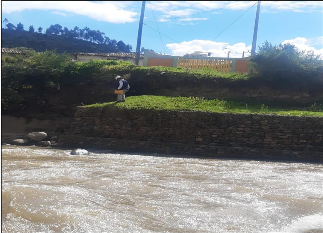
**Imagen 13:** se observa en el km 0+010 vista del muro de gaviones que esta siendo afectado por la vegetación.
