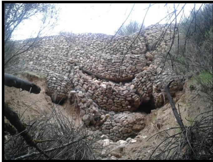
**Figura N° 2:** Fallas estructurales Muro de gaviones
