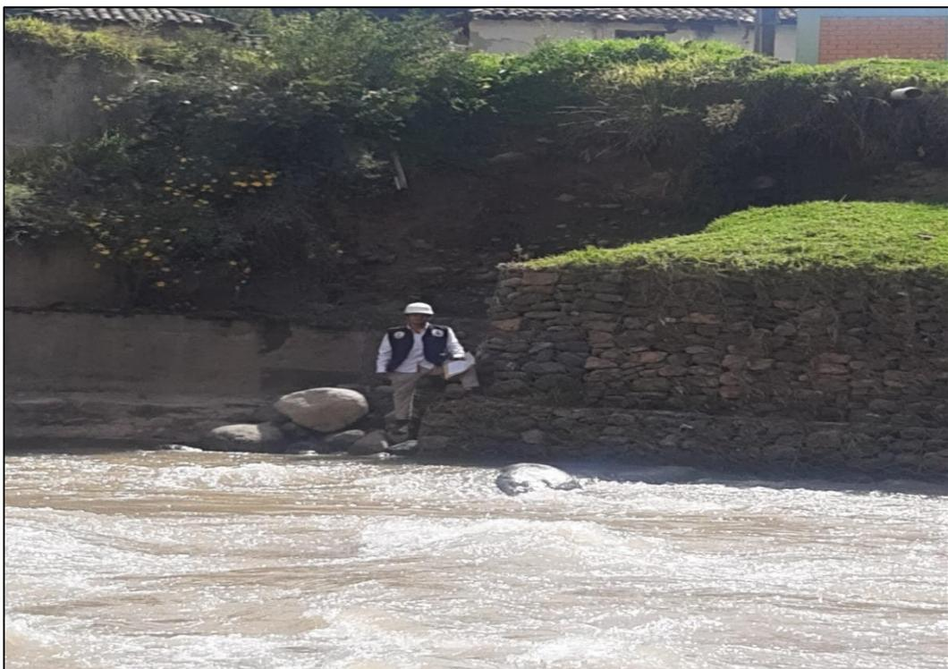
**Imagen 12:** se observa en el km 0+000 el inicio del muro de gaviones con presencia de un fuerte caudal y vegetación.
