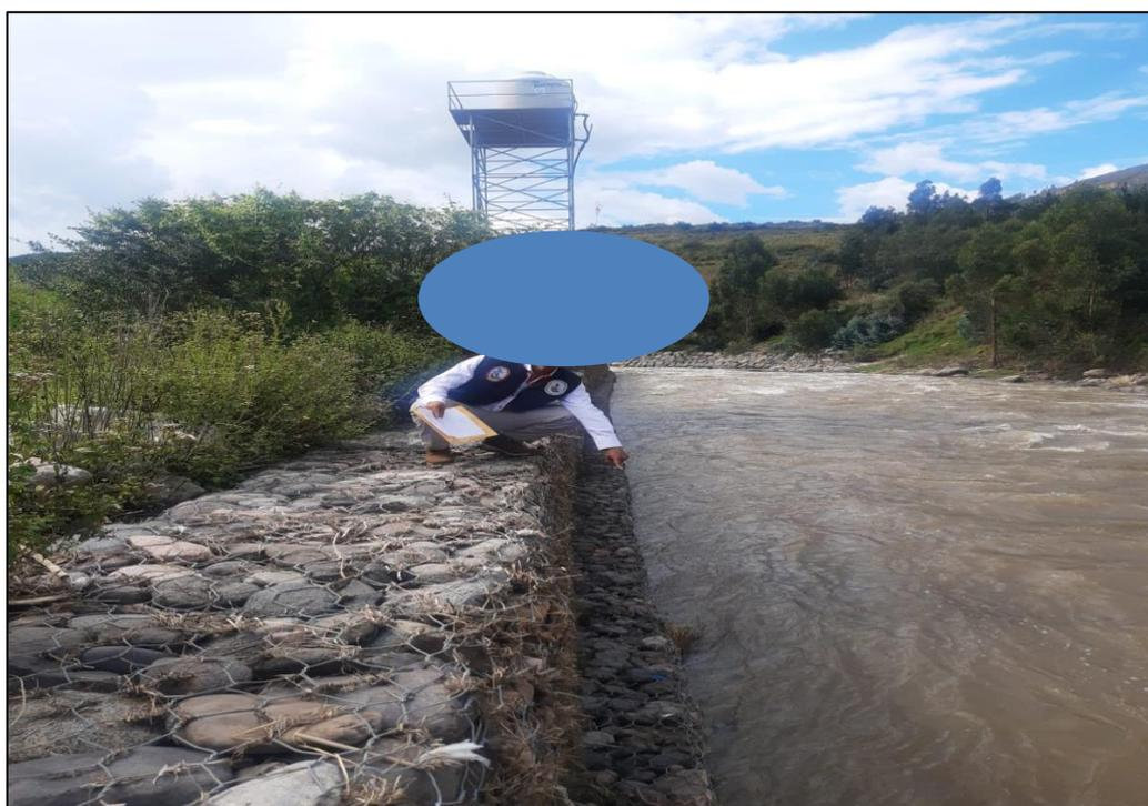
**Imagen 20:** se observa en el km 0+660 el caudal esta afectando al primer y segundo nivel del muro de gaviones y presencia de vegetación.
