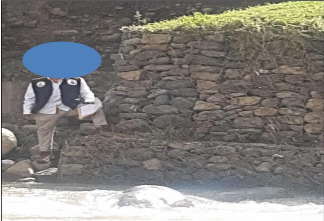
**Imagen 11:** se observa en el km 0+000 el caudal esta afectando al 2 nivel del muro de gaviones con una altura de 0.70 metros.
