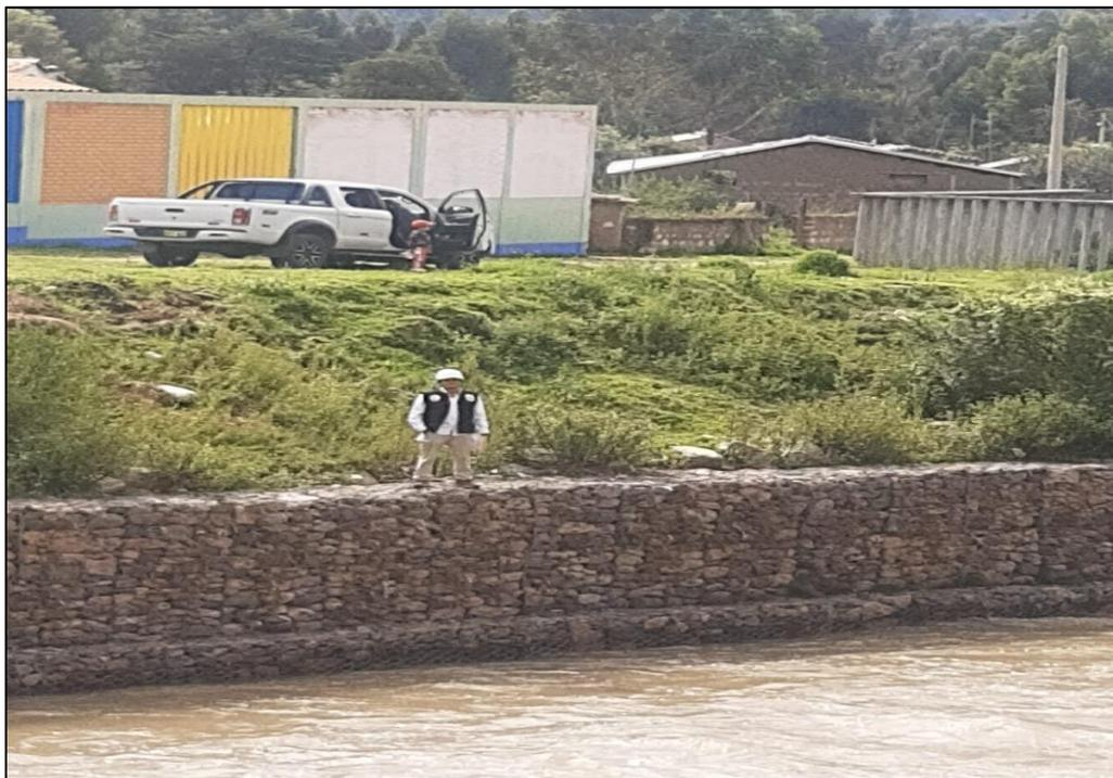
**Imagen 16:** se observa en el km 0+500 presencia de plantas y un caudal que está afectando hasta el segundo nivel del muro.
