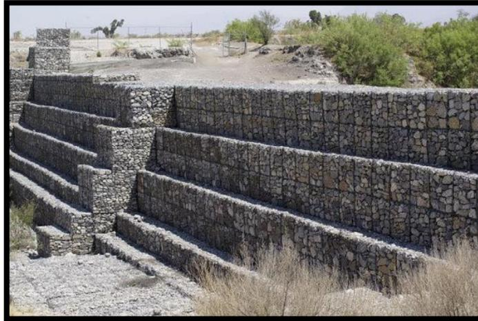
**Figura N° 1:** Muro de Gaviones
