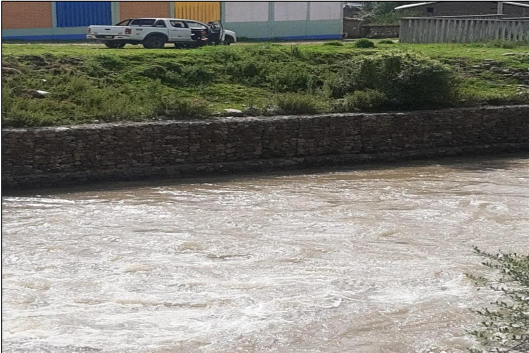
**Imagen 9:** se observa en el km 0+200 la vista del muro de gaviones y el caudal afectando hasta el 2 nivel de muro con una altura de 0.70 metros.
