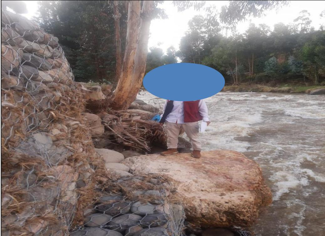
**Imagen 5:** se observa en el km 1+000 presencia de vegetación y volcamiento
