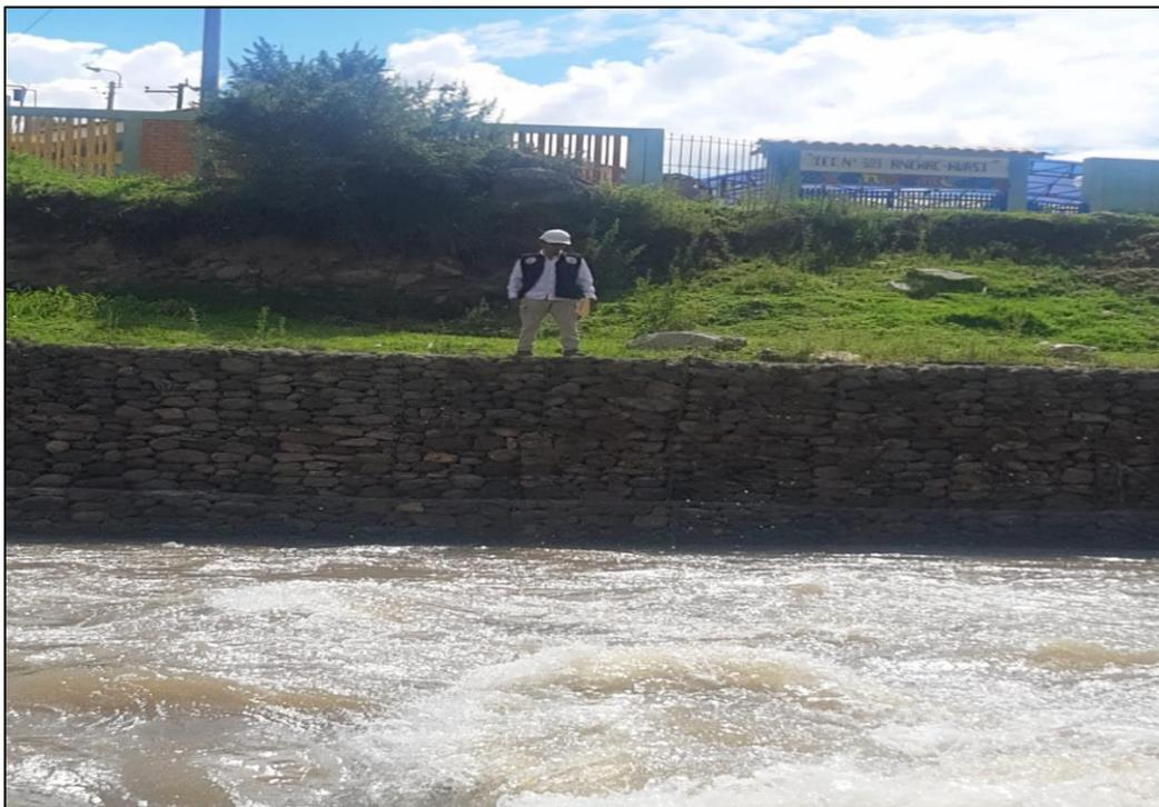
**Imagen 14:** se observa en el km 0+200 un fuerte caudal que esta siendo afectado el segundo nivel del muro de gaviones.
