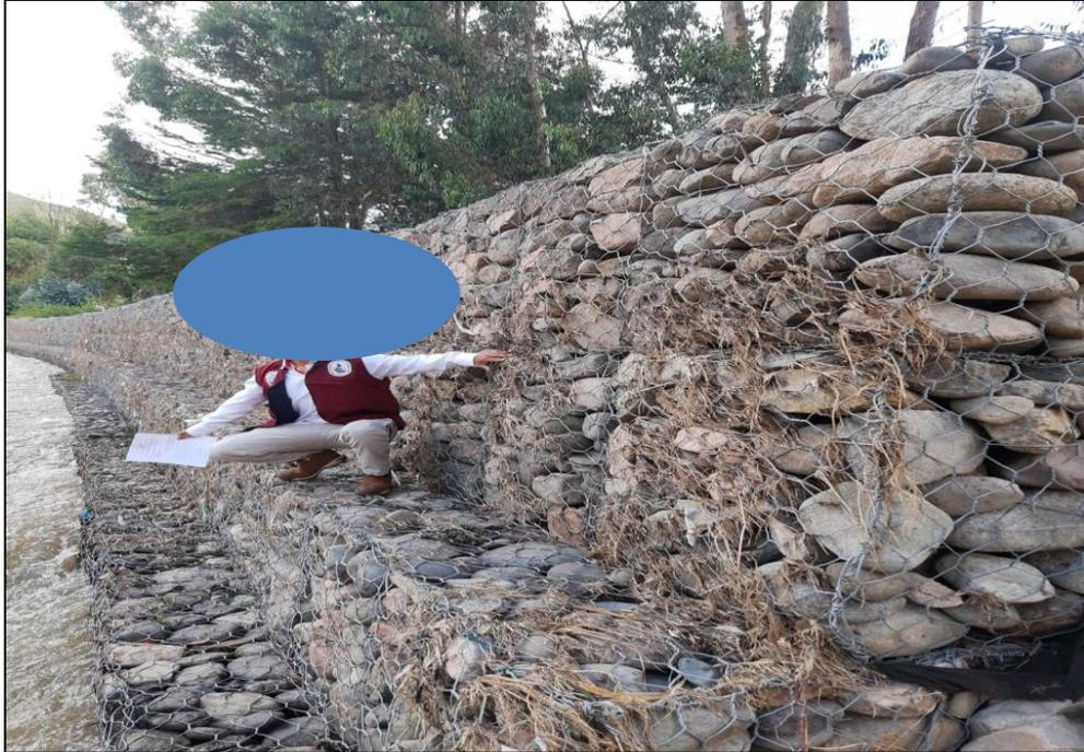
**Imagen 7:** se observa en el km 0+800 presencia de vegetación en el tercer y segundo nivel.
