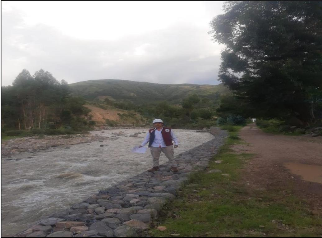
**Imagen 3:** se observa en el km 0+500 el buen estado del muro de gaviones sin presencia de vegetación
