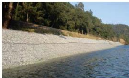
Figura 2. Gaviones para contención fluvial. Fuente: (A Bianchini, 2017).
