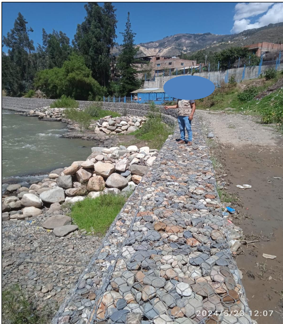
Figura 17: Evaluando el muro de gaviones del margen izquierdo.
