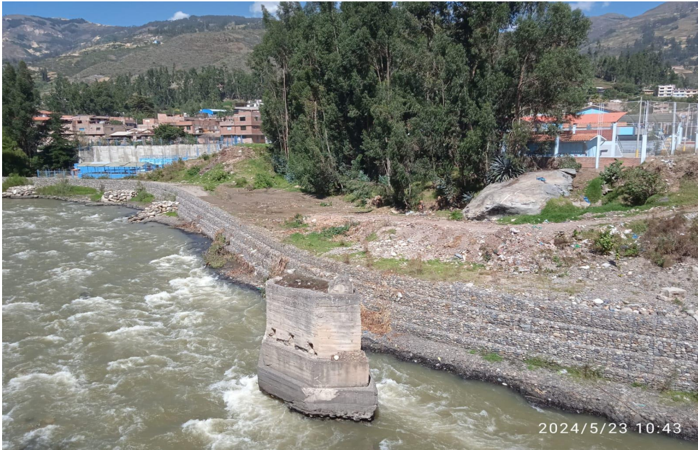
Figura 9: Vista panorámica del muro de gaviones Fuente: Evidencia de campo
