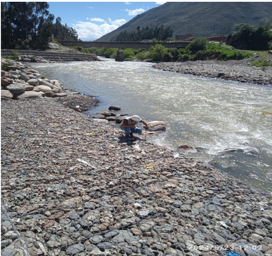
Figura 12: Evaluando la altura del colchón reno
