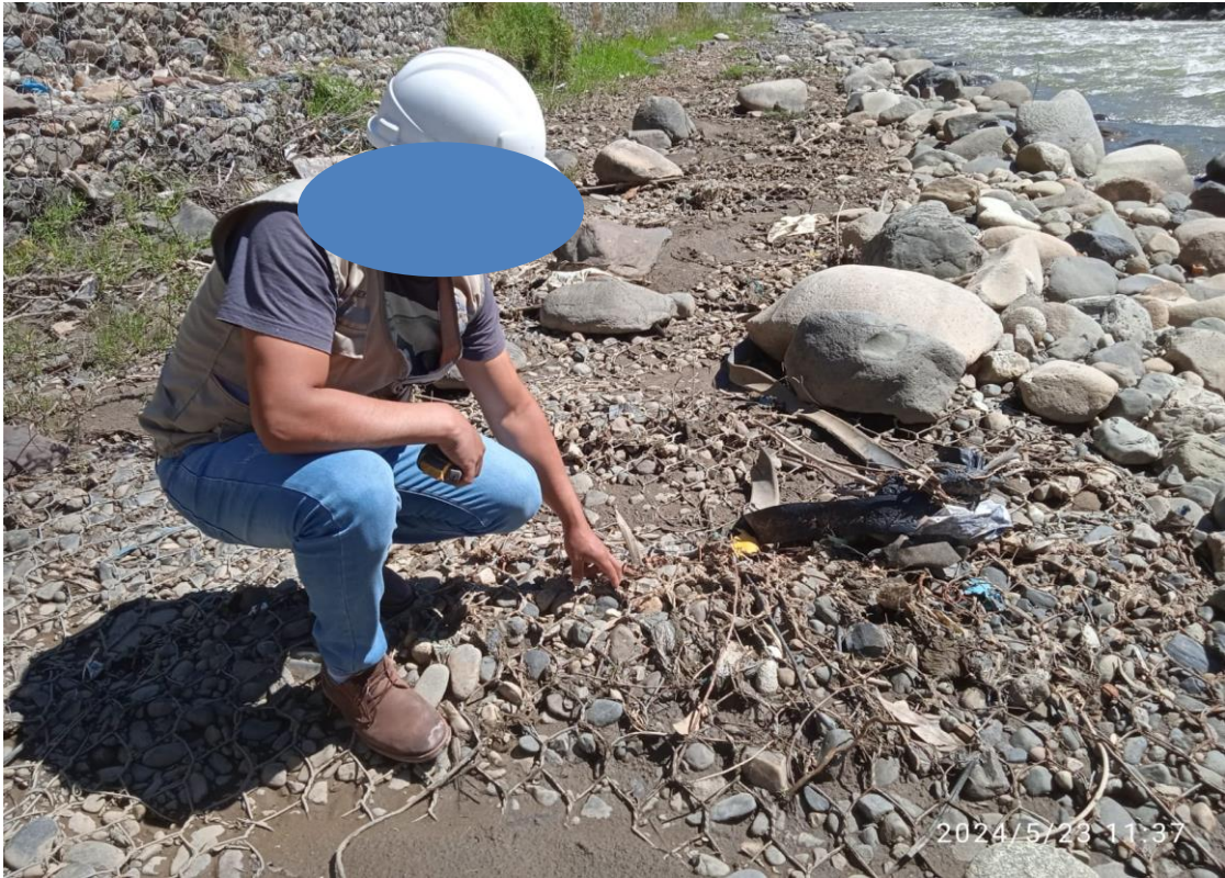
Figura 13: Evaluando las piedras del colchón reno Fuente: Evidencia de campo
