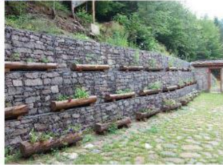
Figura 1. Estructura con gaviones. Fuente: http://www.solucionesespeciales.net/MedioAmbiente/Gaviones/Gaviones.aspx
