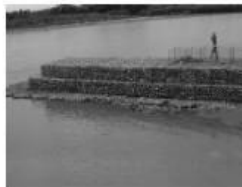
Fig. 9.20 Obra construida con gaviones CajaFuerte ®
