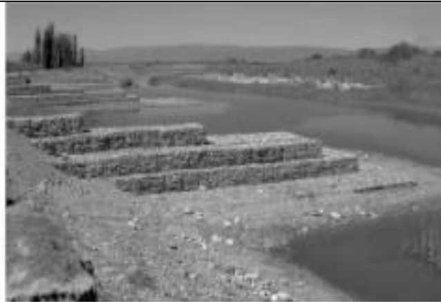
Fig. 9.5 Espigón en gaviones apoyado sobre una camada de piedras sueltas
