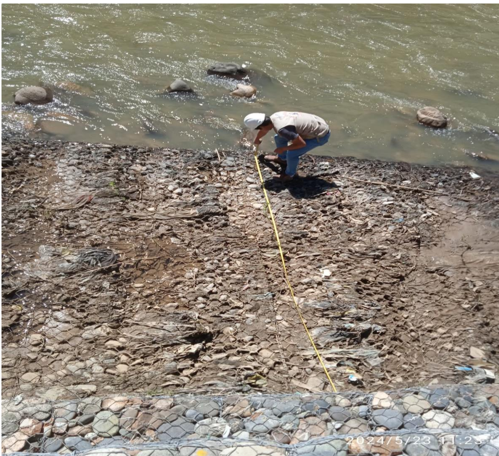
Figura 10: medidas del colchón reno Fuente: Evidencia de campo
