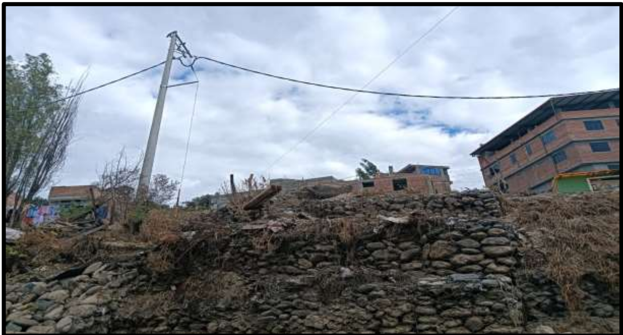
Figura 4: Evaluación del muro de gaviones del rio seco Progresiva 2+830 hasta 3+030.
