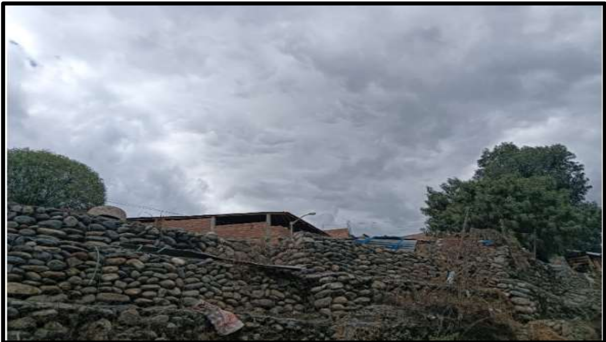
Figura 2: Evaluación del muro de gaviones del rio seco Progresiva 2+230 hasta 2+430.
