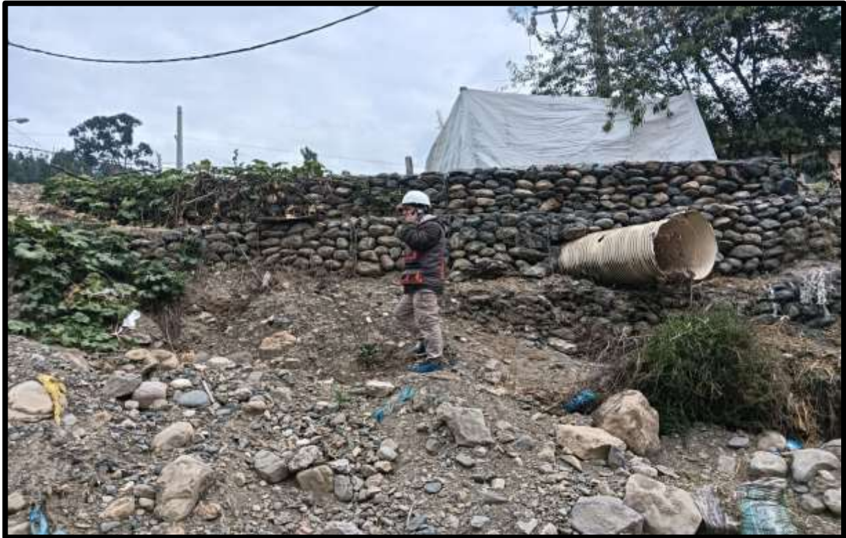
Figura 7: Vista acumulación de piedras en la malla del muro de gaviones del rio seco
