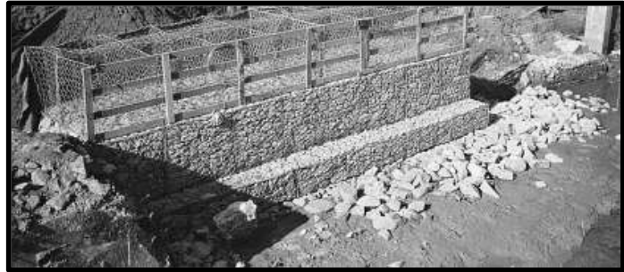
Figura 2. Proceso de construcción del gavión tipo caja
