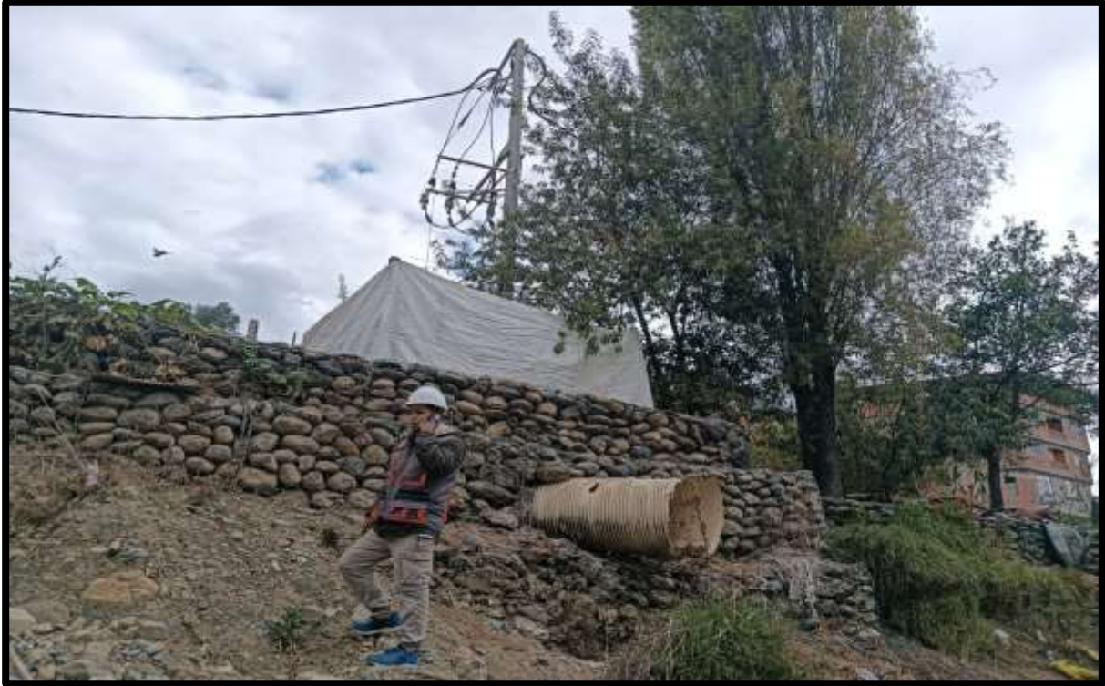
Figura 1: Evaluación del muro de gaviones del rio seco Progresiva 2+030 hasta 2+230.
