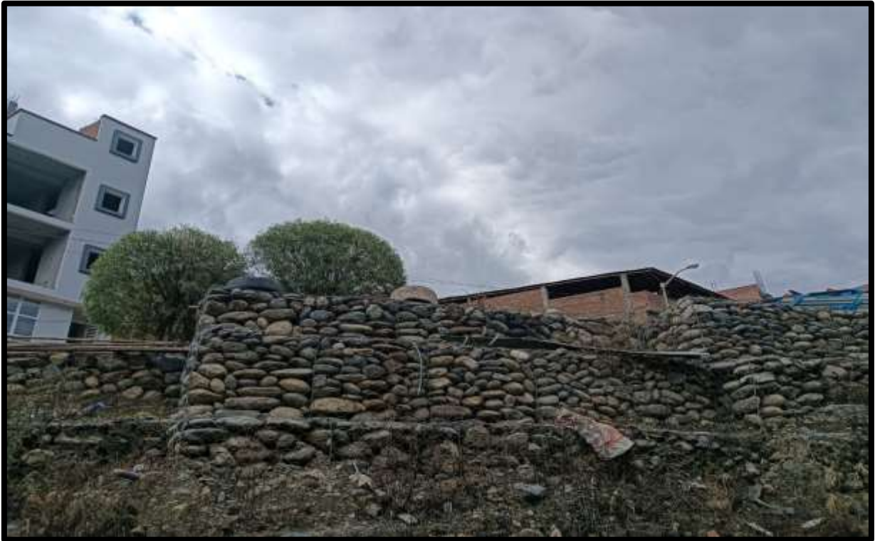
Figura 3: Evaluación del muro de gaviones del rio seco Progresiva 2+430 hasta 2+630.
