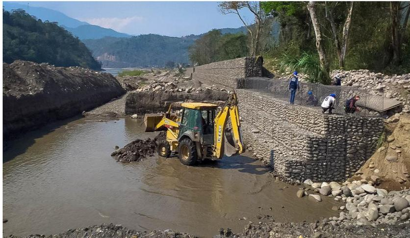
**Figura N° 2 Muro de gaviones**
