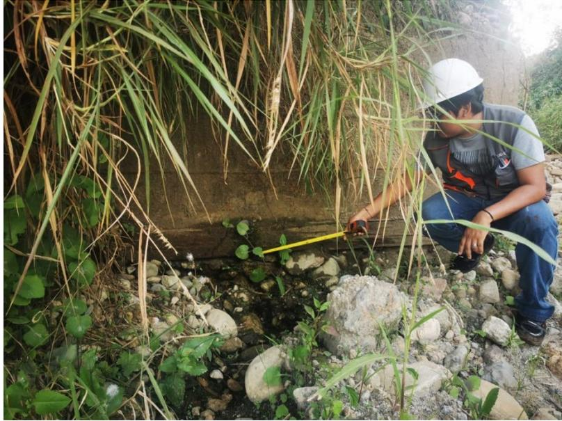
**Figura N° 20 Filtración y socavación en las bases del puente**
