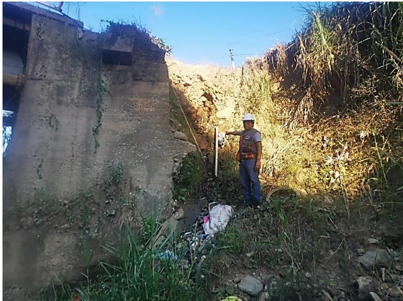
**Figura N° 23 Vegetación excesiva en el talud, margen derecho**
