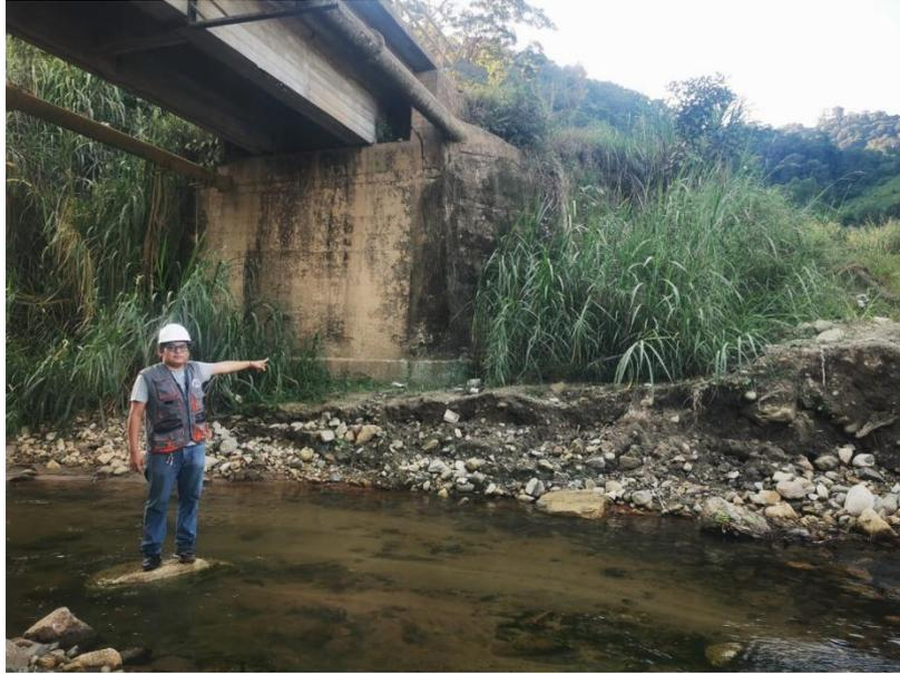
**Figura N° 18 Vegetación excesiva y residuo sólidos, margen izquierdo**
