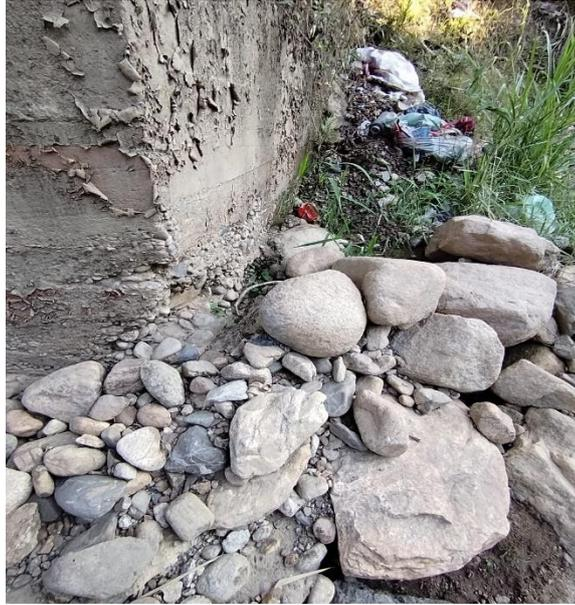
**Figura N° 22 Socavación y deterioro en las bases del puente**
