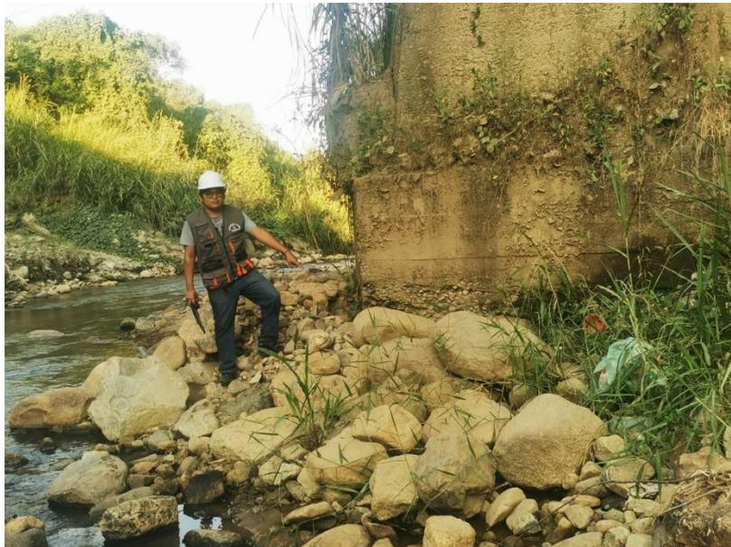
**Figura N° 21 Vegetación excesiva y socavación en las bases del puente**
