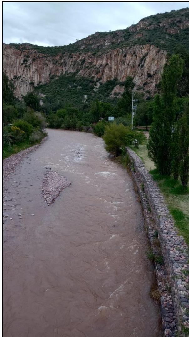
Figura 7: Vista del río Muyurina y del muro de gaviones existente. Fuente: Foto obtenida de campo
