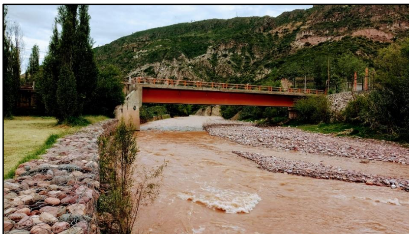
Figura 3: Vista general del muro de gaviones.
