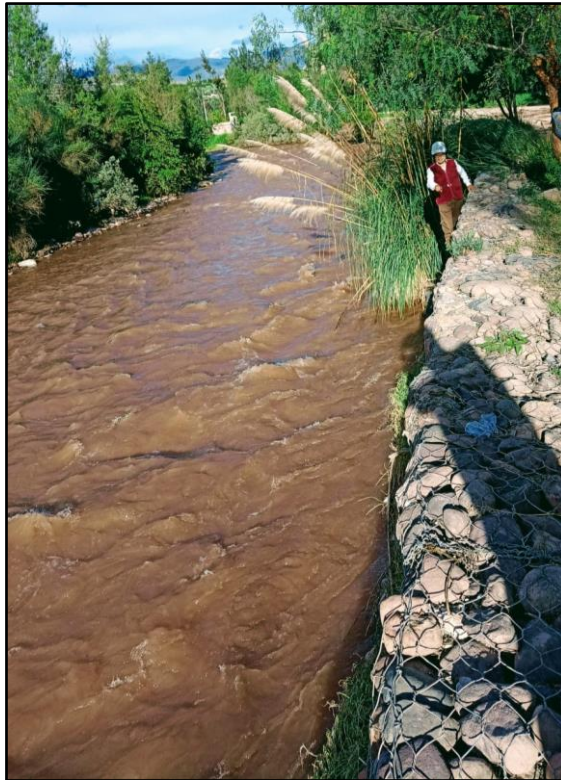
Figura 4: Realizando la evaluación y verificación de campo. Fuente: Foto obtenida de campo
