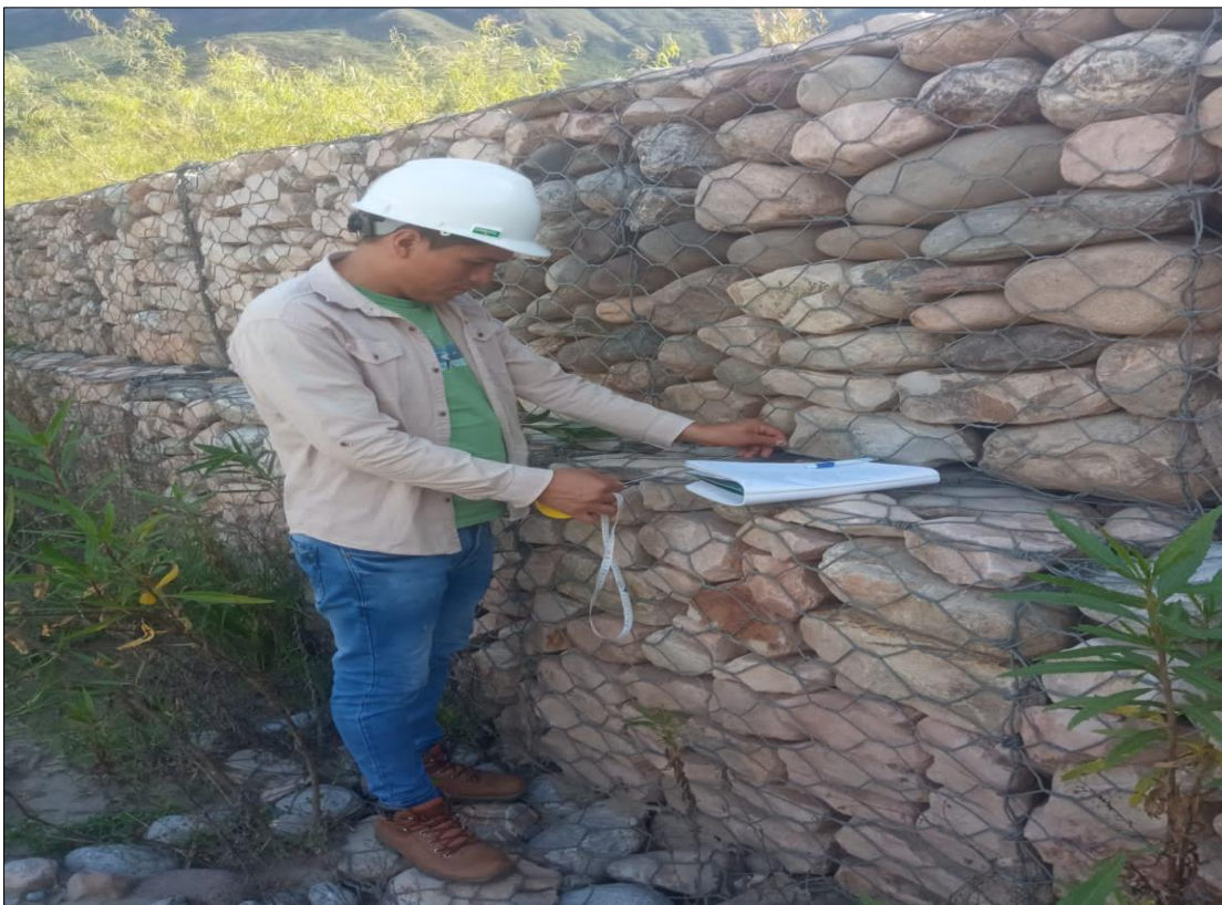
Foto 06: Se observa midiendo del muro de gaviones
