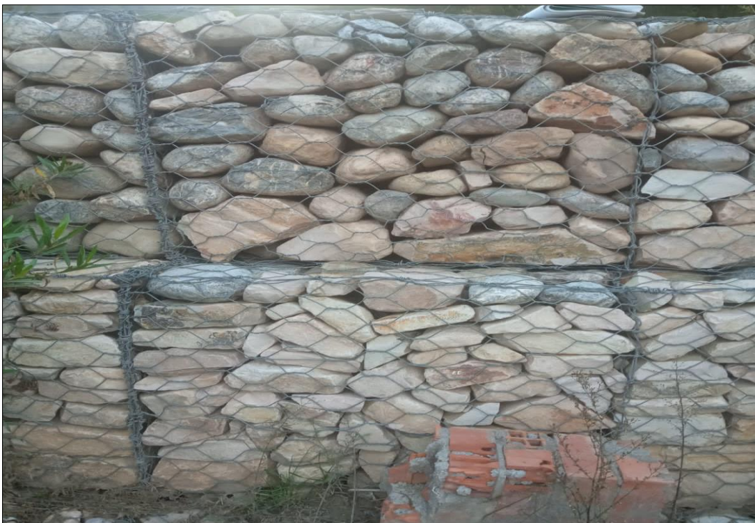
Foto 04: Se observa diferentes diámetros de los materiales empleados en el muro de gavión.
