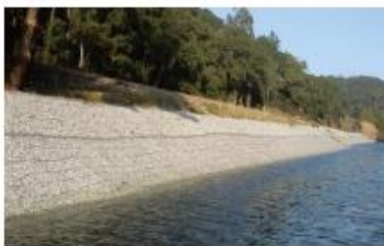
Figura 2. Gaviones para contención fluvial. Fuente:(A Bianchini, 2017).
