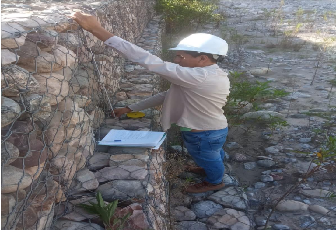
Foto 05: Realizando medidas de altura en el muro de gaviones
