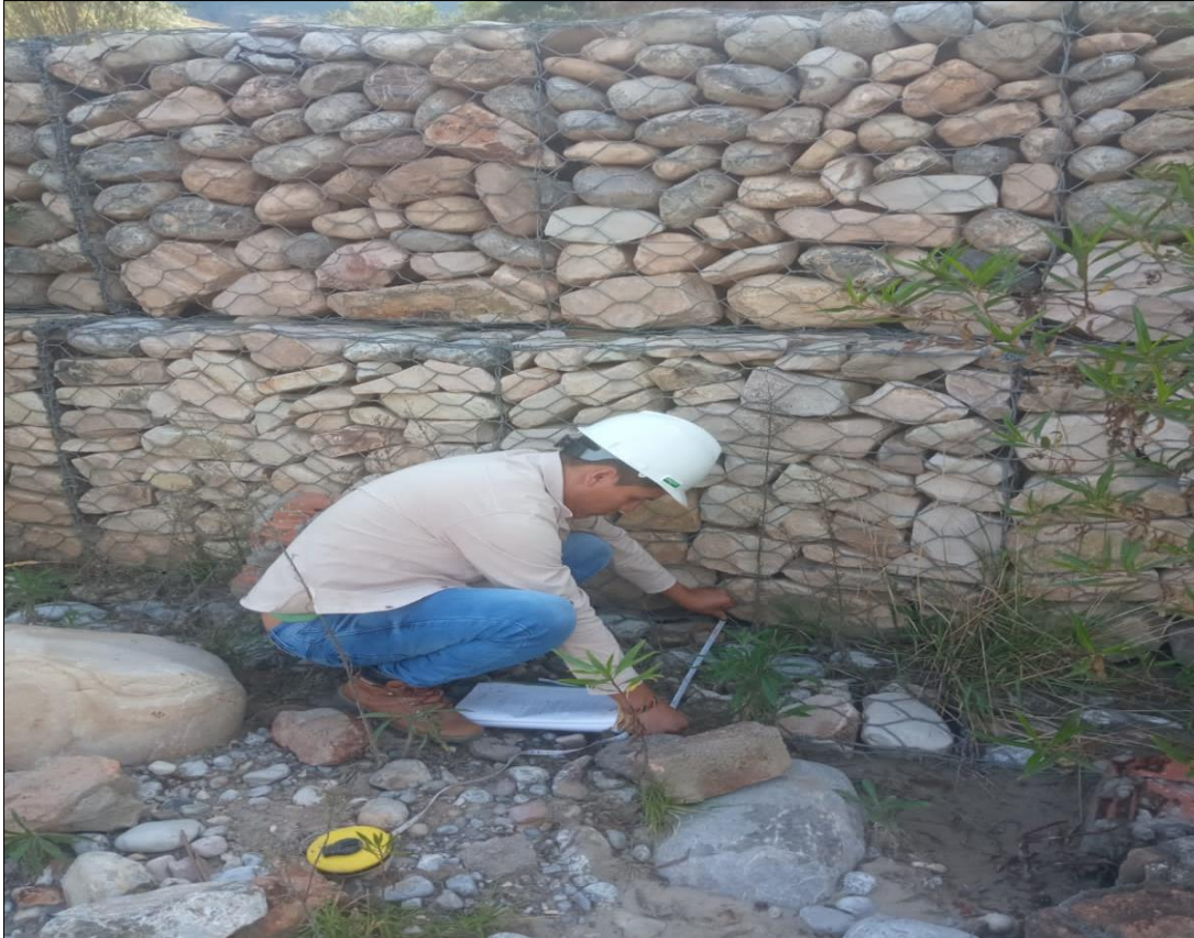
Foto 03: Se observa la medición del muro de gavión de ancho del colchon de la estructura.
