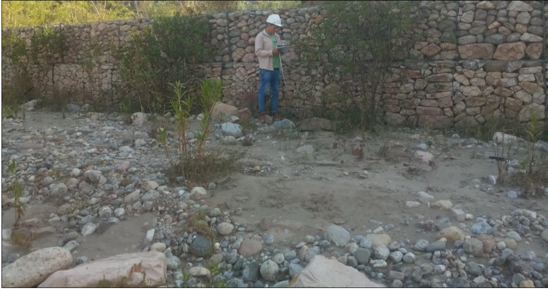
Foto 07: Se observa material acumulado ocasionado por las fuertes avenidas de las lluvias.
