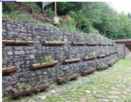
Figura 1. Estructura con gaviones. Fuente: http://www.solucionesespeciales.net/MedioAmbiente/Gaviones/Gaviones.aspx
