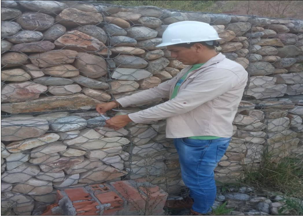
Foto 09: Realizando medidas del muro de gaviones
