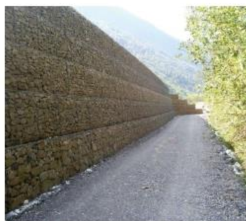
Figura 23. Muro de contención en carretera. Fuente: (A Bianchini, 2017)
