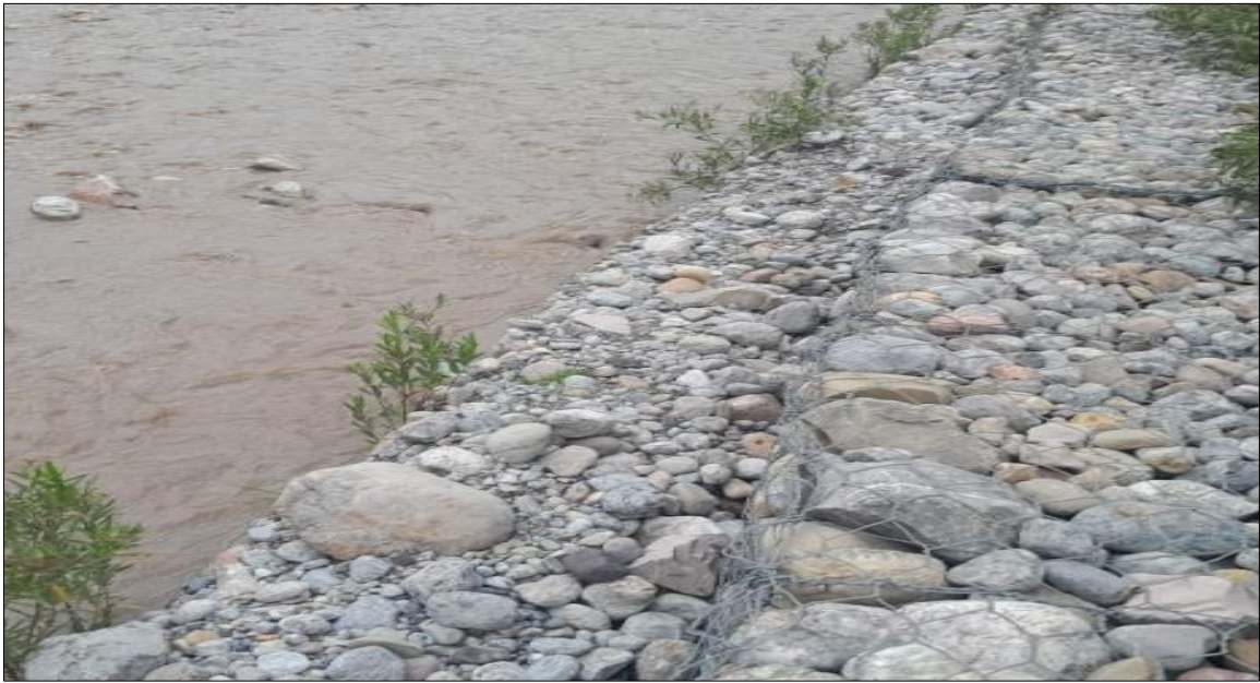
Foto 11: Se observa diferentes diámetros de los materiales empleados en el muro de gavión.
