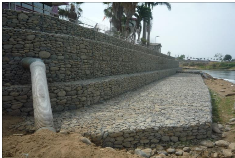
Figura 05: Estética en los muros de gaviones.
