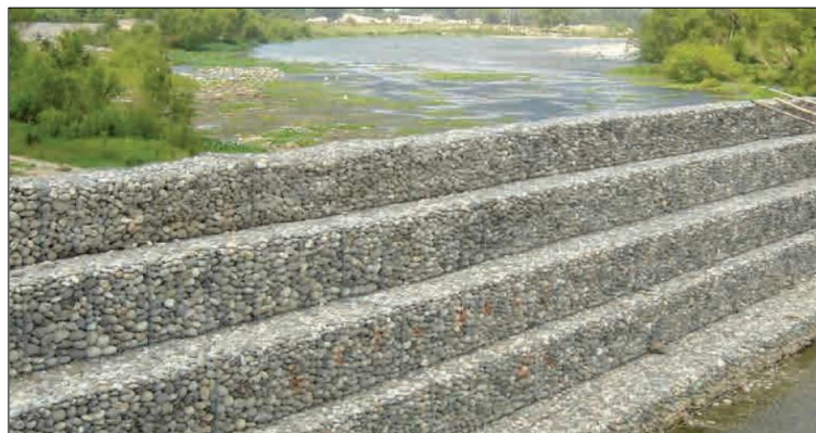
Figura 08: flexibilidad de muros de gaviones.
