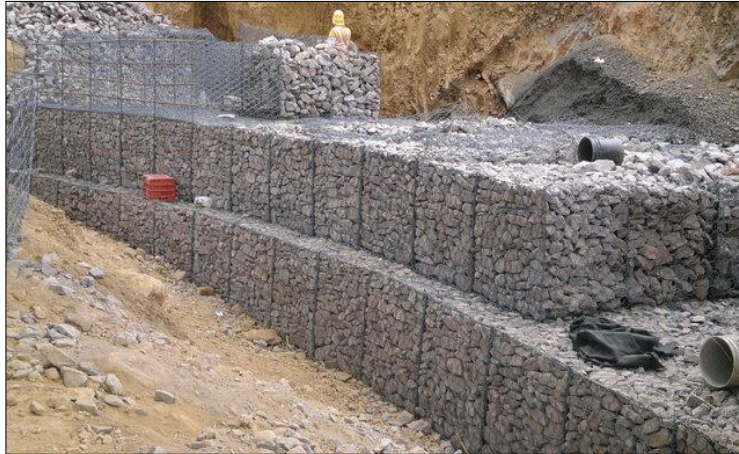
Figura 06: Mano de obra no especializada para el armado de gaviones
