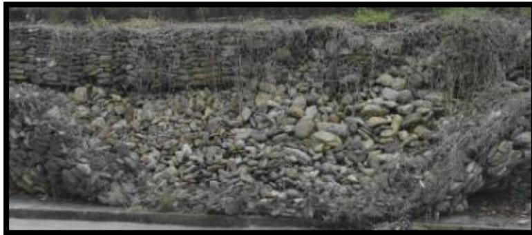
*Figura N.º 17: Ejemplo de rotura de gavión*
