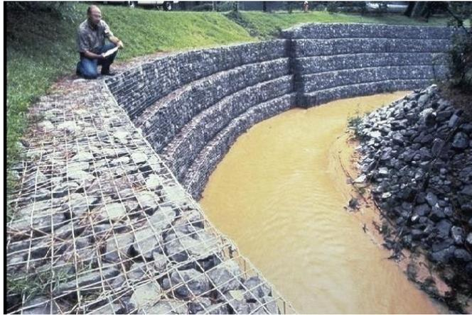
*Figura N.º 02: Muro de gaviones*
