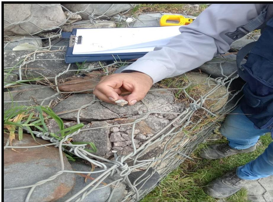
**Figura N.º 47: Descomposición del relleno en alguno tramos**
