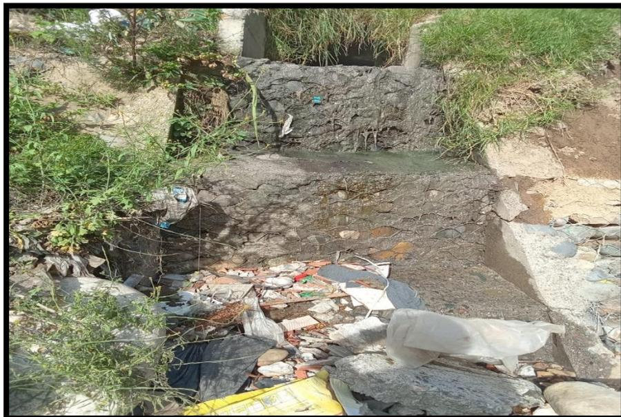
**Figura N.º 45: Canal pluvial con basura**
