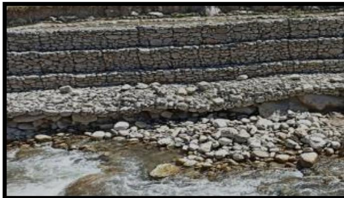
*Figura N.º 15: Ejemplo de socavación*
