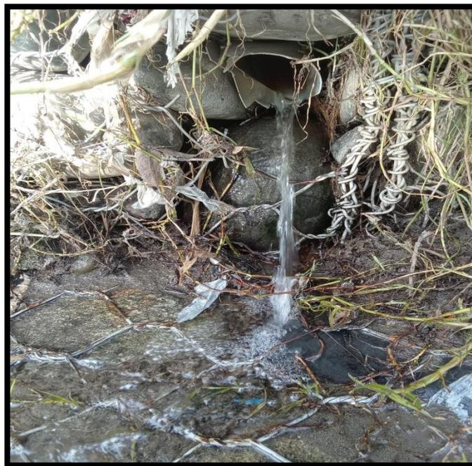
*Figura N.º 49: Rotura de la malla, tubo de filtración rota*
