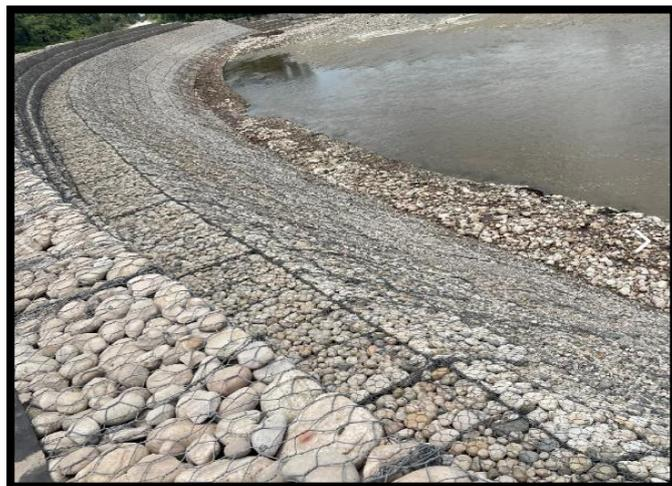
*Figura N.º 05: Muro de gavión tipo colchón*
