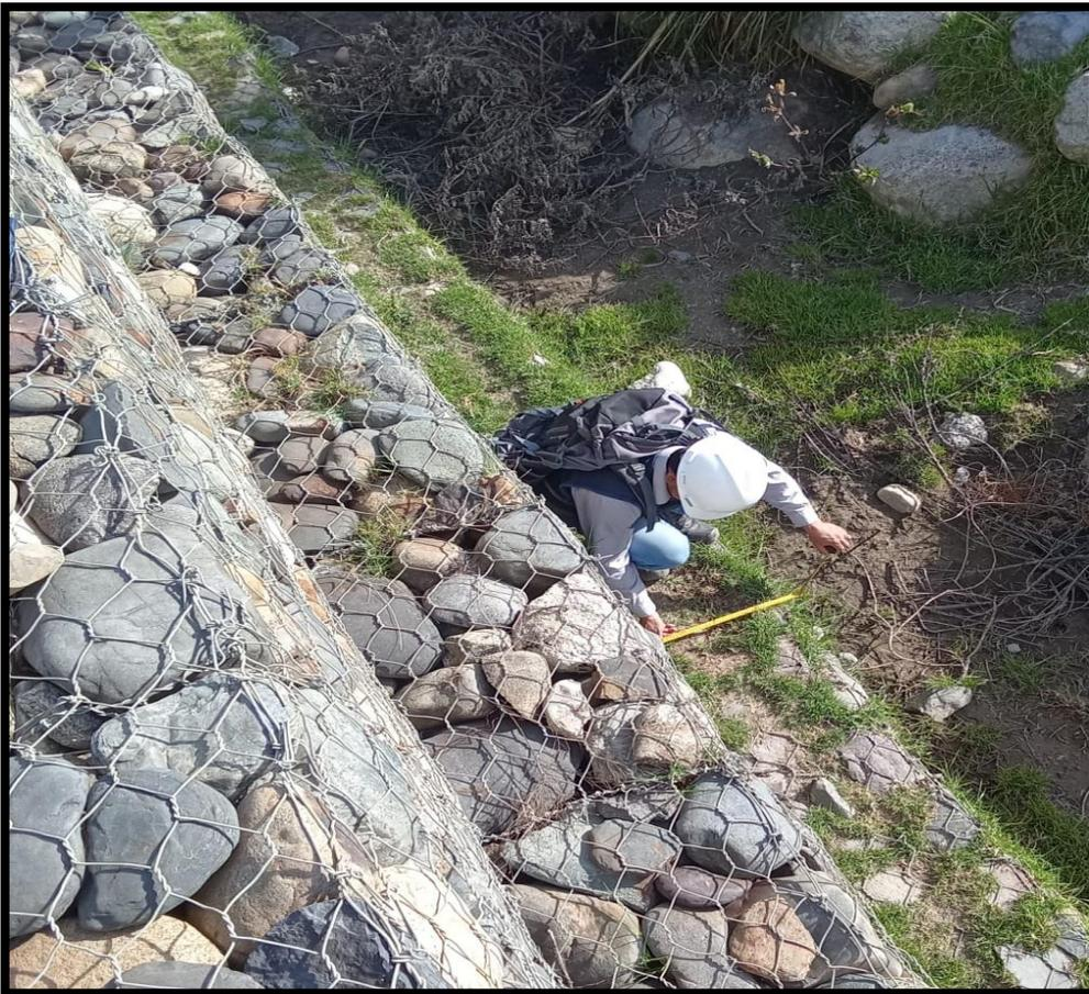
**Figura N.º 32: Presencia de vegetación en el tercer nivel**
