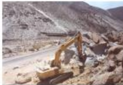
Fig. N° 04: Extracción de roca sin explosivo
