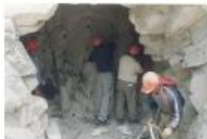
Fig. N° 05: Extracción de roca con explosivos
