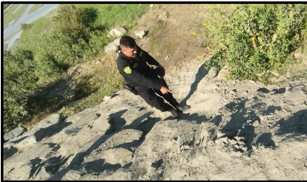
Figura 24: Fotografía en la defensa ribereña, inicio del tramo km 9+900.
