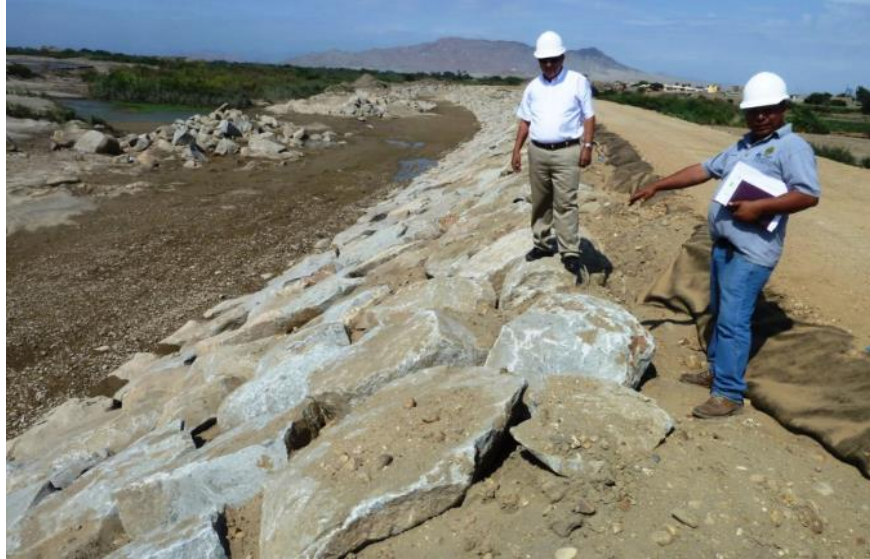
Figura 04: Enrocado en la Ciudad Eten
