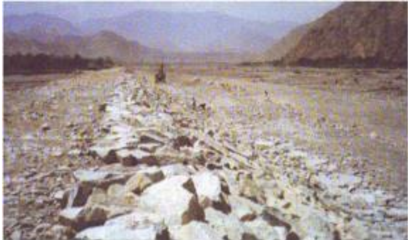
Figura 05: Enrocado colocado al volteo
