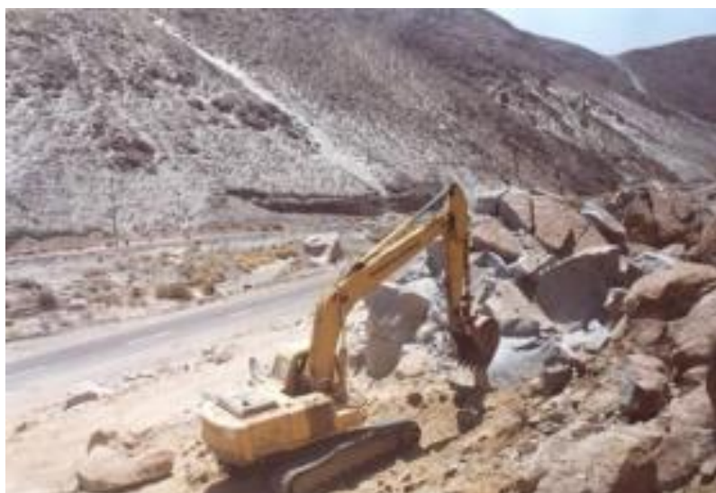
Figura 06: Extracción de rocas sin explosivos
