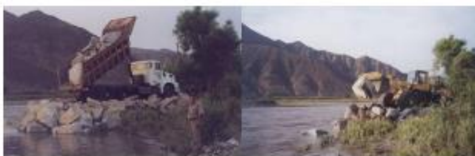
Fig. N° 10: Conformación de defensas ribereñas
