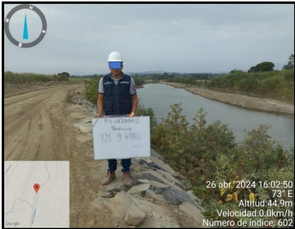
Figura 25: Fotografía en el enrocado, tramo km 9+950.
