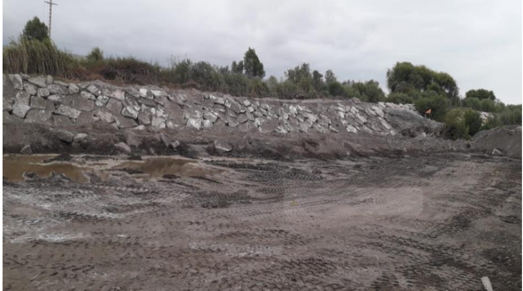
Figura 01: Evaluación de enrocado en el Rio Tambo
