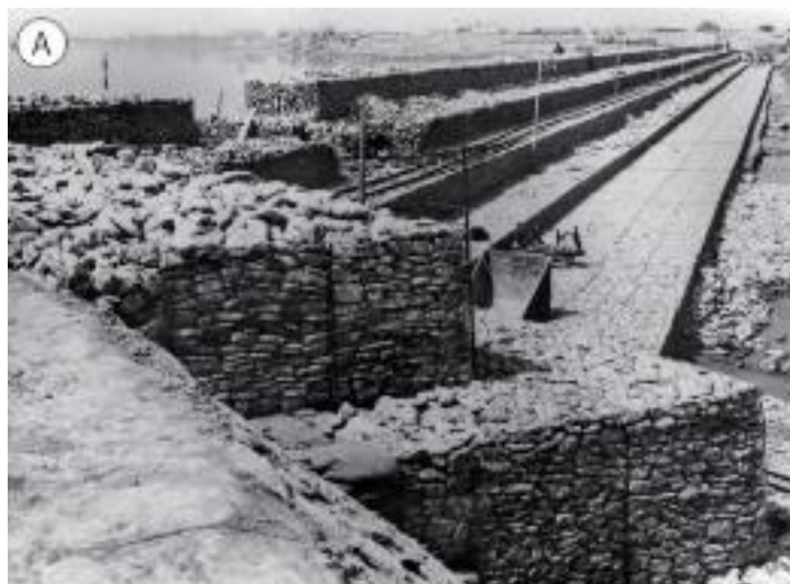
Figura 18: Terminado con Gaviones
