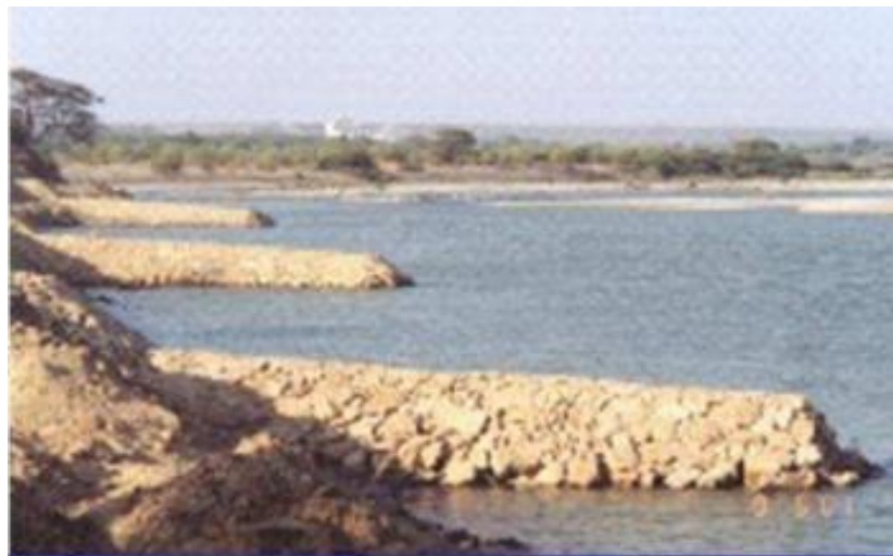
Figura 16: Espigones en el río Chira
