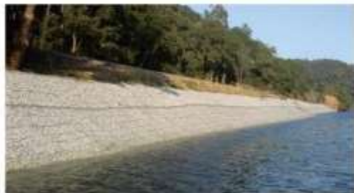
Figura 2. Gaviones para contención fluvial. Fuente: (A Bianchini, 2017).
