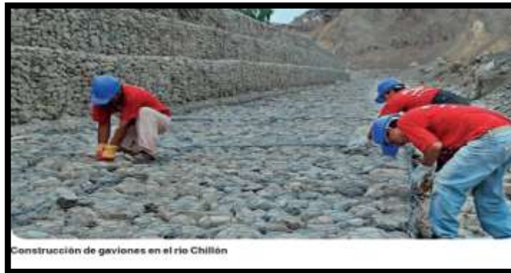
Figura 4. Defensa ribereña, muro de gaviones.
