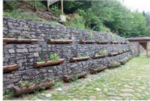
Figura 1. Estructura con gaviones. Fuente: http://www.solucionesespeciales.net/MedioAmbiente/Gaviones/Gaviones.aspx
