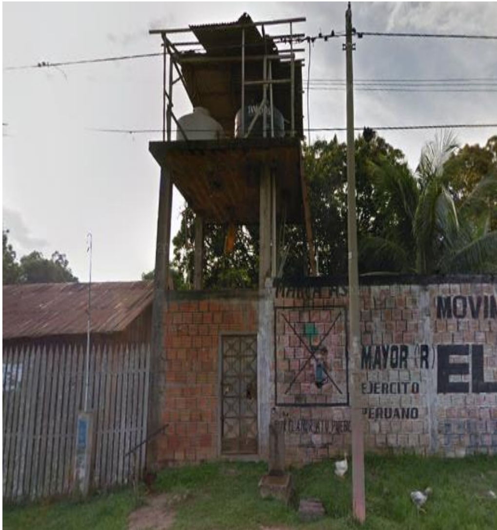
Imagen 01. Vista de la estructura del tanque elevado y captación (pozo).
