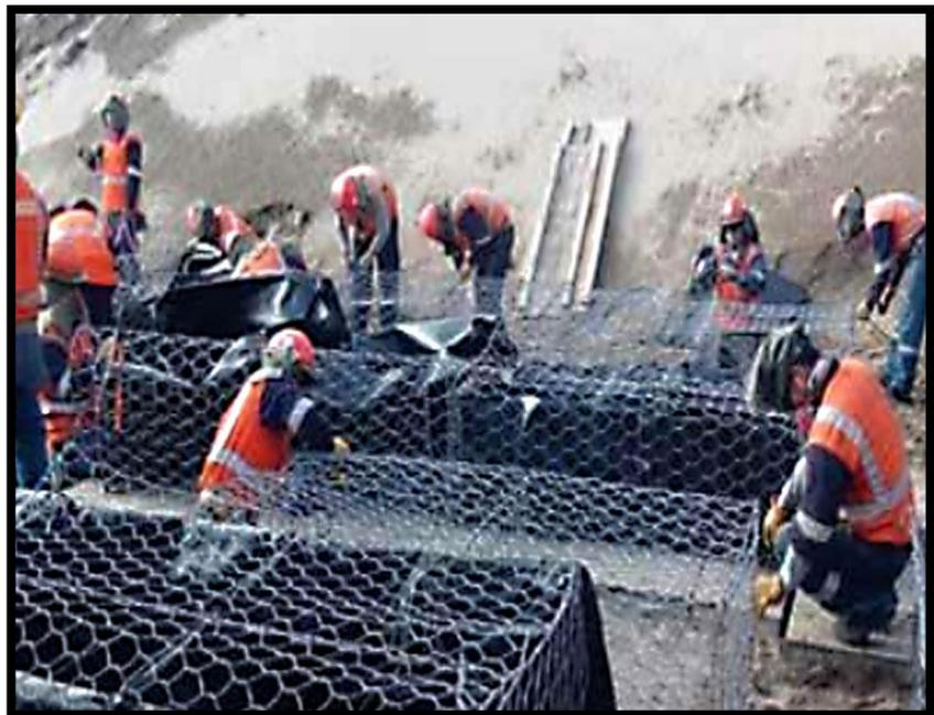
**Figura 10.** Geotextiles en la construcción de muro de gaviones.
