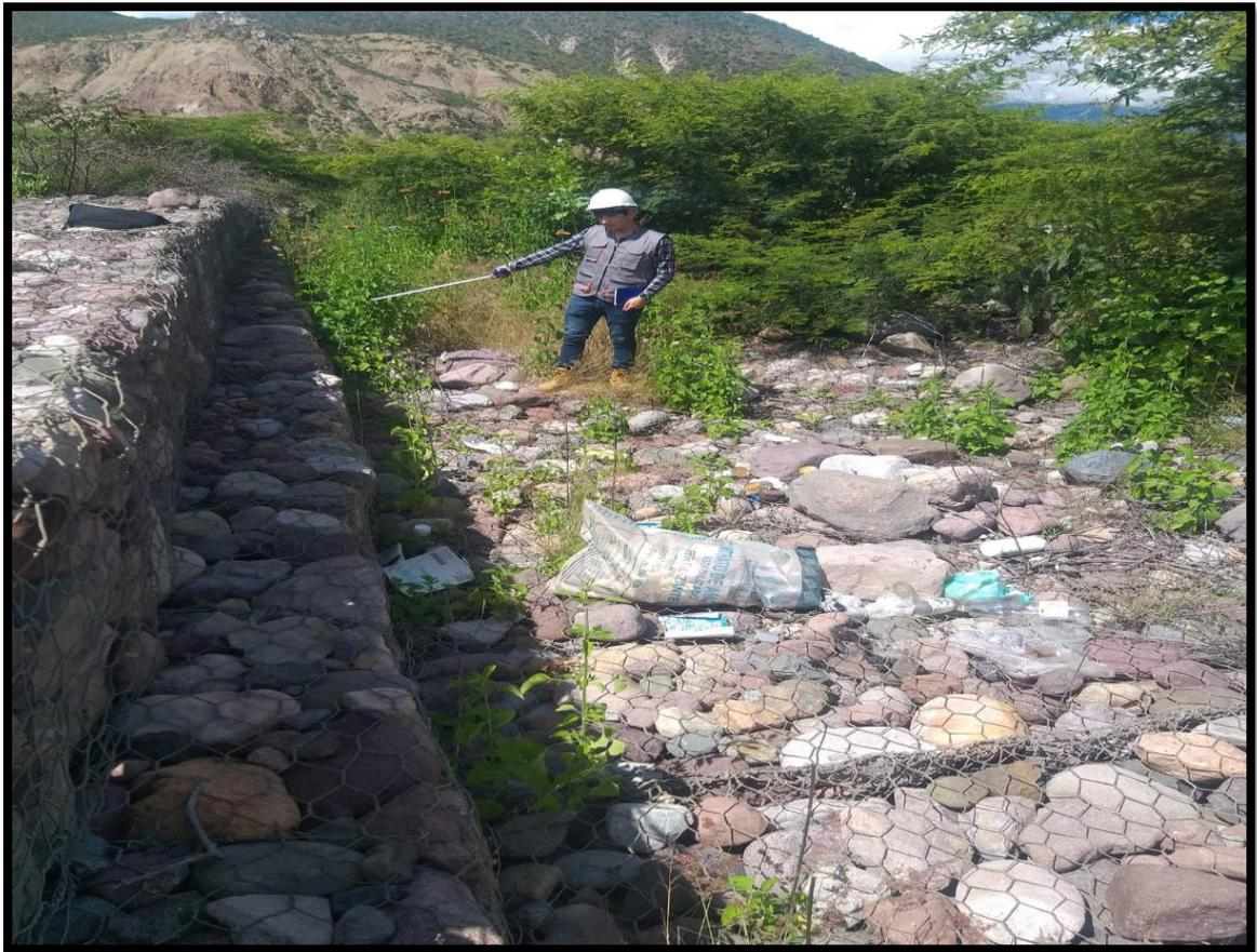
**Figura 37.** Hacinamiento de basura y el desalineamiento del muro.
