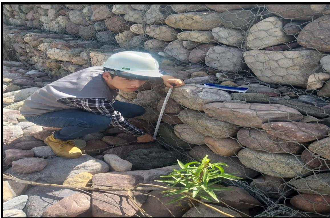
**Figura 41.** Altura del segundo nivel 0.65 cm.
