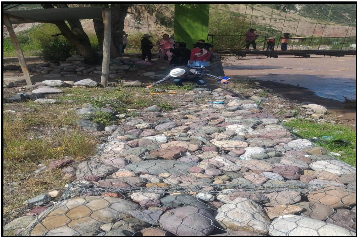
**Figura 48.** Último tramo del muro de gaviones 0+800
