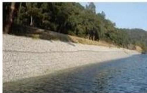
Figura 2. Gaviones para contención fluvial. Fuente: (A Bianchini, 2017).
