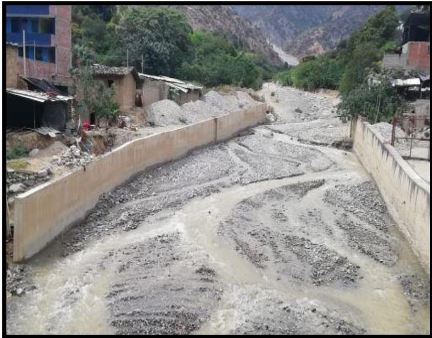
**Figura 12.** Muros de contención.
