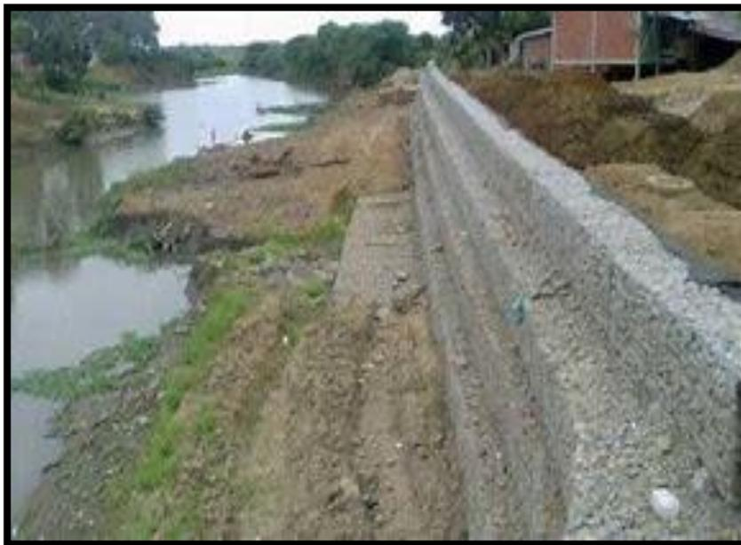
**Figura 15.** Muro de gaviones.
