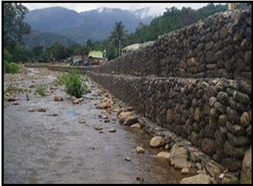
**Figura 11.** Defensa ribereña, muro de gaviones.
