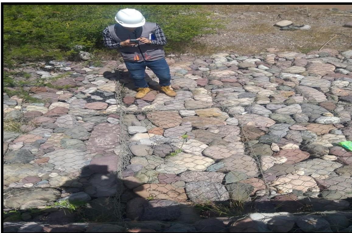
**Figura 42.** Rotura de las mallas en el colchón de reno
