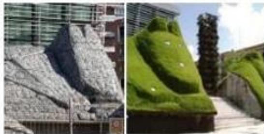
Figura 24. Antes (izquierda) y después (derecha) de una estructura construida con gaviones. Fuente: (A Bianchini, 2017)
