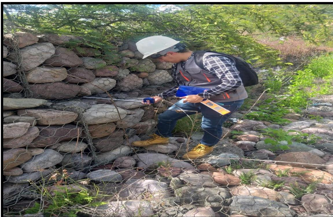
**Figura 44.** Mala colocación del relleno y la deformación .
