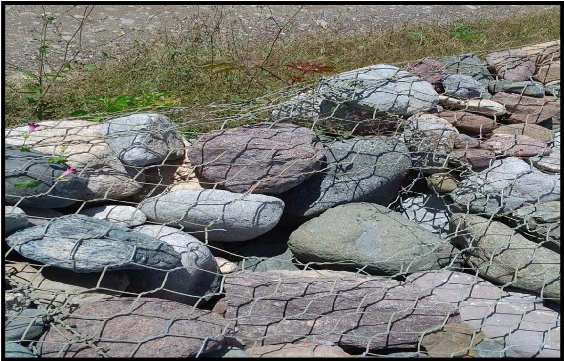
**Figura 47.** Rotura de malla y pérdida de relleno
