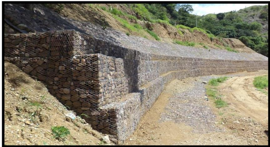
**Figura 4.** Muro de gaviones.
