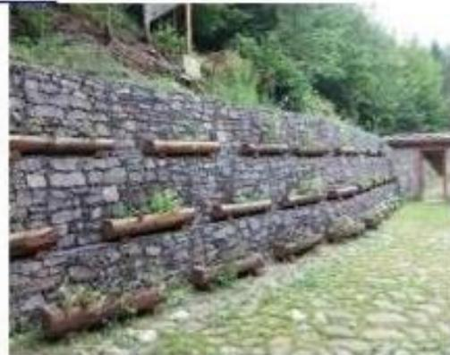
Figura 1. Estructura con gaviones. Fuente: <http://www.solucionesespeciales.net/MedioAmbiente/Gaviones/Gaviones.aspx>
