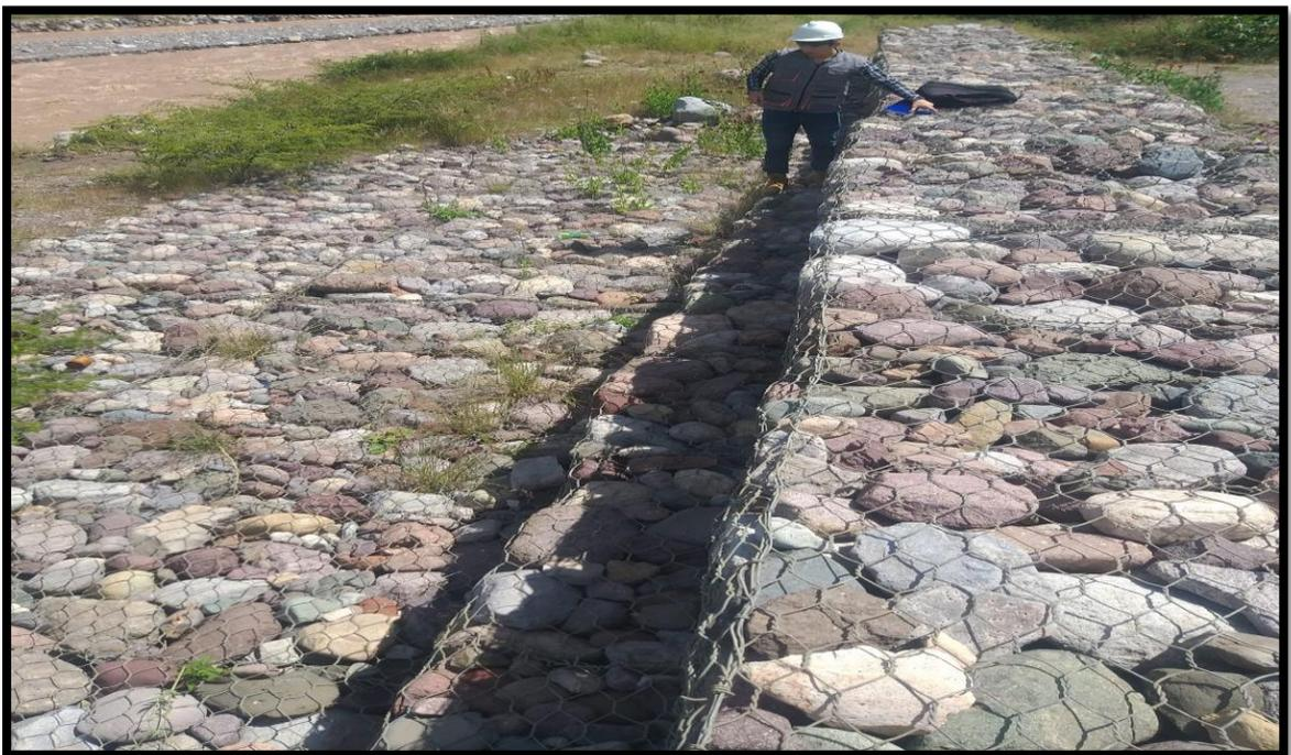
**Figura 50.** Tramo inicial del muro de gaviones
