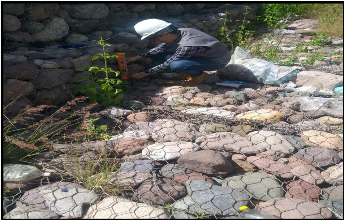
**Figura 46.** Desnivel en el 2 nivel de la estructura tramo 0+150
