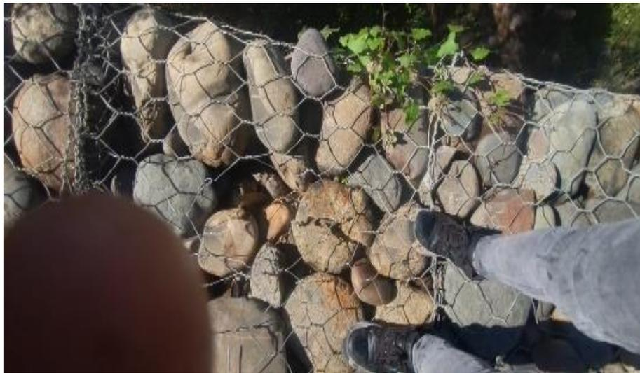
**Figura 7:** Se visualizo la rotura de malla galvanizada en 2+180
