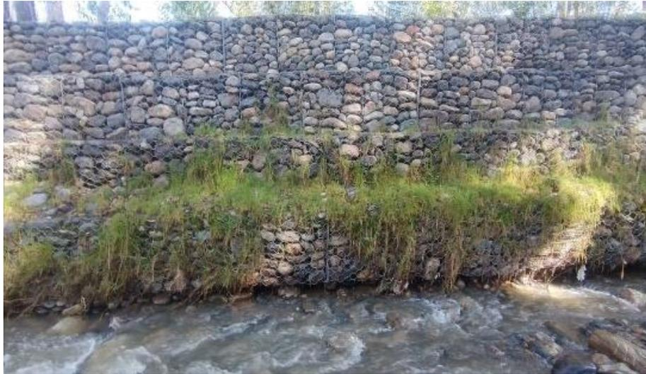
**Figura 6:** Riesgo por socavación en la progresiva 2+090
