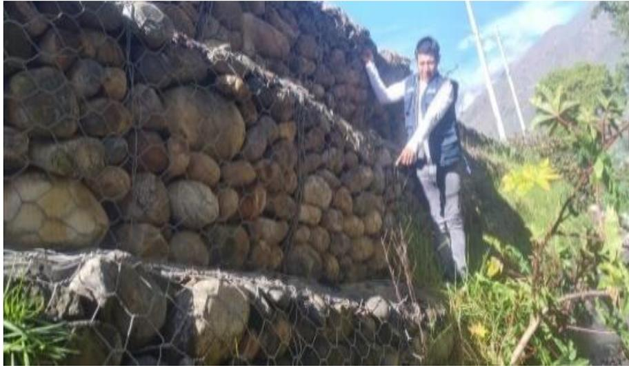
**Figura 8:** En progresiva 2+250 a 2+280 hay deformaciones de muro.
