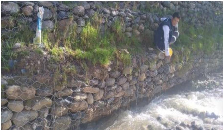
**Figura 9:** En esta progresiva de 2+380 , se ha identificado socavación
