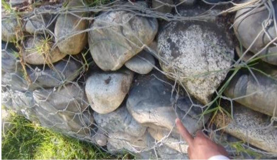
**Figura 10:** Se observo rotura y deformación en 2+420
