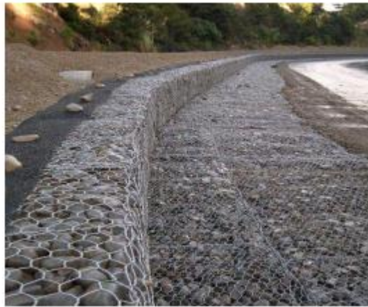
Figura 7 colchones de gavión (24)
