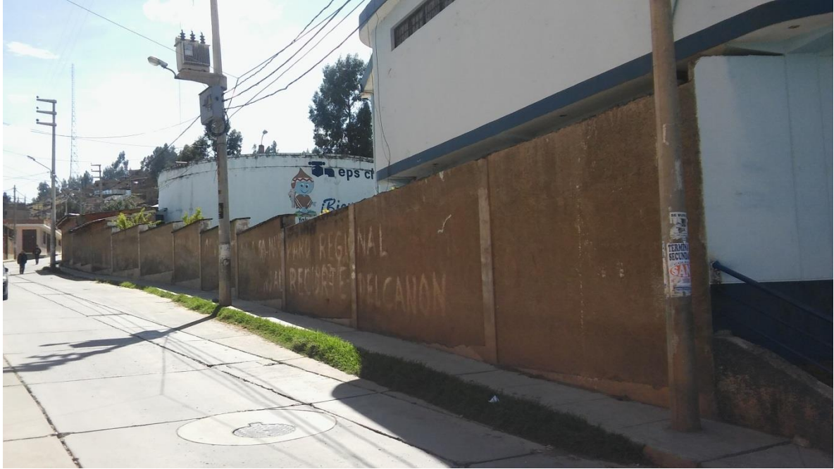
VISTA DEL LADO NORTE DEL EPS CHAVIN S.A.
