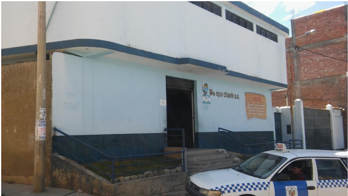
FACHADA DEL EPS CHAVIN S.A. DE HUARAZ
