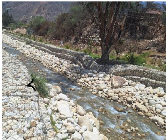
Colapso de la estructura de gavión tipo caja, producto de falla de su estabilidad, por socavación de su base en el gavión tipo colchón, se evidencia los trabajos realizados de limpieza del río colocando las rocas en los bordes, pero aun así viene presentándose una inclinación de la estructura afectada ocasionando un efecto en cadena hacia las demás estructuras.
