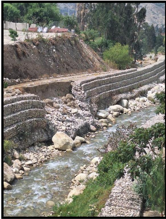
**Fotografía 9:** Constatando los derrumbes de la estructura.
