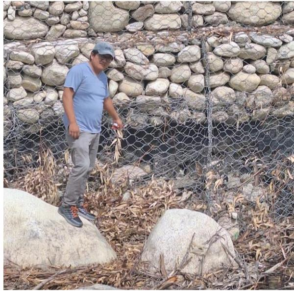
El colchón tipo reno colocado sin la excavación necesaria, y en muchas partes se han perdido todo el relleno por tramos de 10 y 15 metros de longitud, esto debido a que en muchas partes se han utilizado rellenos con diámetro menor a lo que corresponde en gaviones tipo colchón, es por ello que en crecidas de las aguas del río se llevó todo el relleno de la estructura, provocando así vacíos en la base que están ocasionando la inclinación de toda la estructura.
