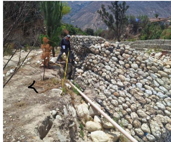
Tramo de derrumbe de 25m de longitud, esto debido a la fuerte inclinación que se viene dando en esta parte del muro de gavión producto de la socavación en la base donde se encuentra el colchón antizocavante, donde una parte de 8 m colapso y otros 17 m ya se encuentra casi colapsado y 5 metros atrás ya se encuentra con una inclinación de 0.5 m.
