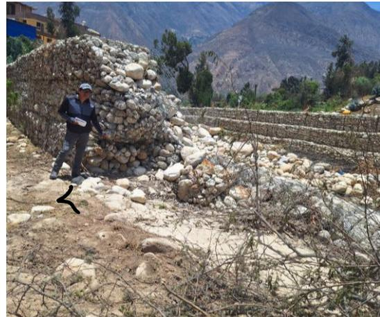
Tramo de derrumbe de 20m de longitud, esto debido a la fuerte inclinación que se viene dando en esta parte del muro de gavión producto de la socavación en la base donde se encuentra el colchón antizocavante, que se encuentra visible ya que se encuentra por encima del nivel del río, la cual está ocasionando problemas graves a la estructura del muro, que por lo que se ve todo el muro a perdido la formación estable por que se muestra con inclinación hacia adentro en la parte del río.
