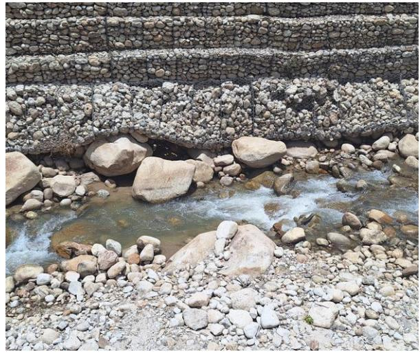
Daños que viene siendo afectado casi toda la estructura del gavión tipo colchón donde muchos tramos se ven perdidas de su relleno debido a socavación que estos presentan, ocasionando así que los gaviones tipo caja también se vean afectados, perdiendo su estabilidad siendo arrastrado hacia adentro provocando una inclinación y conllevando en un corto periodo a un derrumbe de la estructura.
