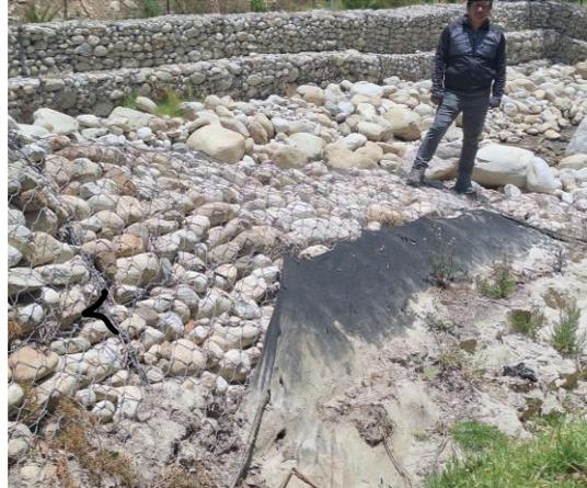
Colapso de la estructura por un tramo de 23 metros donde se evidencia que su estabilidad no es óptima debido a la socavación afectada en la base dañando al gavión tipo colchón.
