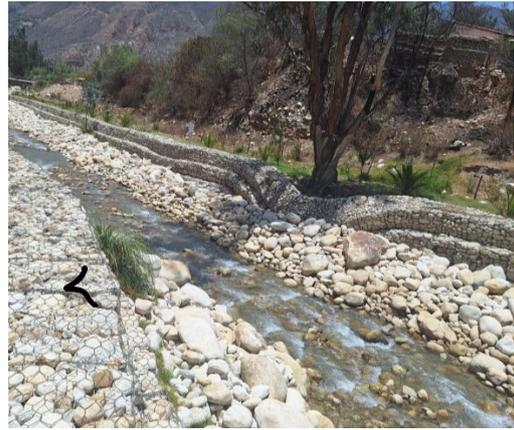
Colapso de la estructura de gavión tipo caja, producto de falla de su estabilidad, por socavación de su base en el gavión tipo colchón, se evidencia los trabajos realizados de limpieza del río colocando las rocas en los bordes, pero aun así viene presentándose una inclinación de la estructura afectada ocasionando un efecto en cadena hacia las demás estructuras.
