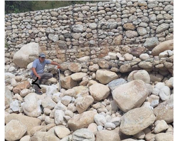
La socavación está provocando el desmoronamiento de la estructura de todo el muro de gaviones, por perder estabilidad este viene cediendo su carga hacia adentro, arrastrando así a todo el muro que poco a poco va incrementando su inclinación, por lo que se tiene que en un corto periodo todo este tramo también colapsara, ocasionando un derrumbe.
