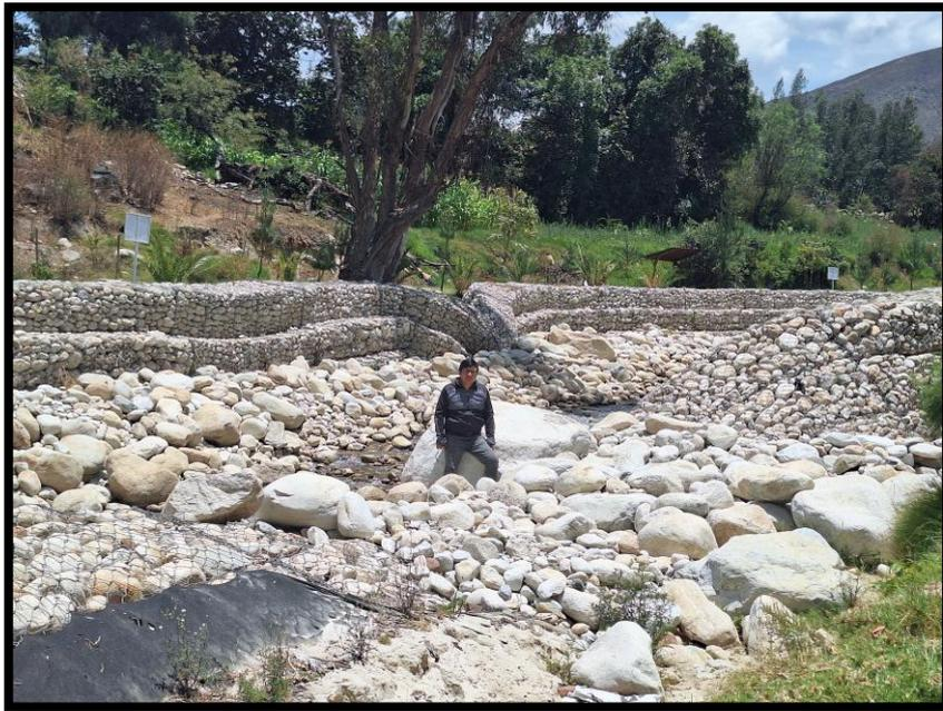
**Fotografía 11:** Constatando los derrumbes de la estructura.
