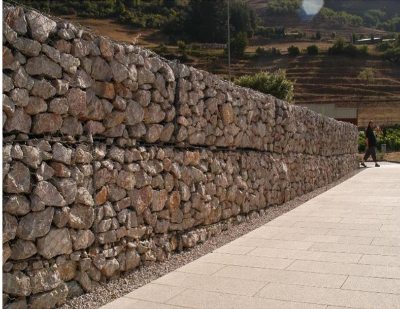
**Figura 1:** Muro de Gavión
