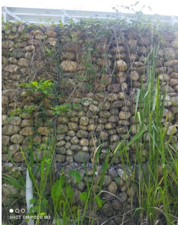
Figura 23: Malezas sobre el muro de gavión
