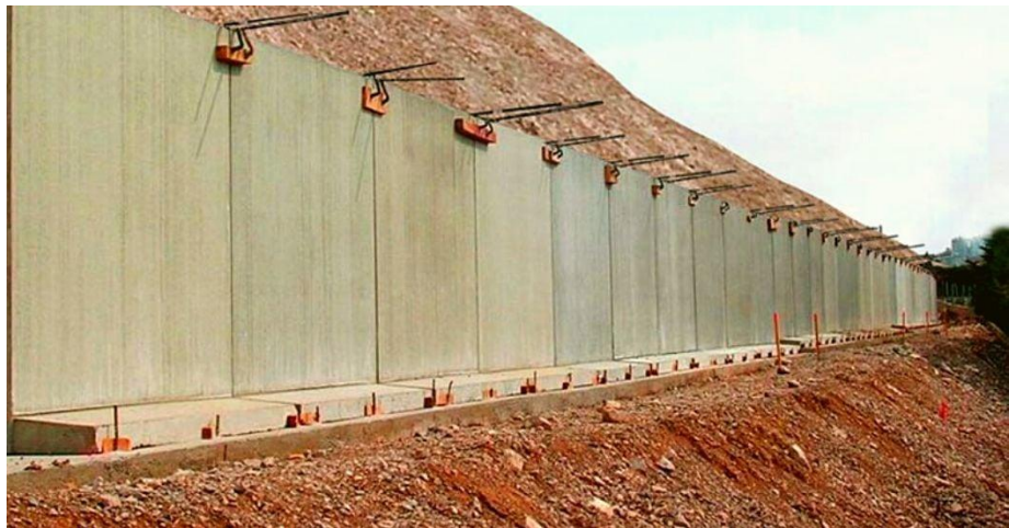
Figura 6: Conservación de un muro de contención
