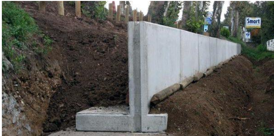
Figura 1: Uso de un muro de contención
