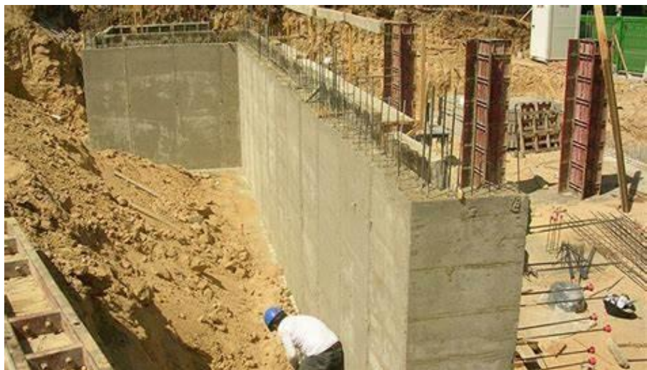
Figura 5: Refuerzo de un muro de contención
