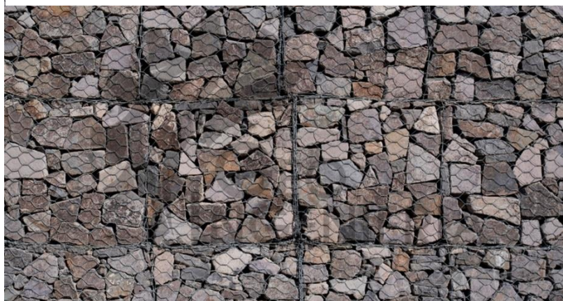
Figura 5 Muro de gaviones
