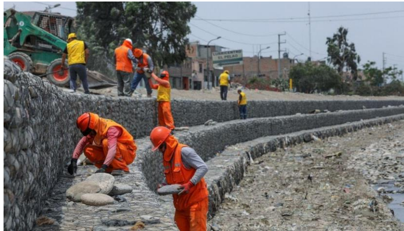
Figura 3 Construcción de Defensas ribereñas en el Perú
