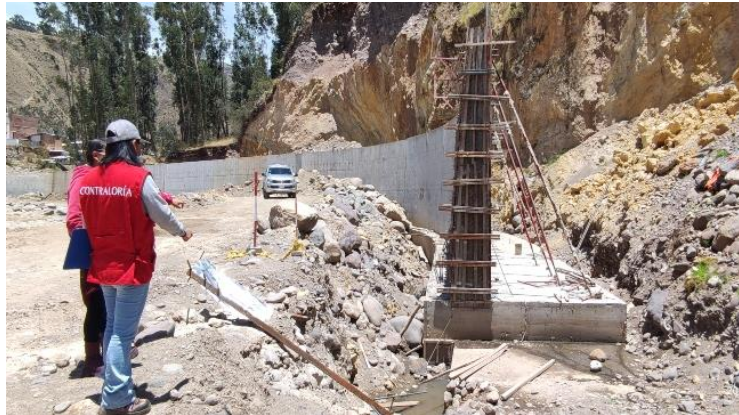
Figura 4 Muro de contención en el río Sicra
