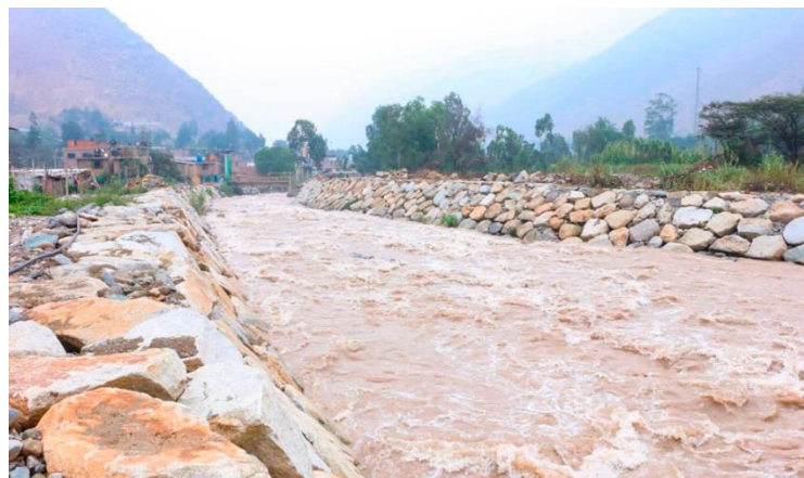
Figura 7 Defensa ribereña con enrocado en los ríos Santa Eulalia y Rímac
