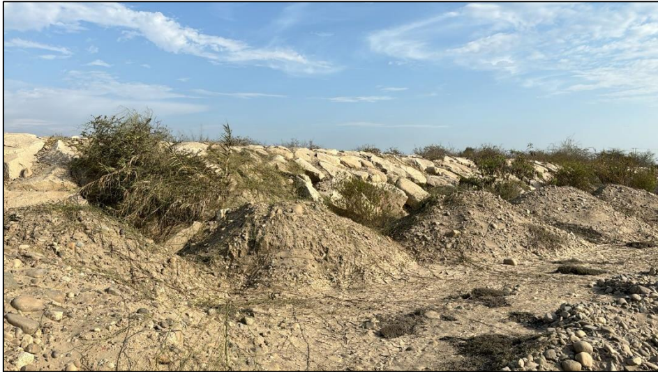
Figura 24: Desmante y desprendimiento de rocas Fuente: Elaboración propia 2024
