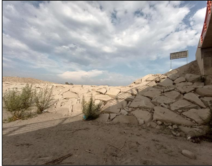
Figura 16: Tramo inicial del enrocado
