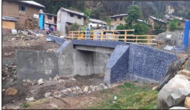
Figura 9: Muros de Contención Fuente: Tesis de Mayo y Pacheco (22)
