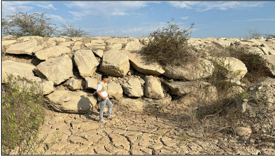
Figura 25: Deterioro del enrocado Fuente: Elaboración propia 2024
