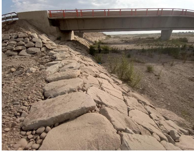
Figura 18: Estado de la corona del enrocado Fuente: Elaboración propia 2024
