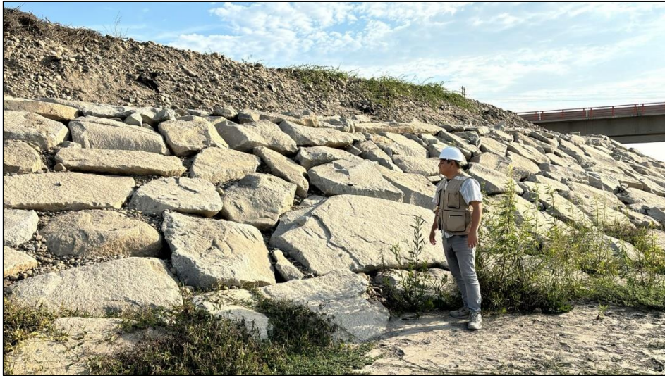
Figura 20: Evaluando el enrocado en el inicio de la progresiva 0+700 km Fuente: Elaboración Propia 2024
