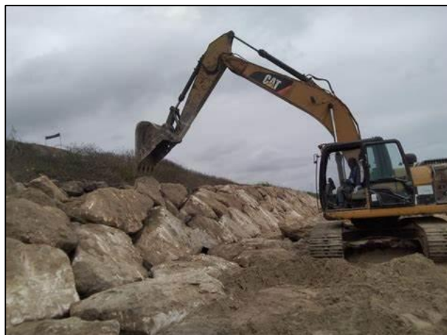
Figura 12: Construcción del enrocado
