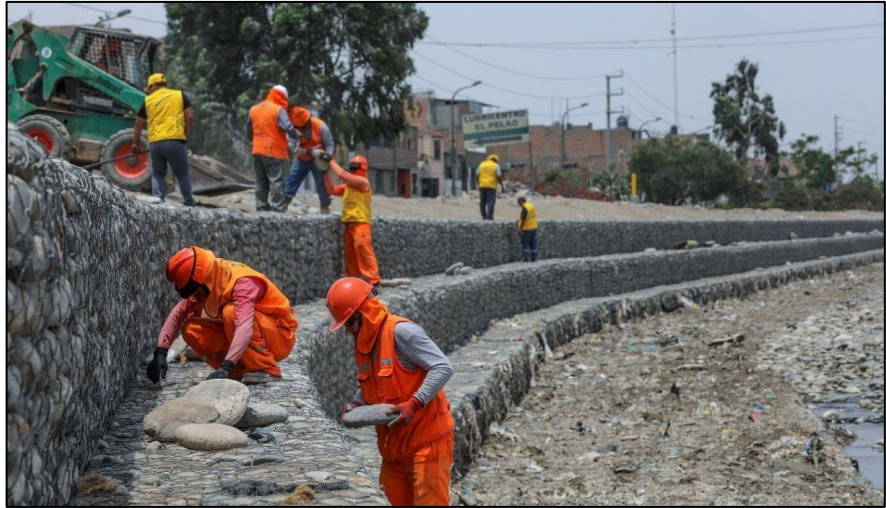
Figura 4: Construcción de la defensa ribereña – Muro de Gaviones
