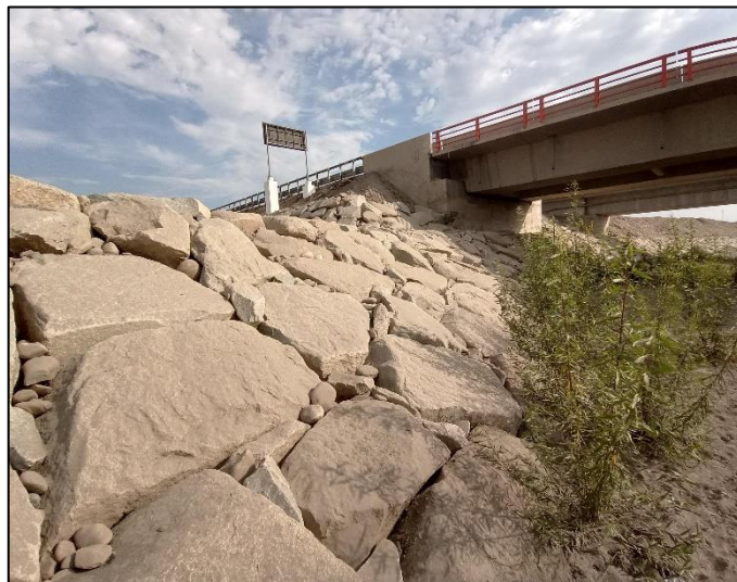
Figura 17: Relleno en el enrocado, tramo 0+700
