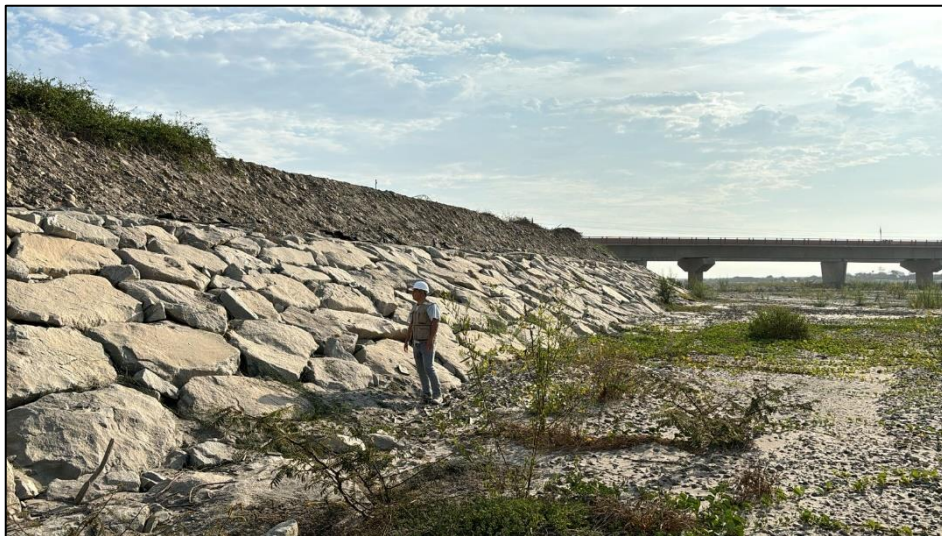
Figura 21: Evaluación del enrocado en el tramo 0+850 km Fuente: Elaboración propia 2024
