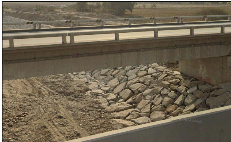
Figura 1: Enrocado del río Chicama – La Libertad
