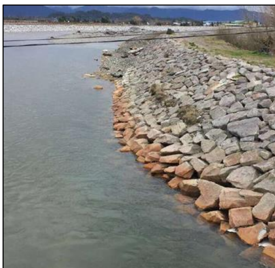
Figura 3: Colocación del enrocado
