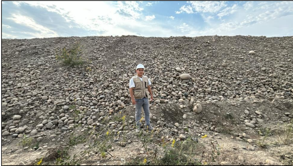
Figura 27: Capas de grava sobre enrocado, tramo 1+150 km Fuente: Elaboración propia 2024
