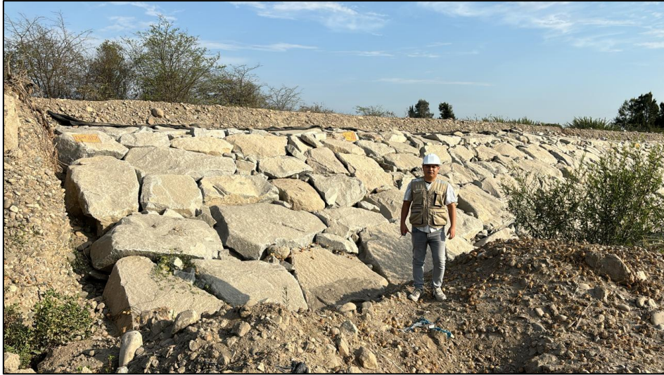
Figura 29: Tramo final 1+200 km del enrocado Fuente: Elaboración propia 2024
