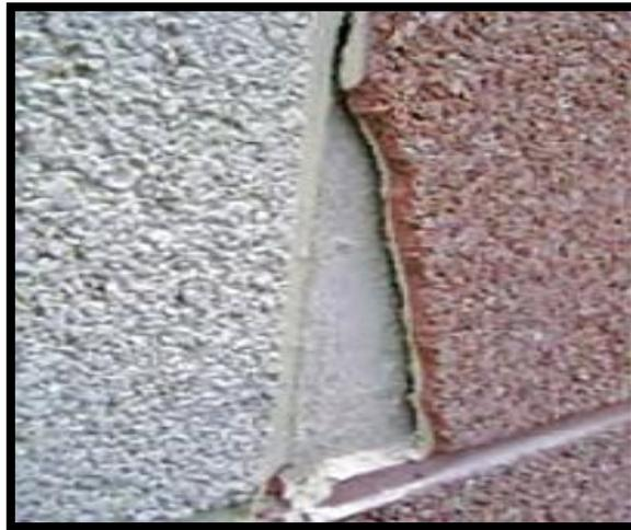
**Figura 12:** Desprendimiento de muro
