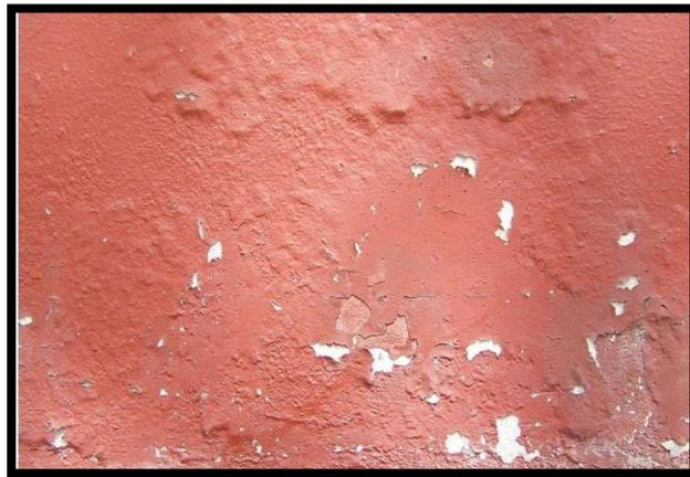
*Figura 13:* Descascaramiento de muro
