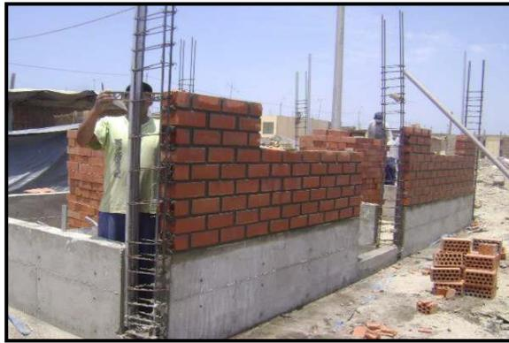
Figura 6: Sobrecimiento- elemento de confinamiento
