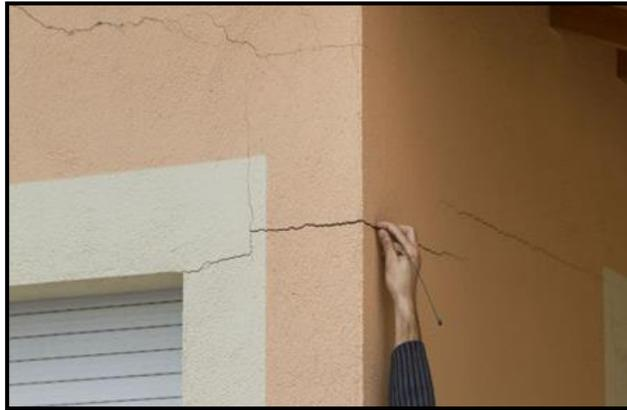
*Figura 10:* Fisuras en muro
