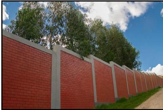
*Figura 1:* Cerco perimétrico de albañilería confinada
