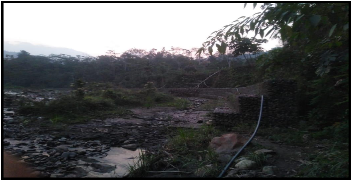
Figura 13: Inicio del muro de gaviones
