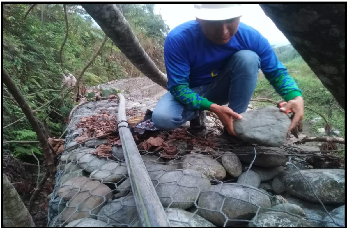
Figura 18: Pérdida de material por rotura de malla
