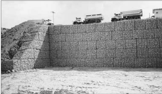
Figura 2.3.4 - Brasil - Contención para acceso a chancadora
