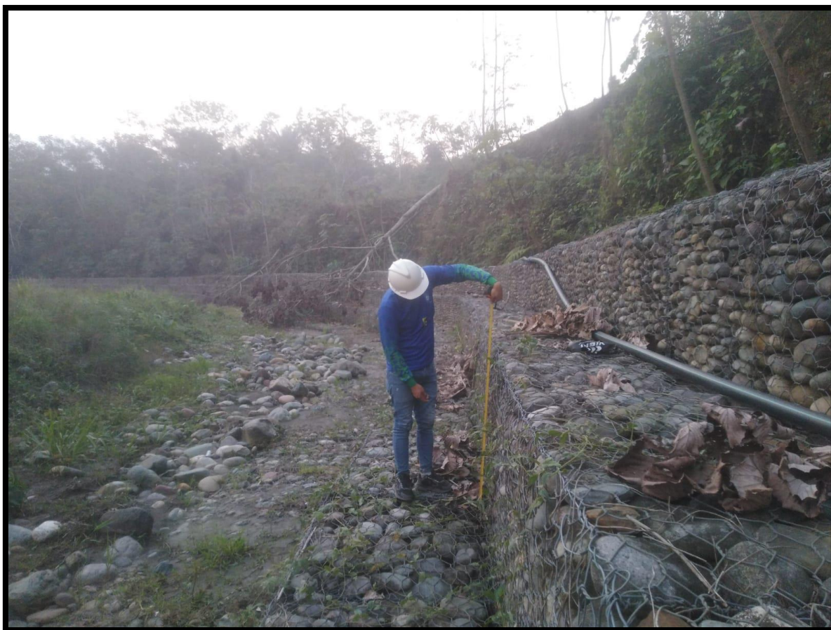
Figura 19: Altura del primer nivel del gabi3n
