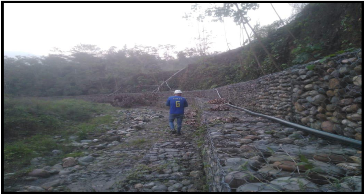
Figura 3: Muro de gaviones
