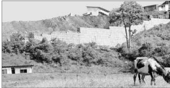
Figura 2.3.5 - Brasil - Contención ejecutada en 1986
