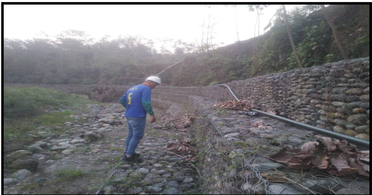
Figura 10: Evaluación del muro de gaviones
