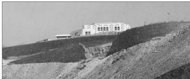
Figura 2.2.2 - Arabia Saudita - Muros de contención en el palacio Real en Medina
