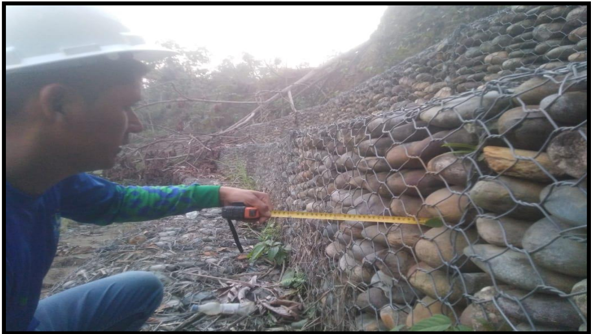
Figura 11: Medición del material de relleno
