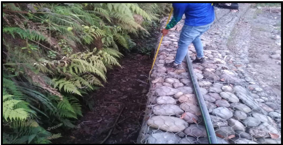
Figura 16: Altura del muro de gaviones
