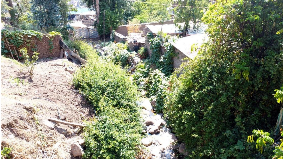
Fotografía 01: se visualizan vivienda al borde del rio Hitanayocc entre las progresivas 0+000 hasta 0.100
