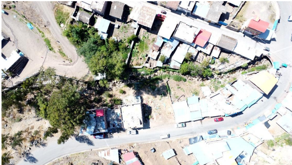
Fotografía 04: fotografía realizada con el uso de dron, entre las progresivas 0+000 a 0+100 donde se visualizan viviendas al borde del rio que en tiempos de lluvia incrementan el caudal.
