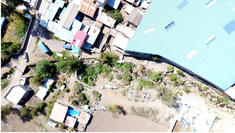
Fotografía 07: se verifica viviendas que colindan con el Rio Hitanayocc entre las progresivas 0+250 a 0+300 donde son afectado con la crecida del Rio.
