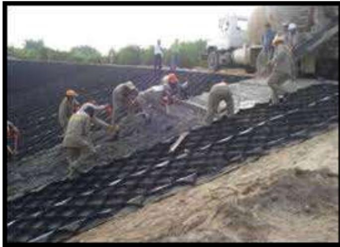
Figura 3: Colocación de malla
