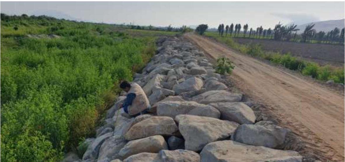
Figura 8: Pendiente del enrocado
