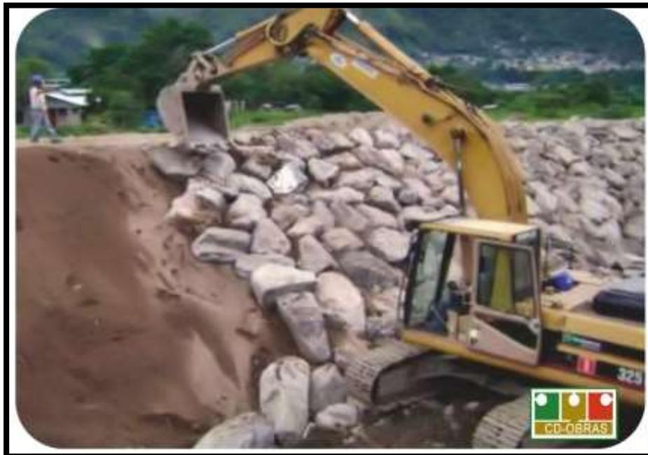
Figura 1: Mantenimiento del enrocado
