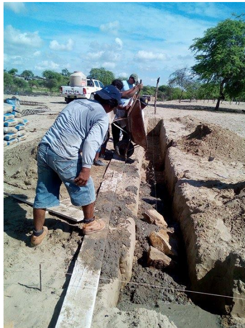
Fig. 01 Proceso de vaciado de cimentación en cerco perimétrico en vivienda Sra. Janeth Mogollón Banda ubicada Mz. K lote 08 La Mariposa Los Ejidos, Piura
