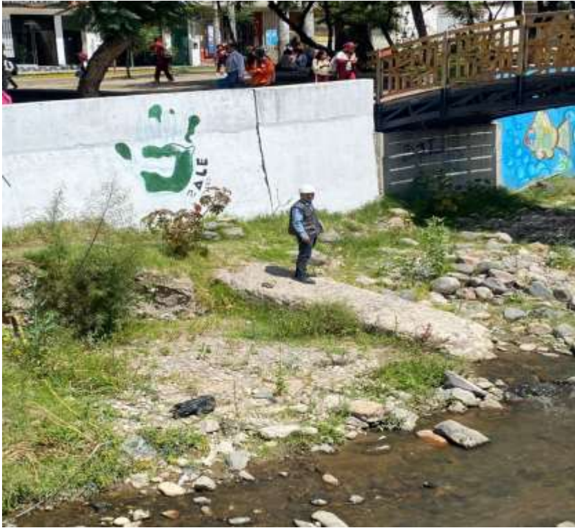
VISTA ADELANTE PROGESIVA 2+500- 2+550 MARGEN IZQUIERDO:SE PUEDE OBSRVAR EL MURO DE CONCRETO ARMADO EXISTENTE Y POCO VEGETACION, PRESENCIA DE UNBLOQUE DE CONCRETO CON ACERCAMIENTO DEL RÍO
