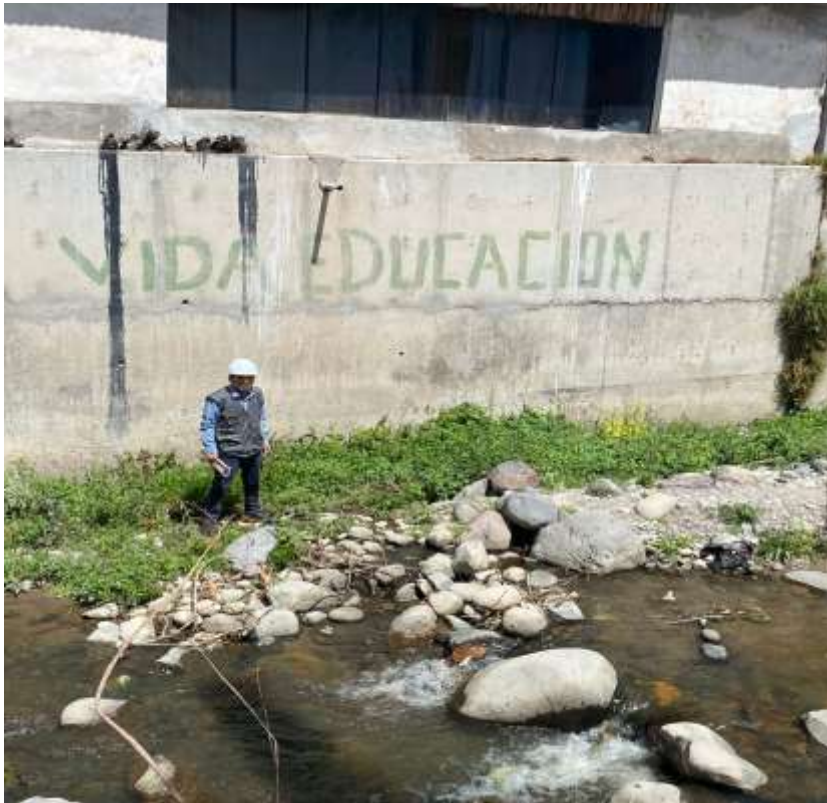
VISTA ADELANTE PROGRESIVA 2+650- 2+700 MARGEN IZQUIERDO:SE PUEDE OBSERVAR EL MURO DE CONCRETO ARMADO EXISTENTE Y POCO VEGETACION EL RIO LLEVANDOSE POCO ALGUNOS RESTANTES CONCRETO DE AÑOS
