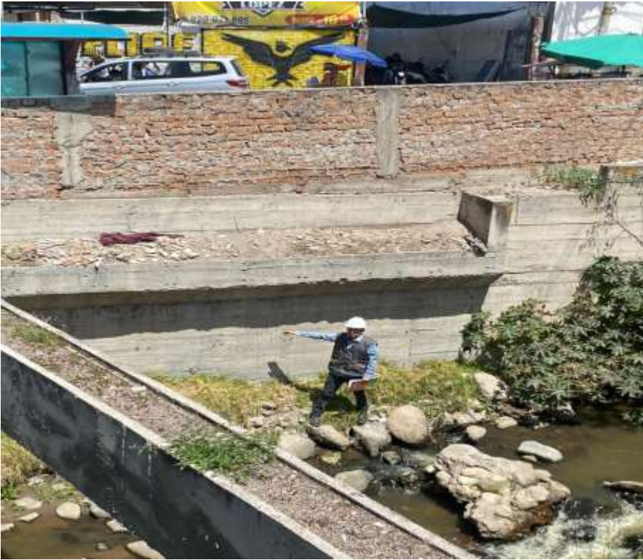
VISTA ADELANTE PROGESIVA 2+300- 2+350 MARGEN IZQUIERDO:SE PUEDE OBSERVAR EL MURO DE CONCRETO ARMADO EXISTENTE Y POCO VEGETACION
