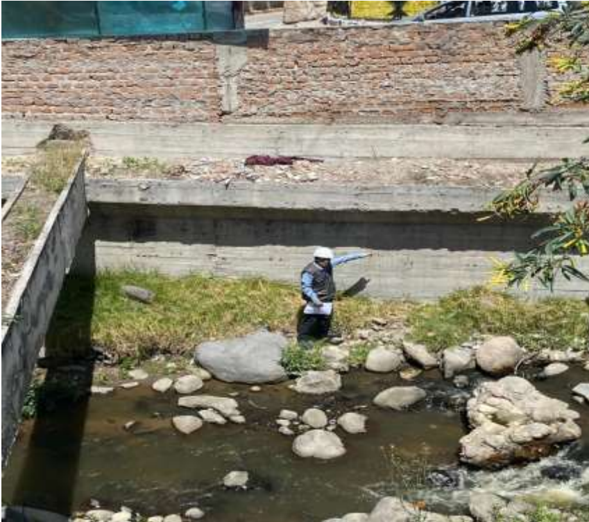
VISTA ATRAS PROGESIVA 2+300- 2+350 MARGEN IZQUIERDO:SE PUEDE OBSERVAR EL MURO DE CONCRETO ARMADO EXISTENTE Y POCO VEGETACION
