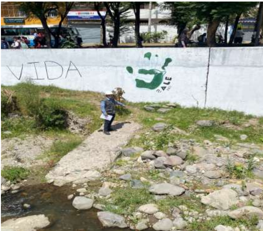
VISTA ATRAS PROGESIVA 2+500- 2+550 MARGEN IZQUIERDO:SE PUEDE OBSERVAR EL MURO DE CONCRETO ARMADO EXISTENTE Y POCO VEGETACION, PRESENCIA BLOQUE DE CONCRETO CON ACERCAMIENTO DEL RÍO
