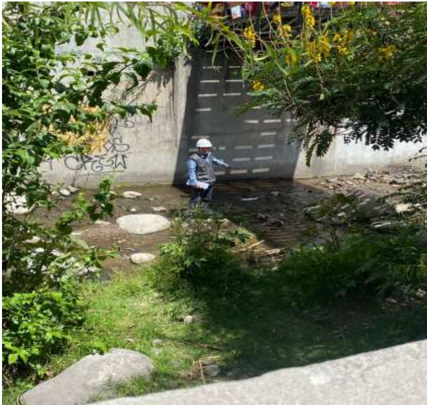
VISTA ADELANTE PROGRESIVA 2+600- 2+650 MARGEN IZQUIERDO:SE PUEDE OBSERVAR EL MURO DE CONCRETO ARMADO EXISTENTE Y POCO VEGETACION ,
