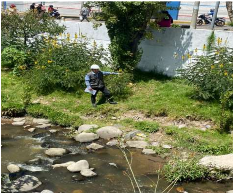
VISTA ATRAS PROGESIVA 2+450 - 2+500 MARGEN IZQUIERDO:SE PUEDE OBSERVAR EL MURO DE CONCRETO ARMADO EXISTENTE Y MUCHA VEGETACION (ARBOLES) CON ACERCAMIENTO DEL RÍO
