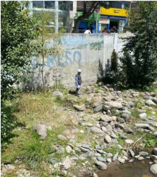
VISTA ADELANTE PROGRESIVA 2+550- 2+600 MARGEN IZQUIERDO:SE PUEDE OBSERVAR EL MURO DE CONCRETO ARMADO EXISTENTE Y POCO VEGETACION, A DISTANCIA DEL RÍO
