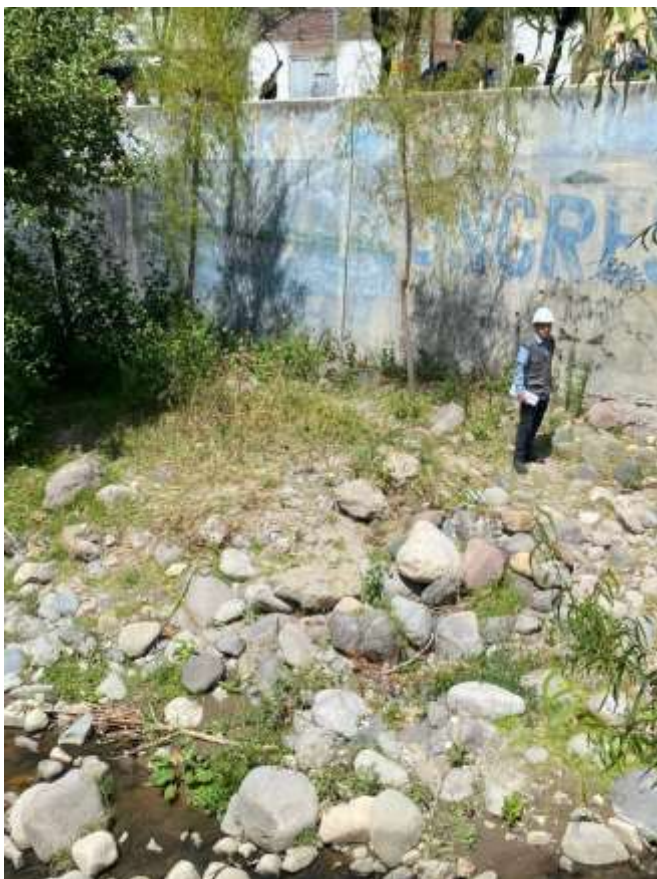
VISTA ATRAS PROGRESIVA 2+550- 2+600 MARGEN IZQUIERDO:SE PUEDE OBSERVAR EL MURO DE CONCRETO ARMADO EXISTENTE Y POCO VEGETACION, A DISTANCIA DEL RÍO
