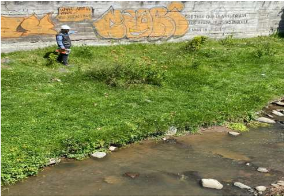
VISTA ADELANTE PROGRESIVA 2+400- 2+450 MARGEN IZQUIERDO:SE PUEDE OBSERVAR EL MURO DE CONCRETO ARMADO EXISTENTE Y MUCHA VEGETACION CON ACERCAMIENTO DEL RÍO
