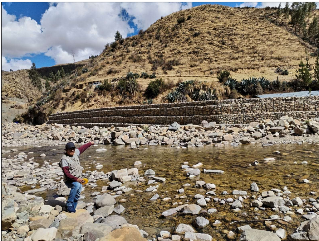
Fotografía N° 03: vista del tramo 01 y 02 del muro de gaviones a evaluar Fuente: Elaboración propia 2025
