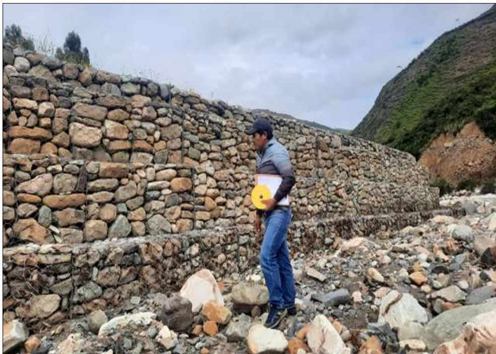
Fotografía N° 09: vista del tramo 01 de la defensa ribereña Fuente: Elaboración propia 2025
