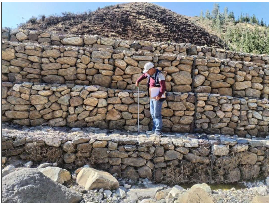
Fotografía N° 30: Evaluación tramo 4 de la defensa ribereña Fuente: Elaboración propia 2025
