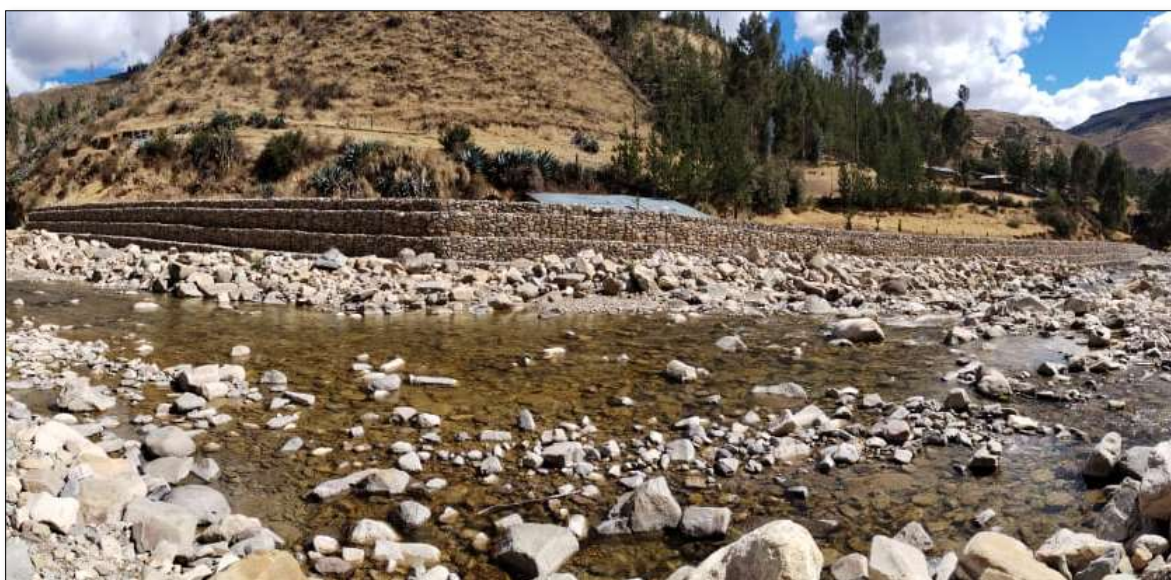
Fotografía N° 02: vista panorámica de la defensa ribereña
