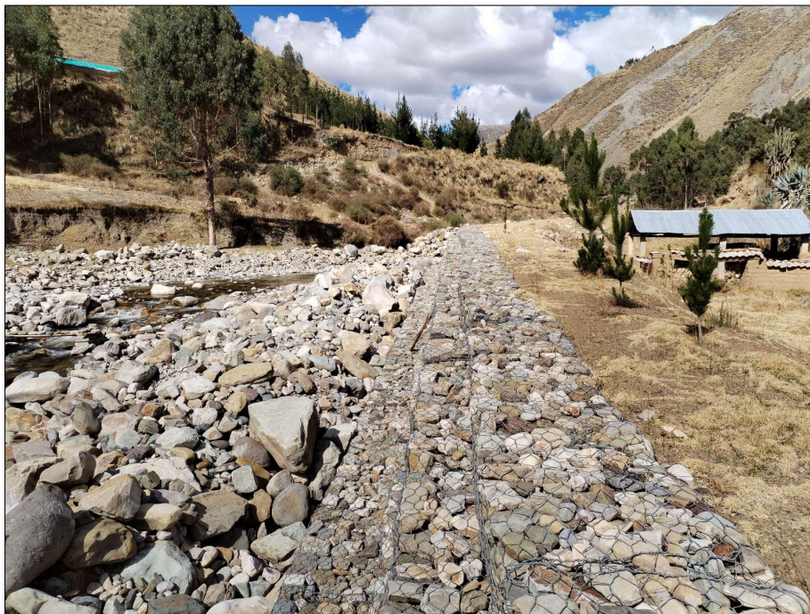
Fotografía N° 08: vista del tramo 03 de la defensa ribereña Fuente: Elaboración propia 2025
