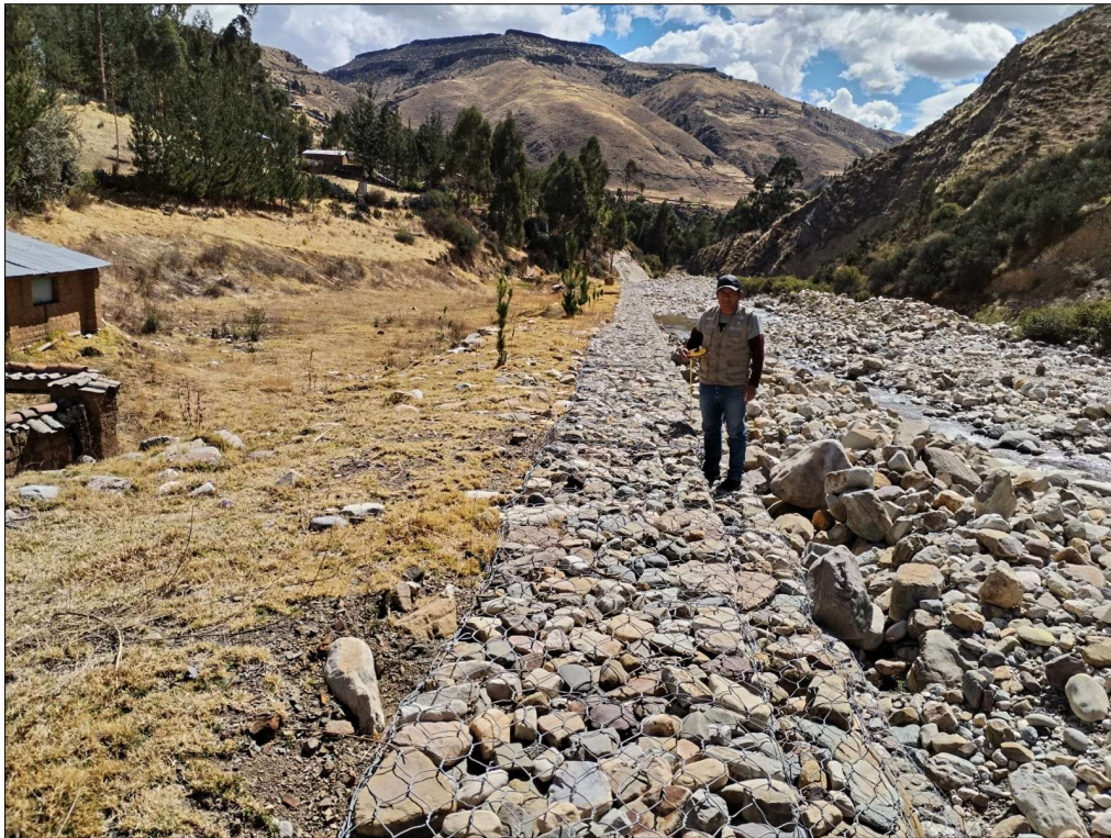
Fotografía N° 07: vista del tramo 2 de la defensa ribereña Fuente: Elaboración propia 2025
