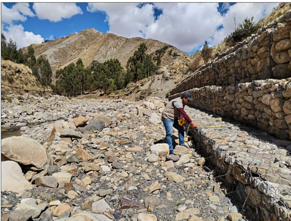
Fotografía N° 10: medición de las dimensiones del muro de gaviones Fuente: Elaboración propia 2025
