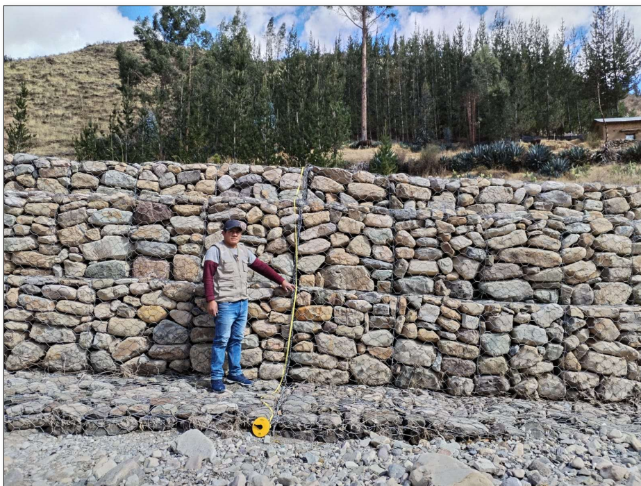
Fotografía N° 29: verificación de la alineación de las juntas o amarres entre gaviones
