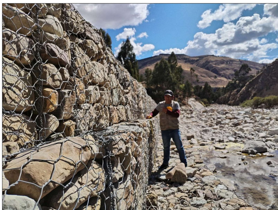
Fotografía N° 31: Evaluación tramo 4 de la defensa ribereña Fuente: Elaboración propia 2025
