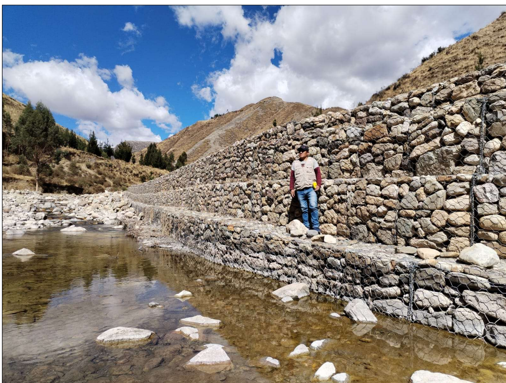
Fotografía N° 04: vista del tramo 03 del muro de gaviones a evaluar Fuente: Elaboración propia 2025
