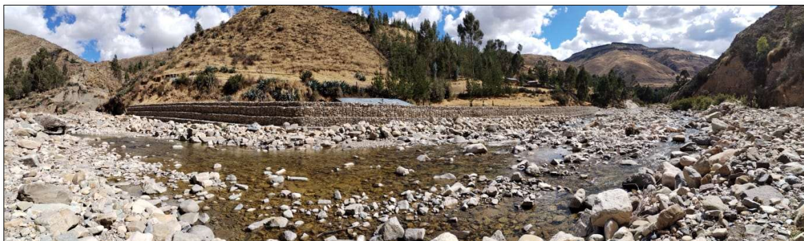
Fotografía N° 01: vista panorámica de la defensa ribereña
