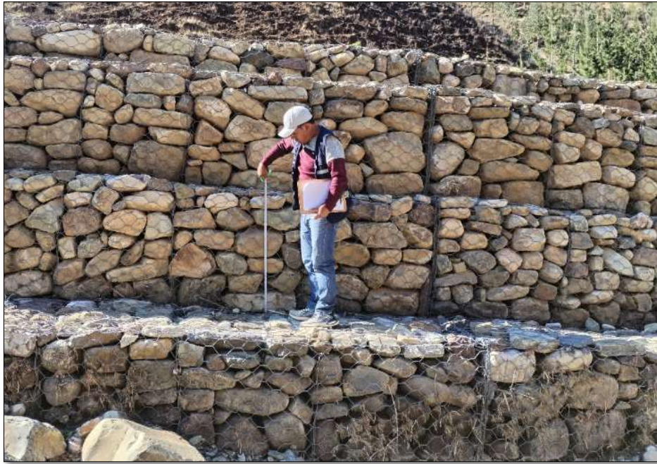
Fotografía N° 16: medición de las dimensiones del muro de gaviones Fuente: Elaboración propia 2025
