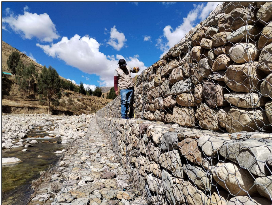
Fotografía N° 17: medición de las dimensiones del muro de gaviones Fuente: Elaboración propia 2025
