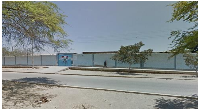
Fotografía 10: Frontis del Cerco Perimétrico de la Institución Educativa 15029 Santa Teresa de Jesús.
