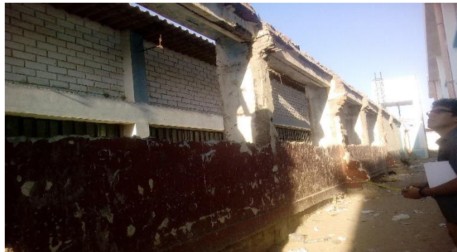
Fotografía 17: Muro que limita con la Propiedad a Terceros.
