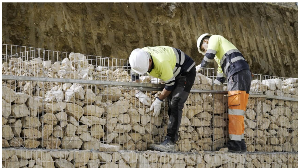
Figura 4: Colocado de piedras en las malallas de gaviones
