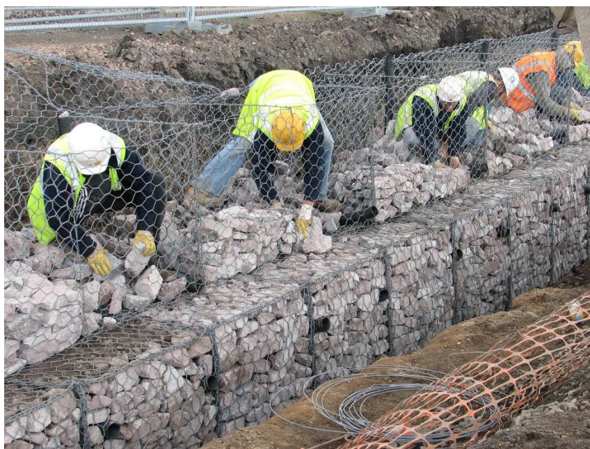
Figura 11: Mantenimiento de malla de gavión
