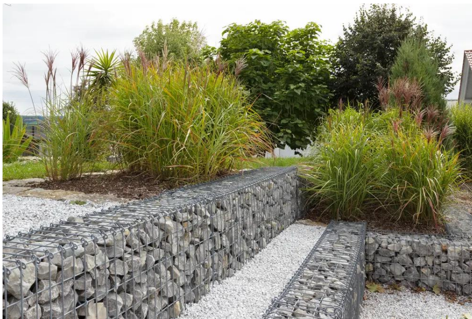
Figura 8: Control de erosión con muro de gavión
