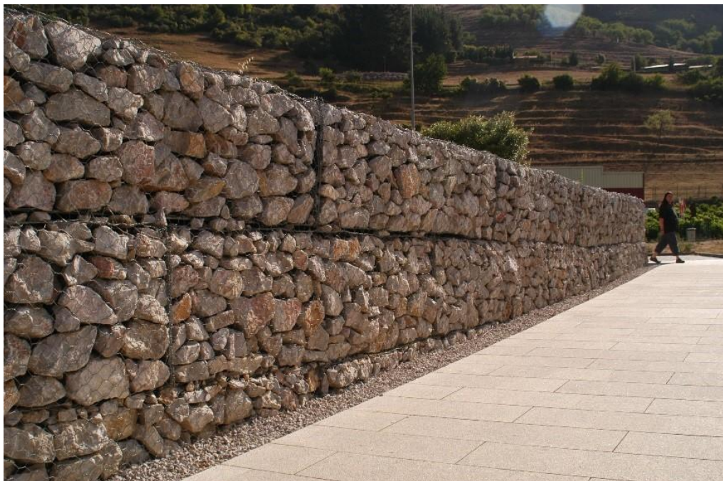
Figura 1: Modelo de muros de gaviones
