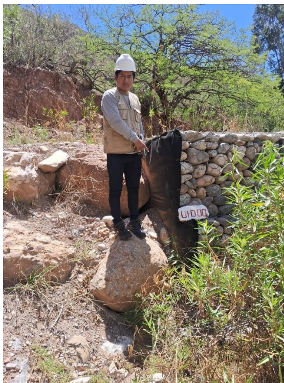
FOTO N° 01 En la imagen se muestra la progresiva 0+000, punto de inicio de la investigación del proyecto titulado “Evaluación del muro de gaviones para mejorar la defensa ribereña del margen izquierdo del río Quillachaca, en el tramo comprendido entre las progresivas 0+000 y 0+500, en la comunidad de San José de Sucre, distrito de Colca, provincia de Víctor Fajardo, departamento de Ayacucho – 2025.” Fecha de la fotografía: 23 de agosto del 2025
