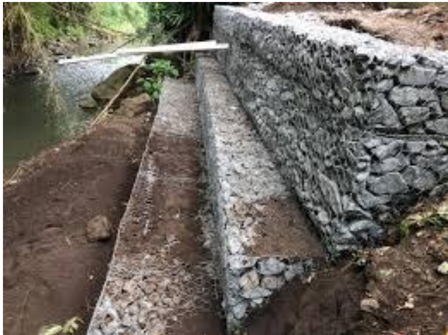
Figura 9: Reducción de inundaciones con muro de gavión
