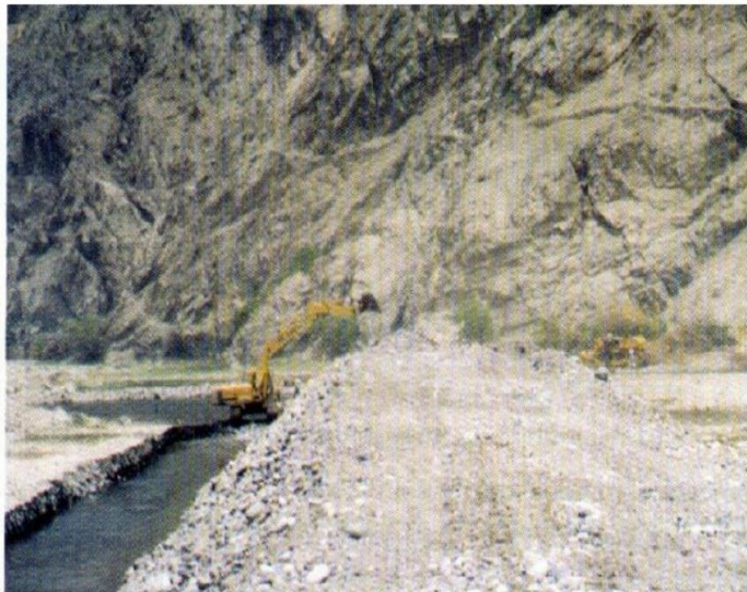
Foto N°5. Excavadora culminando la apertura de la uña de estabilidad
