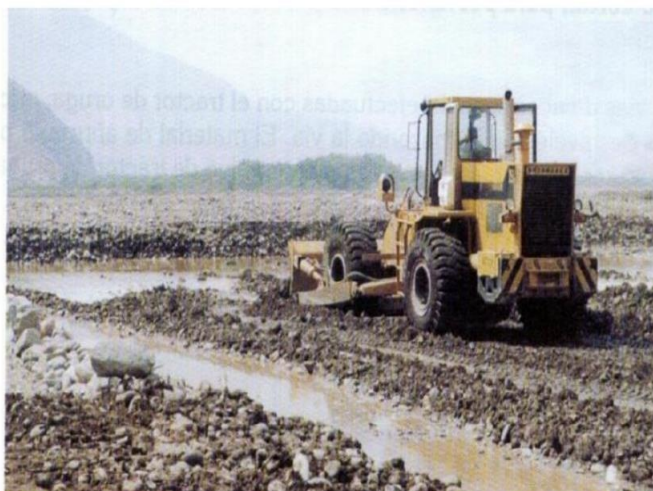
Foto N°3- Preparación de vía de acceso
