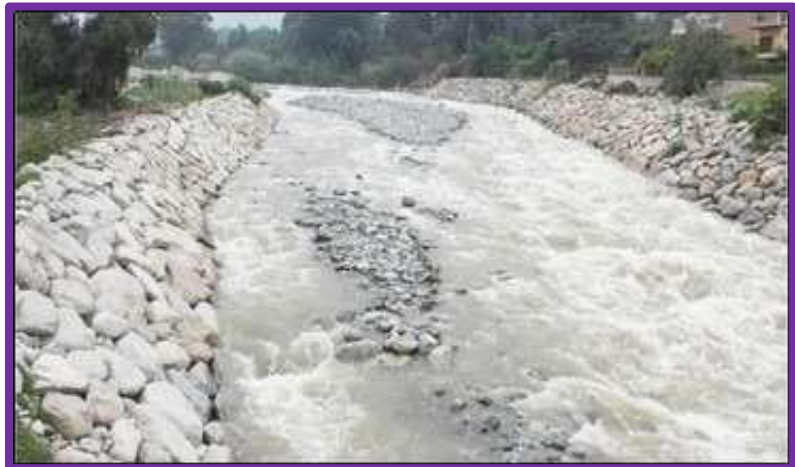
Figura 09. Enrocado.
