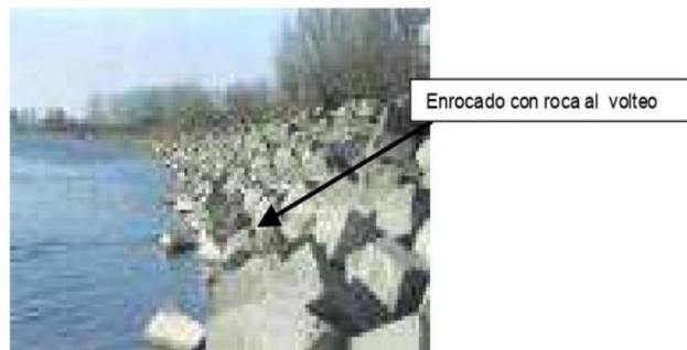
Figura 6.2. Fotografía de un enrocado con roca al volteo
