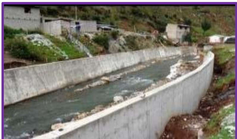
Figura 16. Muro de concreto armado.
