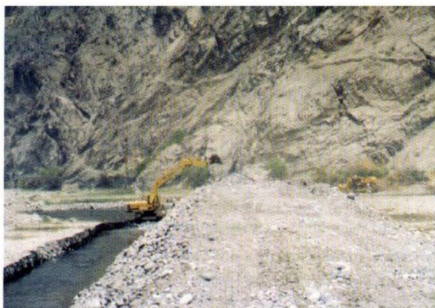
Foto N°4. Tractor iniciando armado de terraplén
