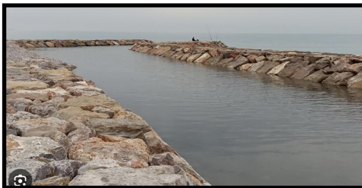
Figura 9: Defensa ribereña tipo espigones Fuente: Minagri (2017)
