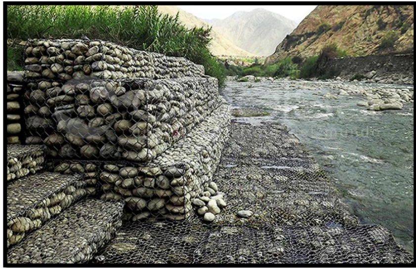
Figura 7: Construcción de muro de gaviones Fuente: Minagri (2017)
