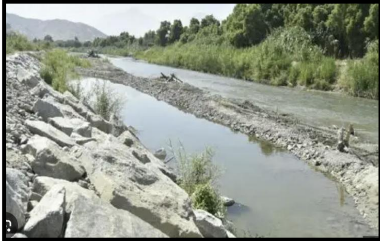
Figura 8: Defensa ribereña tipo enrocado Fuente: Minagri (2017)
