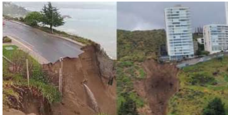
Figura 11: Imagen de una Socavación
