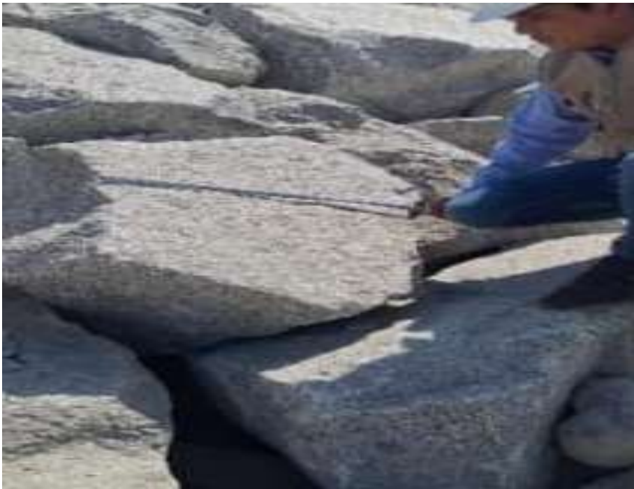
Figura 43: pantalla de enrocado de la progresiva 0+200 al 0+300 Fuente: Elaboración propio.
