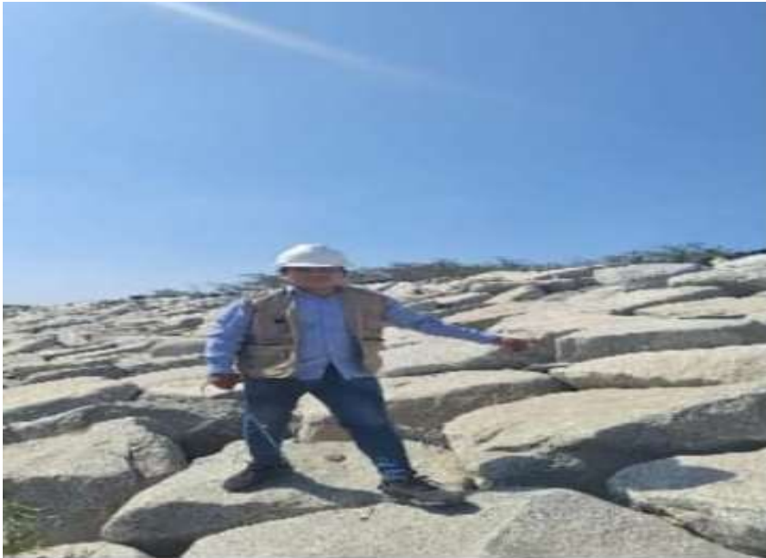
Figura 36: pantalla de enrocado de la progresiva 0+000 al 0+500 Fuente: Elaboración propio.
