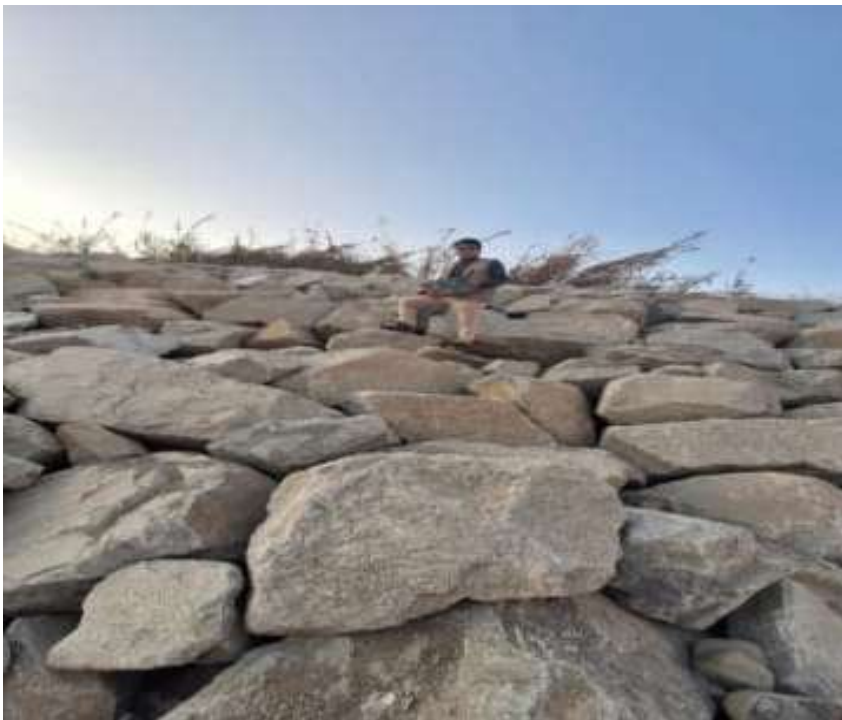
Figura 21: pantalla de enrocado de la progresiva 0+200 al 0+300 Fuente: Elaboración propio.
