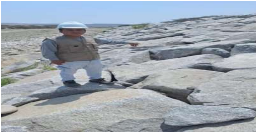
Figura 17: vista de la pantalla de enrocado entre las progresivas 0+000 al 0+500 Fuente: Elaboración propio.
