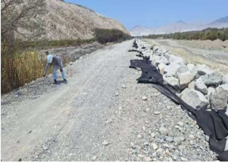
Figura 18: En esta imagen se observa la medición de la corona. Fuente: Elaboración propio.
