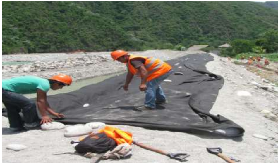
Figura 7: Colocación de un filtro para un enrocado. Fuente: Extraído de la investigación de Yraitá (19)
