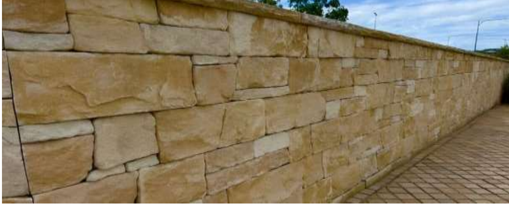
Figura 20: Muro de mampostería
