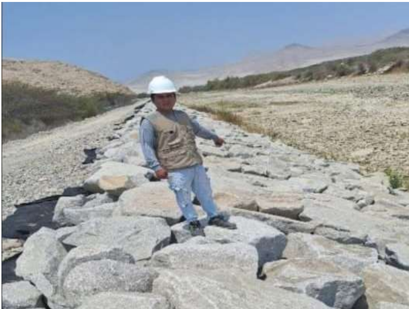
Figura 31: Imagen de una pantalla de enrocado
