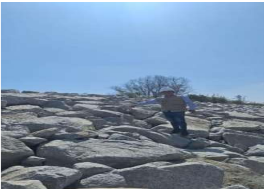
Figura 39: pantalla de enrocado de la progresiva 0+100 al 0+200
