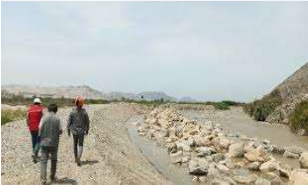
Figura 1. Evaluación de un muro de enrocado Fuente: Extraído de la investigación de Cristóbal (17)
