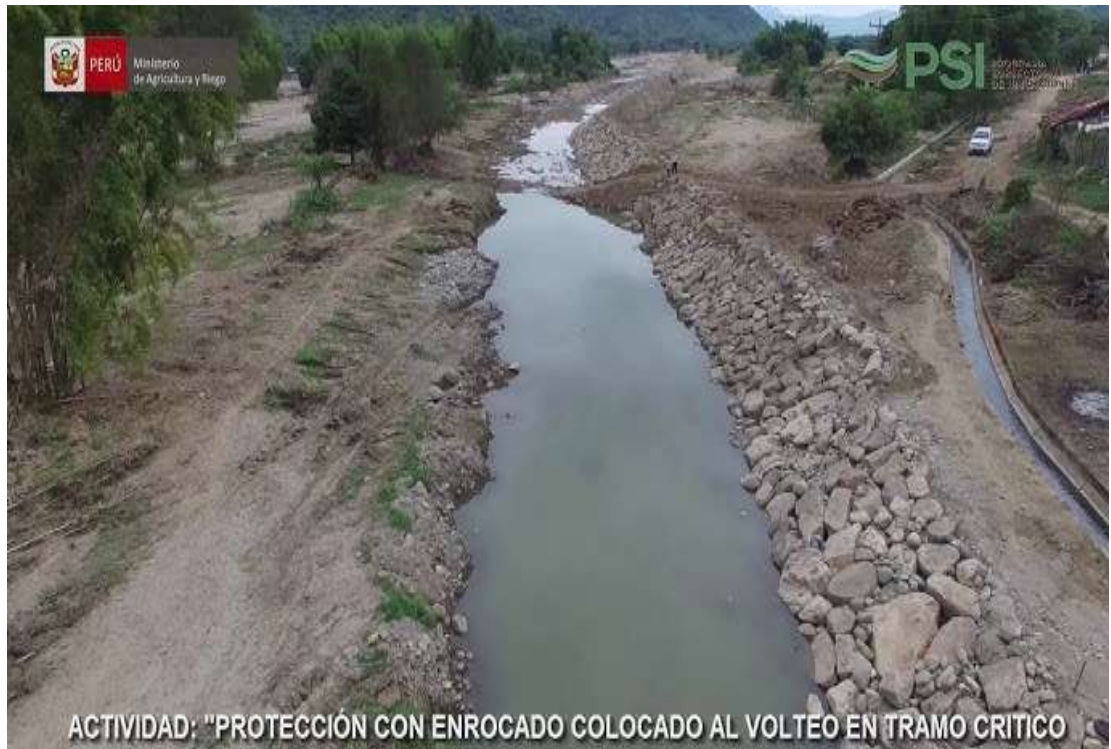
Figura 5: Enrocado con roca al volteo.
