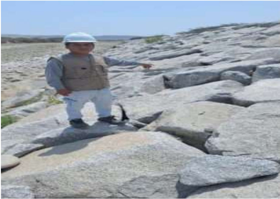
Figura 24: pantalla de enrocado de la progresiva 0+200 al 0+300 Fuente: Elaboración propio.
