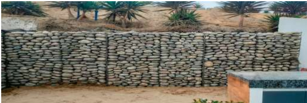
Figura 21: Gaviones y su correcta ejecución
