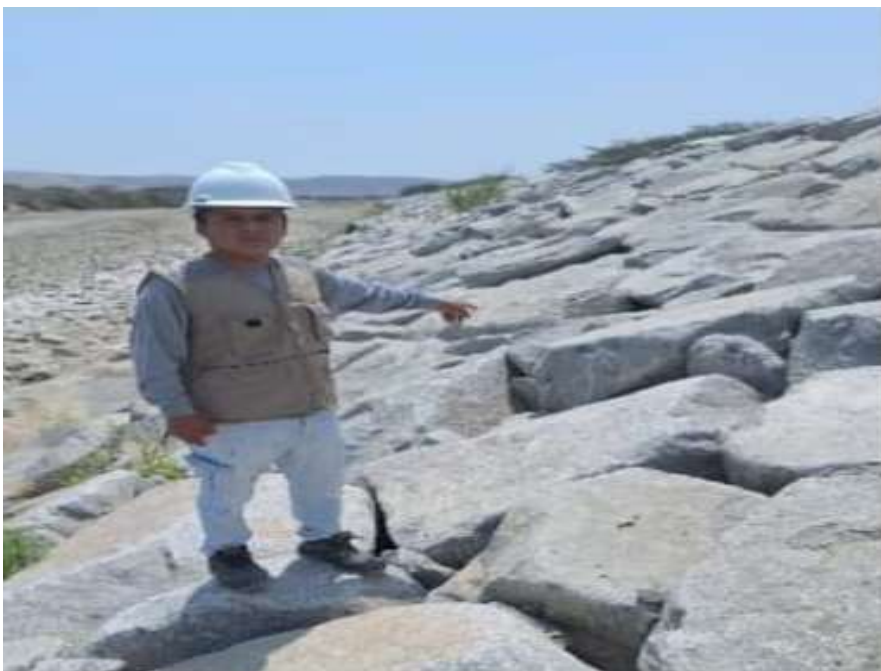
Figura 35: Imagen de un enrocado
