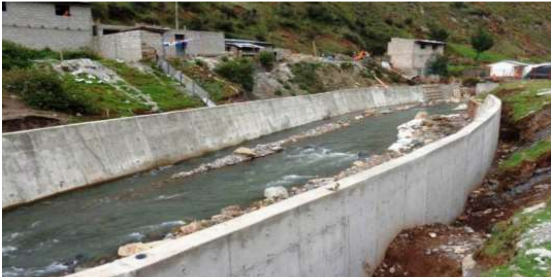
Figura 19: Muros de concreto armado Fuente: inforcivil.com (30)
