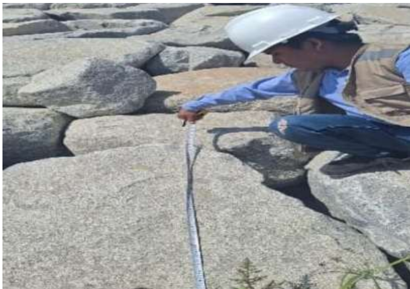
Figura 37: pantalla de enrocado de la progresiva 0+200 al 0+300 Fuente: Elaboración propio.
