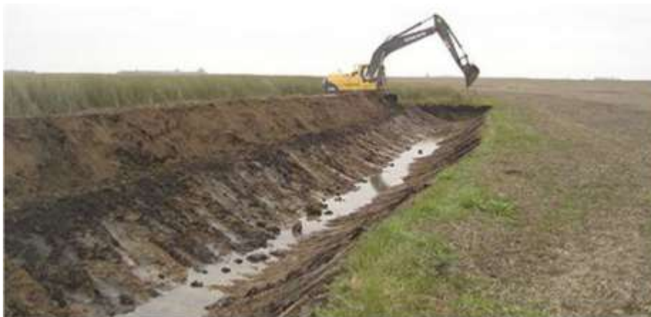
Figura 23: Muros de encausamiento Fuente: www.restauracionpaisajistica.com (34)
