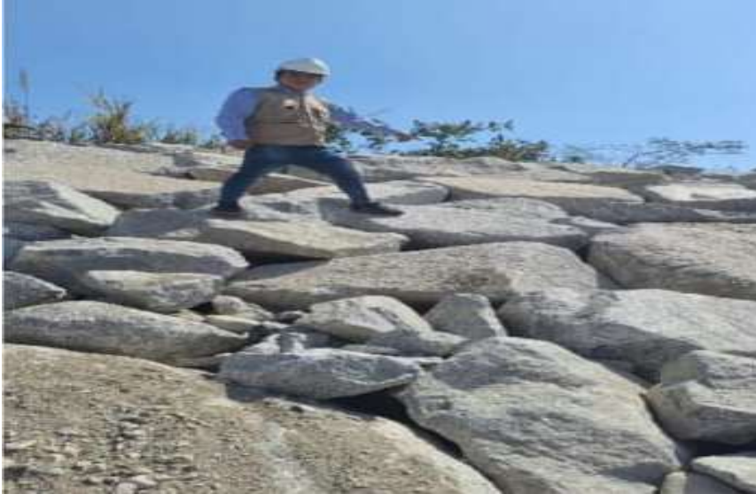
Figura 40: pantalla de enrocado de la progresiva 0+200 al 0+300 Fuente: Elaboración propio.
