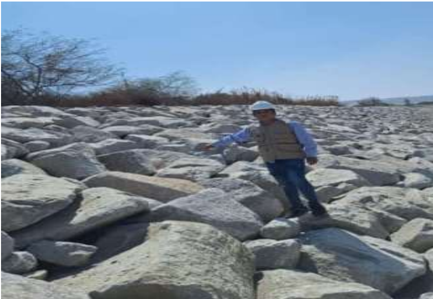
Figura 41: pantalla de enrocado de la progresiva 0+000 al 0+500 Fuente: Elaboración propio.
