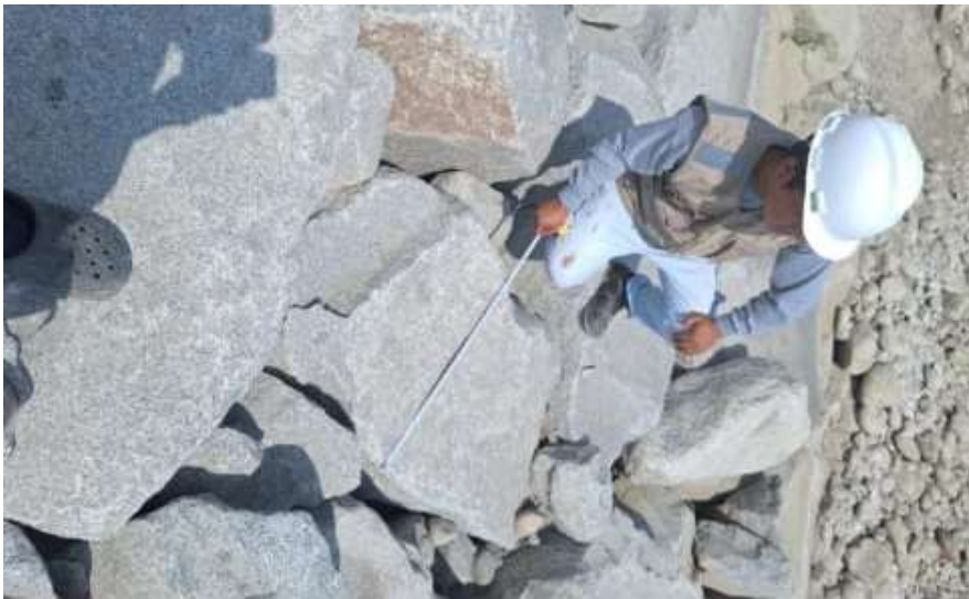
Figura 19: En esta imagen se observa la medición de la corona. Fuente: Elaboración propio.
