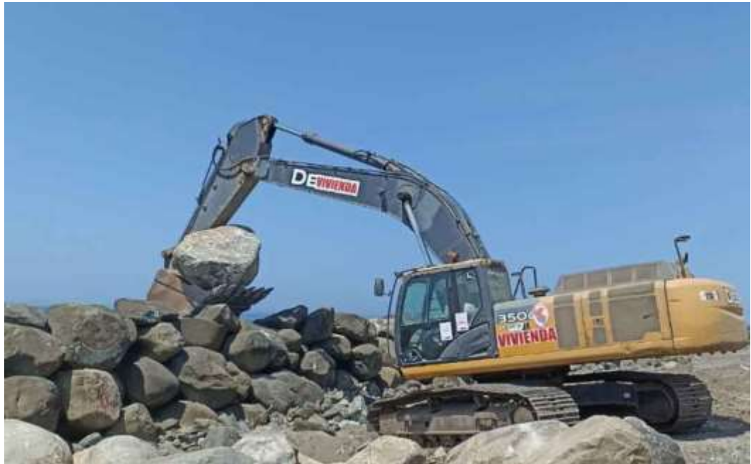
Figura 6: Enrocado con roca colocada.
