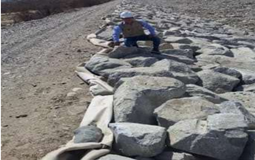
Figura 42: Imagen de un enrocado de la progresiva 0+200 al 0+250 Fuente: Elaboración propio.
