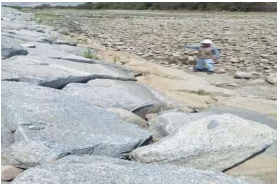
Figura 29: Imagen de un enrocado
