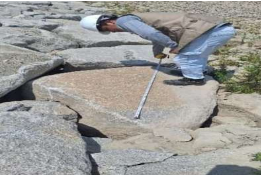
Figura 27: pantalla de enrocado de la progresiva 0+200 al 0+300 Fuente: Elaboración propio.
