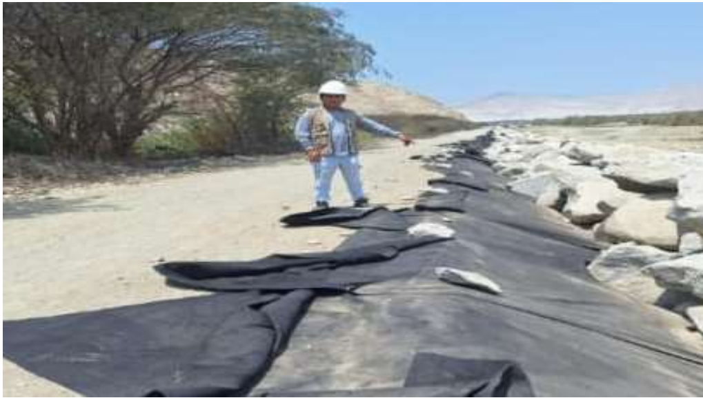
Figura 16: Punto de inicio de evaluación ubicado en el río Ccarampa, Distrito de Luricocha. Fuente: Elaboración propio.
