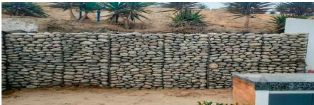
Figura 21: Gaviones y su correcta ejecución
