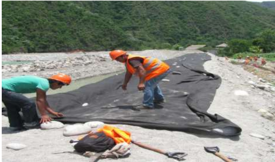
Figura 7: Colocación de un filtro para un enrocado. Fuente: Extraído de la investigación de Yraita (19)
