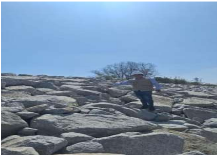
Figura 39: pantalla de enrocado de la progresiva 0+100 al 0+200
