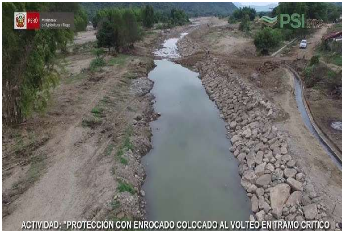
Figura 5: Enrocado con roca al volteo.
