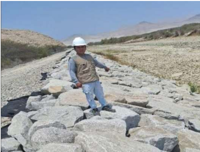
Figura 31: Imagen de una pantalla de enrocado
