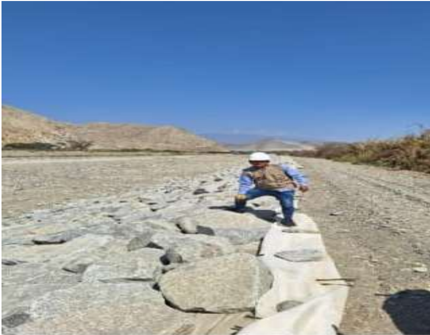
Figura 38: pantalla de enrocado
