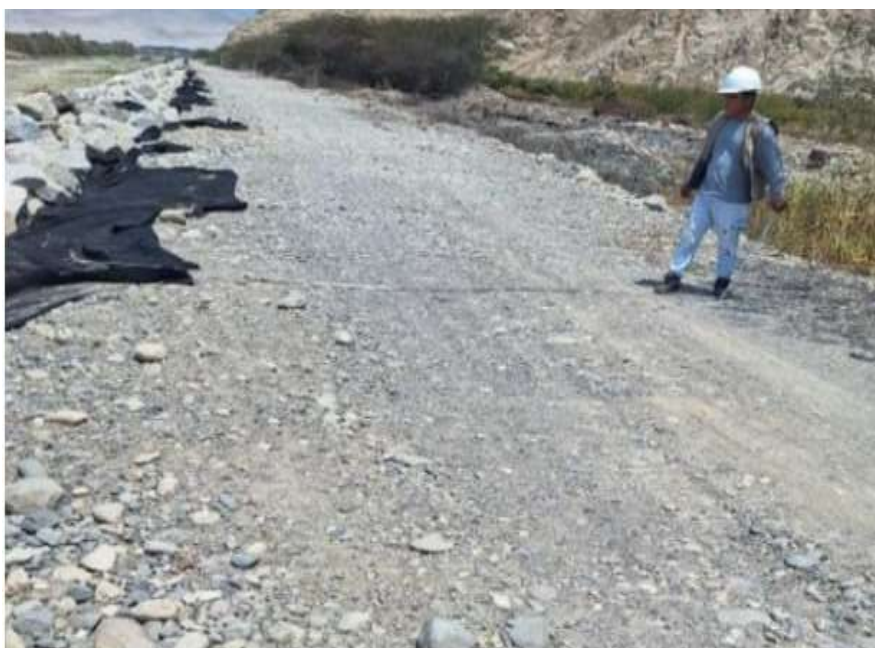
Figura 26: Imagen de una corona de enrocado
