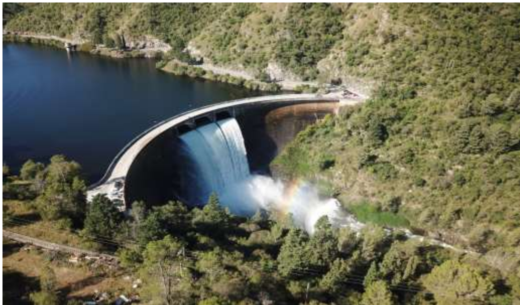
Figura 17: Diques artificiales Fuente: es.slideshare.net (29)
