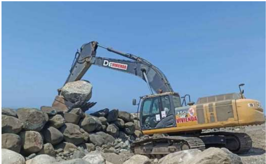
Figura 6: Enrocado con roca colocada. Fuente: Extraído de la investigación de Yraitá (19)
