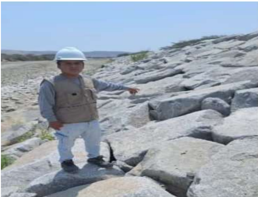
Figura 35: Imagen de un enrocado
