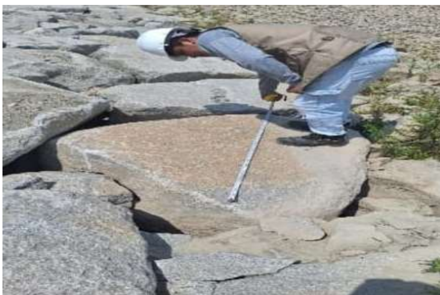
Figura 27: pantalla de enrocado de la progresiva 0+200 al 0+300
