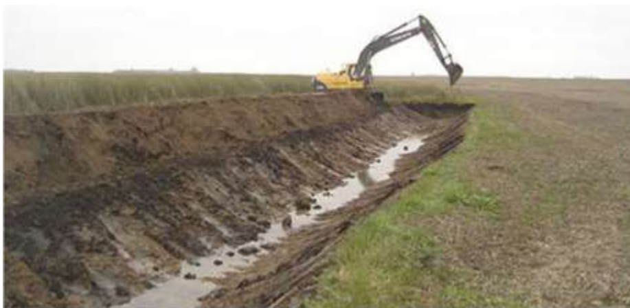
Figura 23: Muros de encausamiento
