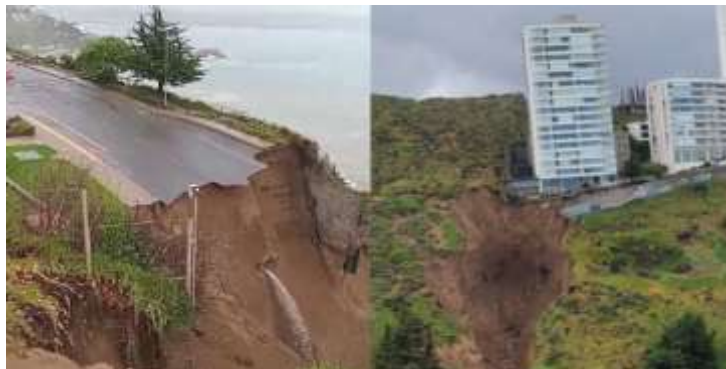
Figura 11: Imagen de una Socavación
