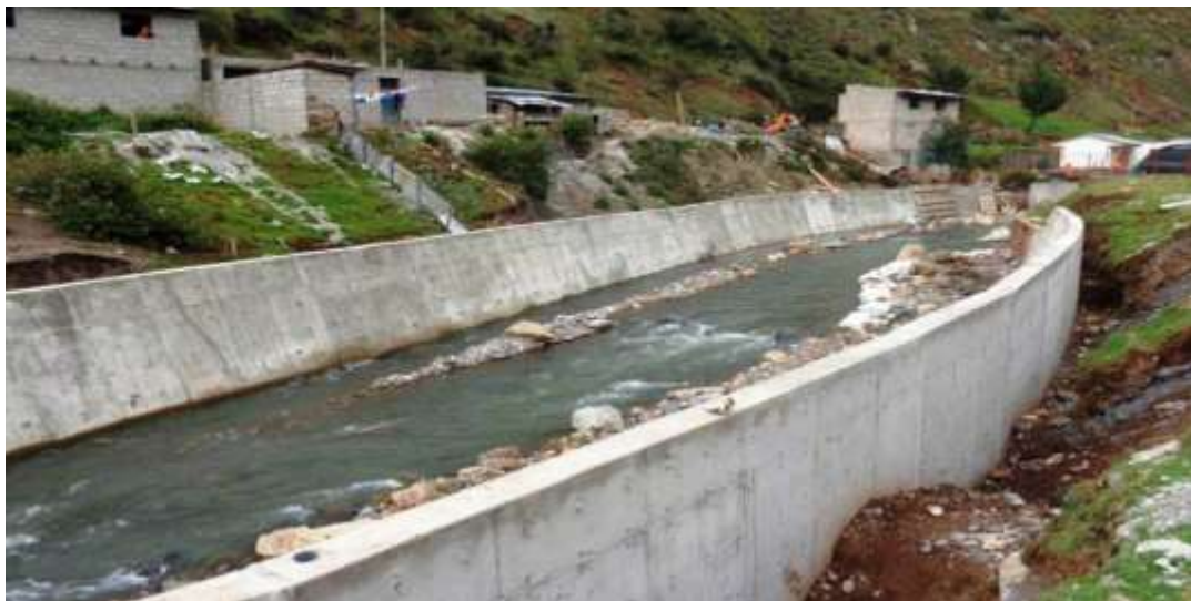
Figura 19: Muros de concreto armado Fuente: inforcivil.com (30)
