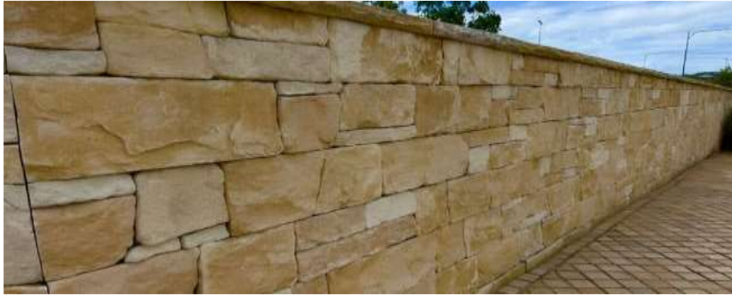
Figura 20: Muro de mampostería
