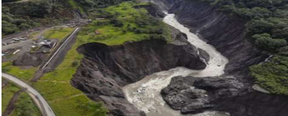
Figura 12: Imagen de una erosión.
