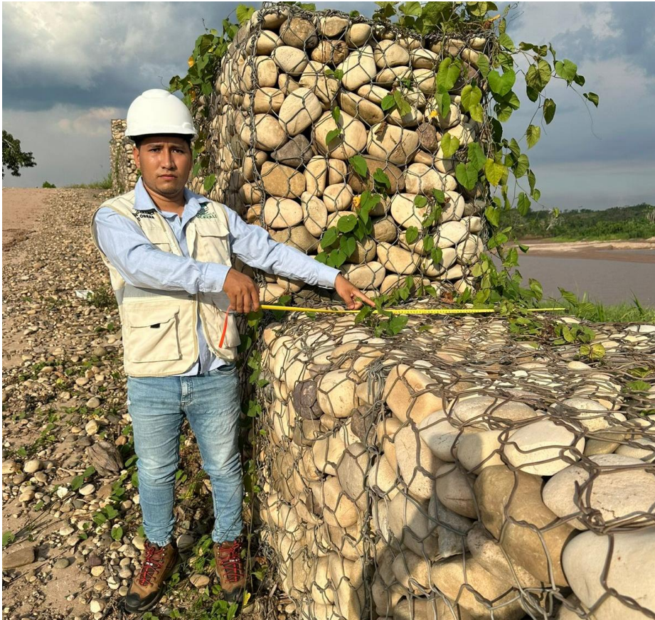
Figura 14: Medición de ancho de muro de gavión
