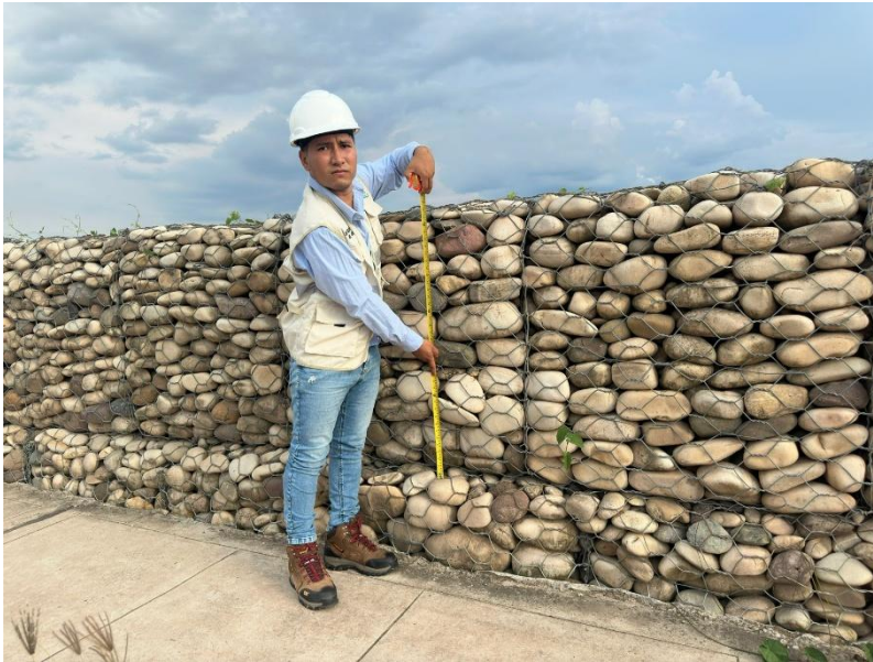
Figura 12: Medición de altura de tercer nivel
