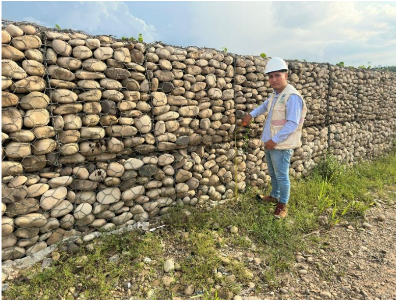
Figura 10: Medición de gavión segundo nivel Fuente: Evidencia de campo 2025
