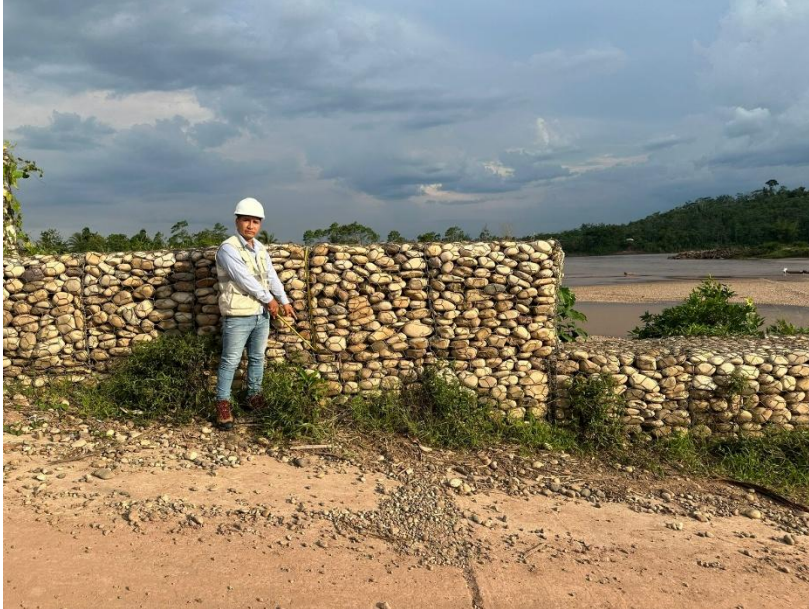
Figura 8: Medición de muro de gaviones
