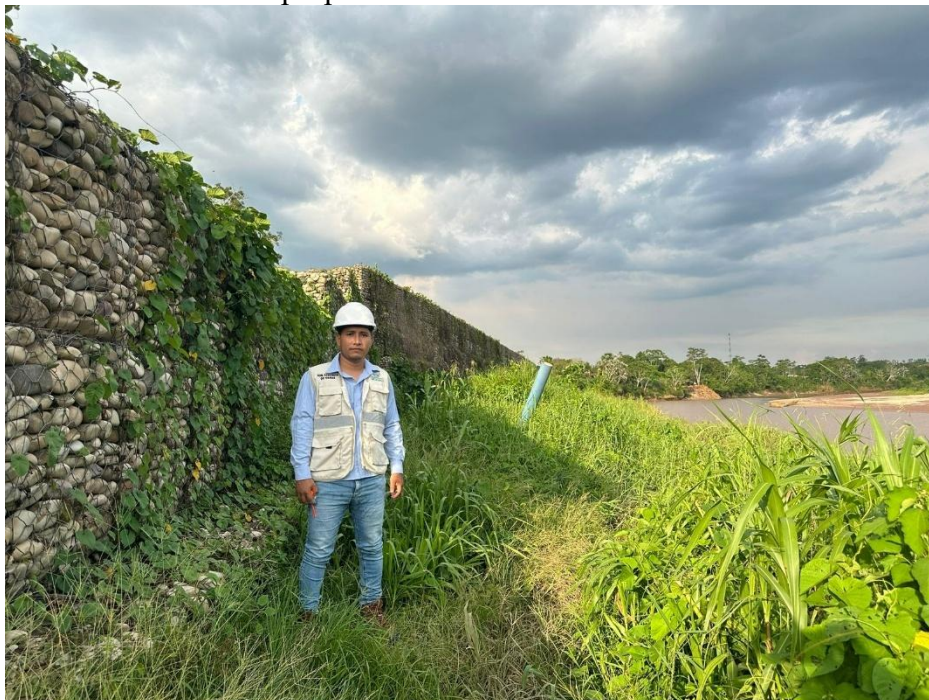
Figura 17: Presencia de vegetación en último tramo de muro de gaviones
