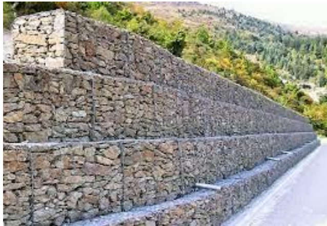
Figura 1: Muro de gaviones
