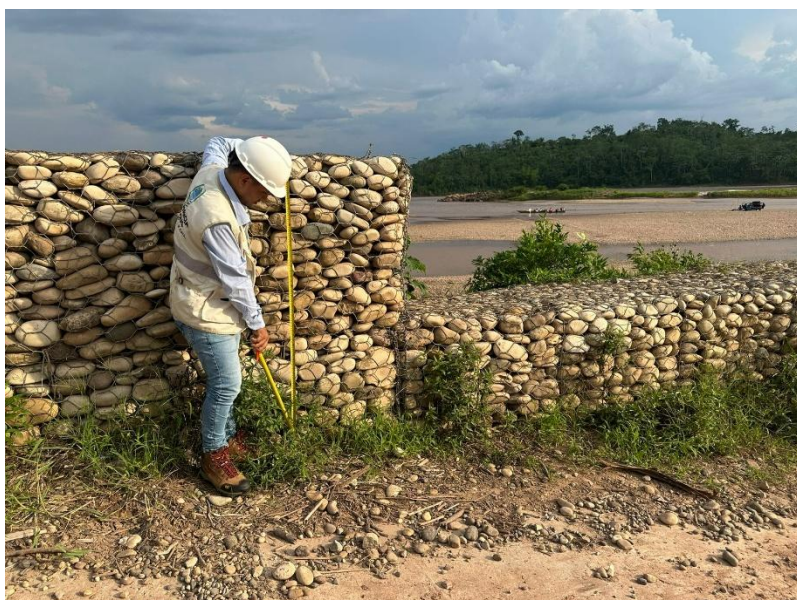
Figura 15: Medición de altura de gavión
