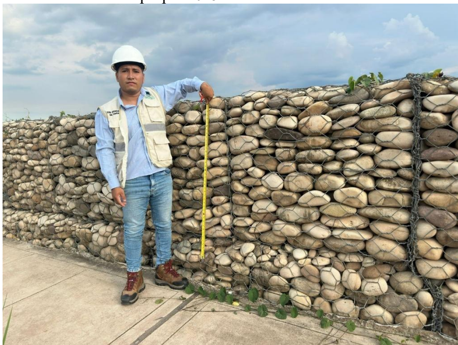
Figura 9: Medición de altura de gavión
