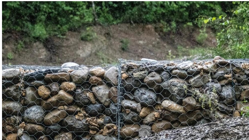
Figura 4: Relleno para gaviones
