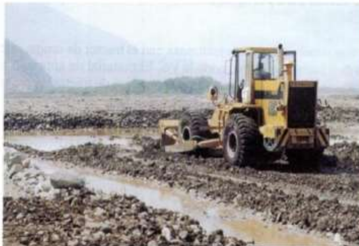
Foto N°3- Preparación de vía de acceso
