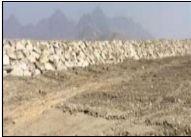
Figura 15: Enrocado con roca colocada
