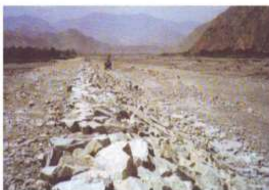
Figura 6.3. Fotografía de un enrocado con roca colocada al volteo
