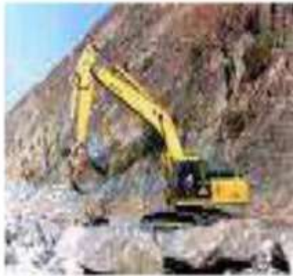
Figura 6.7. Volcado del enrocado con maquinaria
