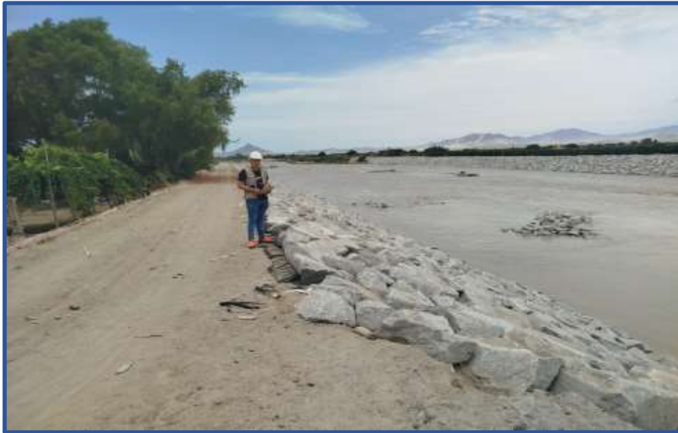
Figura 1: Se observa el inicio de la estructura de enrocado, el cual se ubica en la progresiva 0+000.
