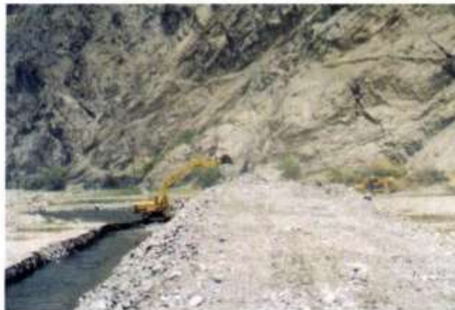
Foto N°4. Tractor iniciando armado de terraplén
