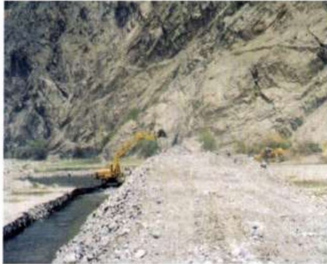
Foto N°5. Excavadora culminando la apertura de la uña de estabilidad
