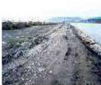
Figura 6.4. Talud peinado con maquinaria
