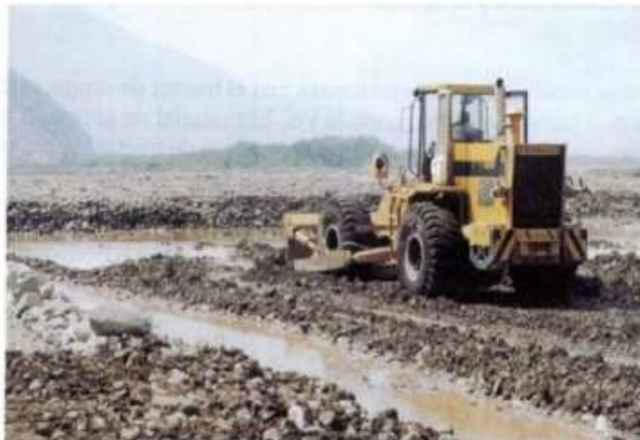
Foto N°3- Preparación de vía de acceso
