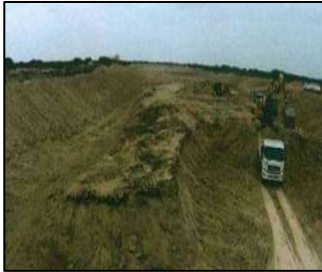
Figura 24: Extracción de material sedimentado de cauce
