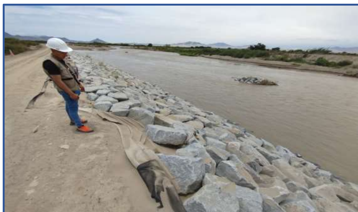
Figura 12: Se muestra que esta parte de la estructura ha sufrido desplazamiento para la parte de abajo, lo cual sea por socavación de la misma base, estamos situado en la progresiva 0+320.
