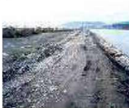
Figura 6.4. Talud peinado con maquinaria
