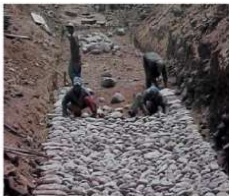
Figura 6.6. Forma de colocar las piedras para un enrocado colocado a mano
