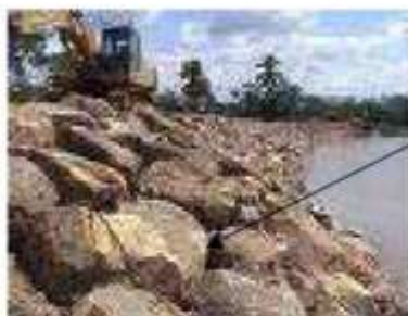
Figura 6.5 Fotografía de un enrocado con roca colocada
