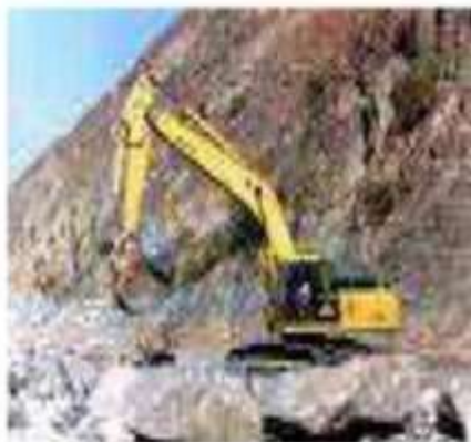
Figura 6.7. Volcado del enrocado con maquinaria
