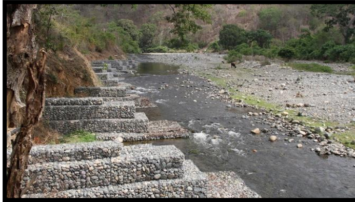
Figura 2. Espigones de gaviones.
