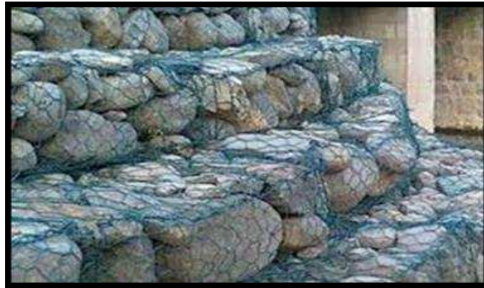
Figura 10. Gaviones revestidos con PVC.
