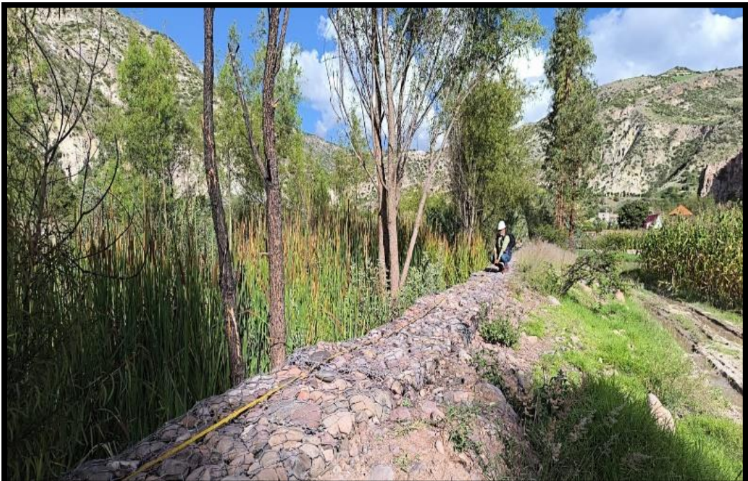
Fotografía 06: Medición longitudinal de la corona del muro de gaviones.
