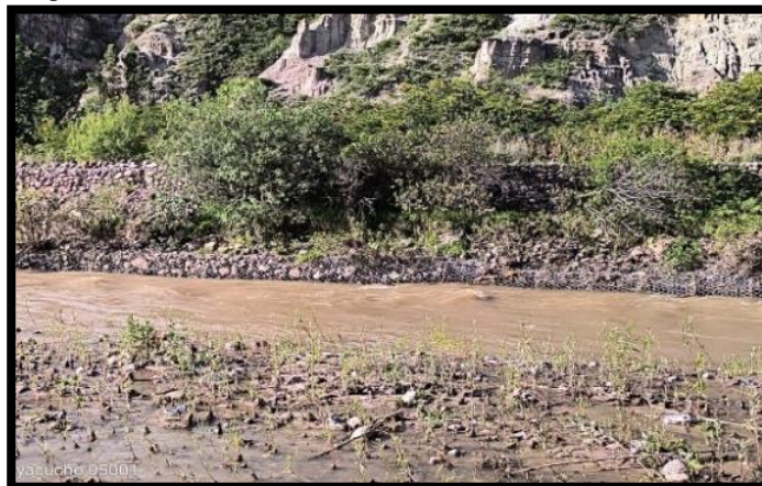
Figura 17. Sedimentación en defensa ribereña.
