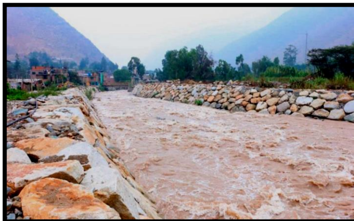
Figura 5. Defensa ribereña de enrocado.
