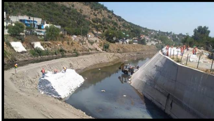
Figura 4. Dique ribereño de concreto.
