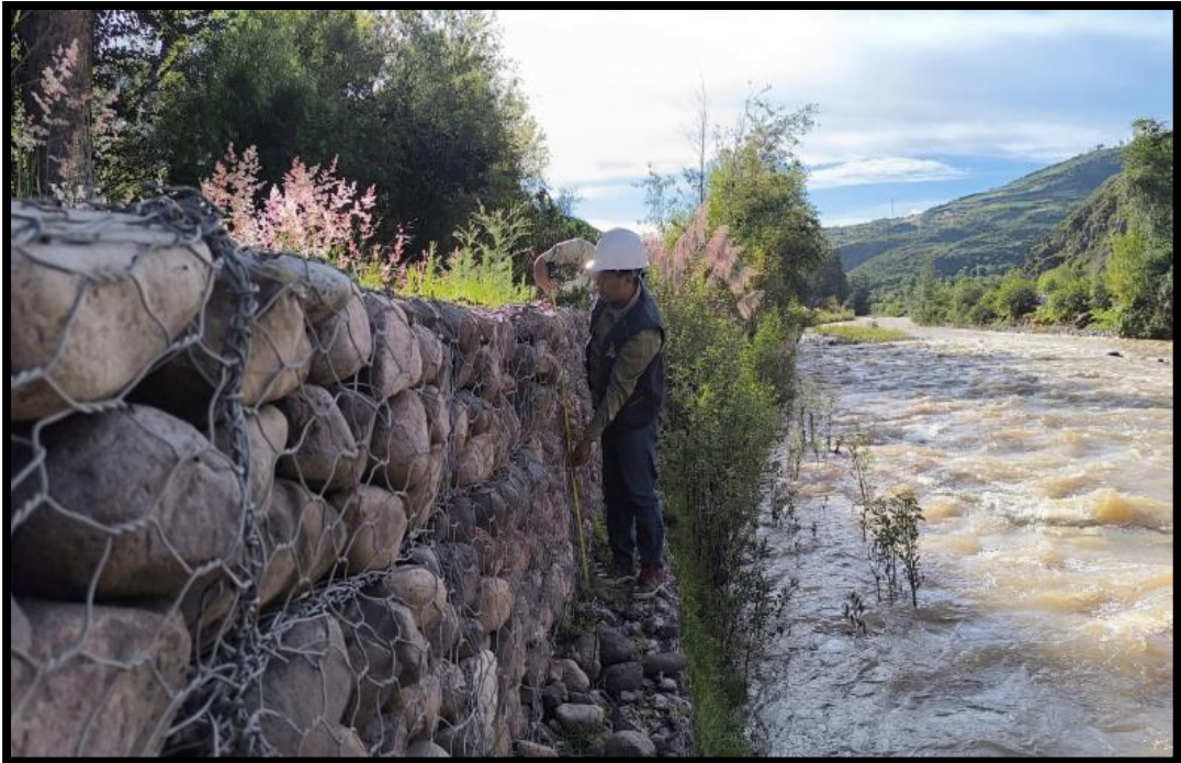
Fotografía 05: Verificación visual y medición de dimensiones del muro de gavión.
