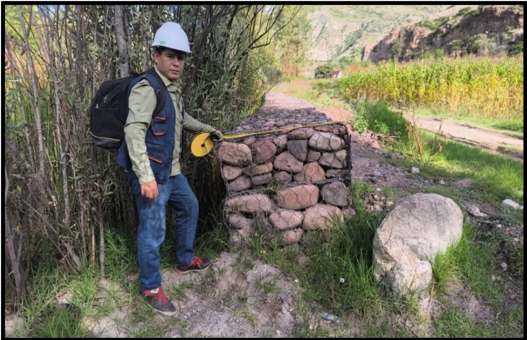
Fotografía 10: Inspección en la Progresiva 0+300, donde se aprecia densa vegetación en la zona.
