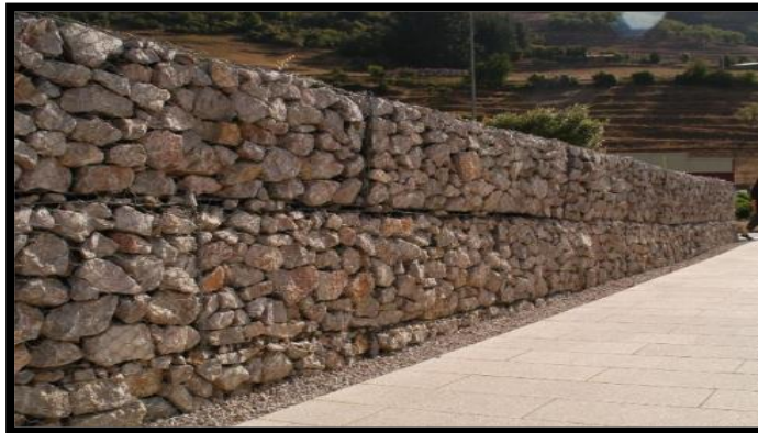
Figura 3. Muro de gaviones.
