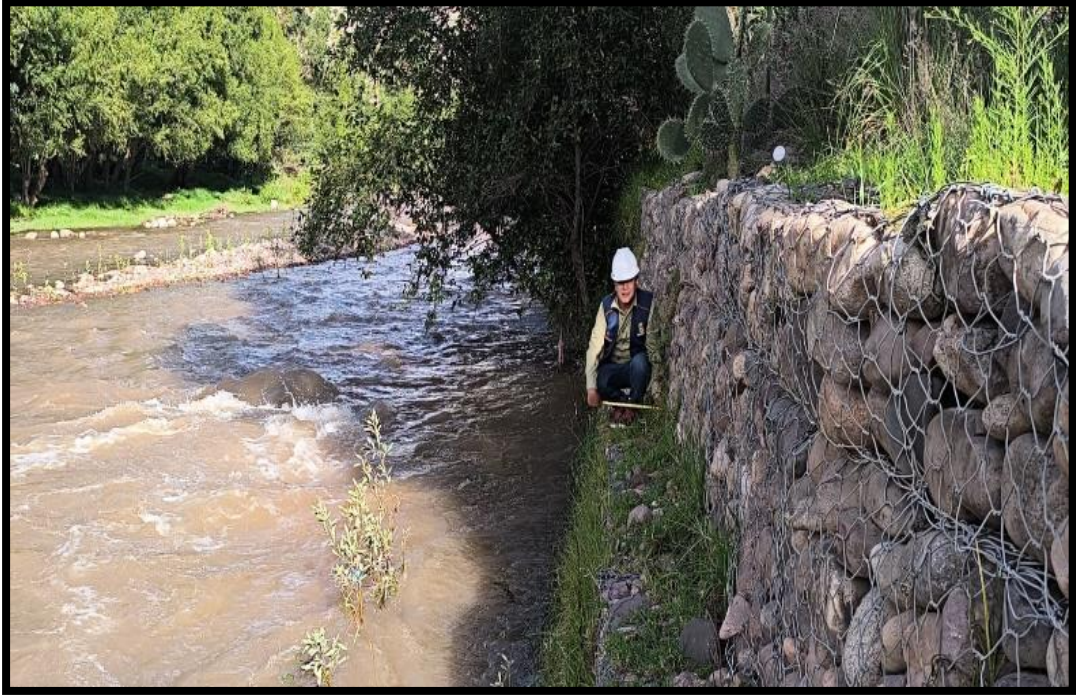
Fotografía 09: Toma de medidas del muro de gavión en el punto de inspección.
