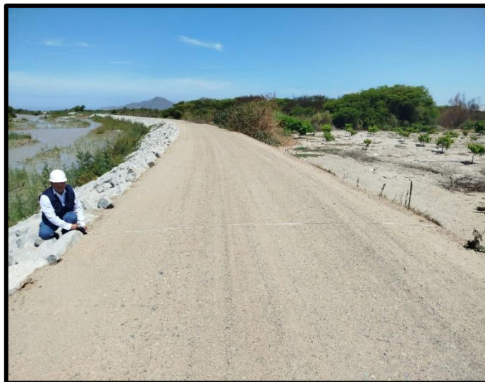
Figura 02: Ancho corona estado bueno
