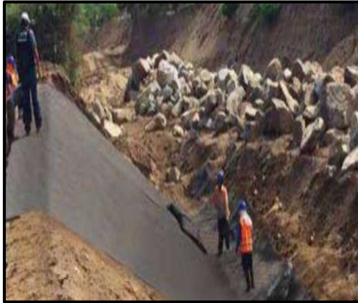
Figura 18: Geotextil de protección para dique enrocado.
