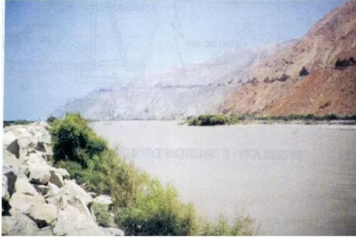
FOTO N° 2. DIQUE ENROCADO CONTINUO VALLE OCOÑA Q_{MAX} 3100 m 3 /seg.
