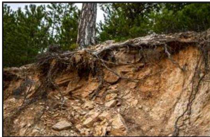
Figura 07: Erosión de terreno.
