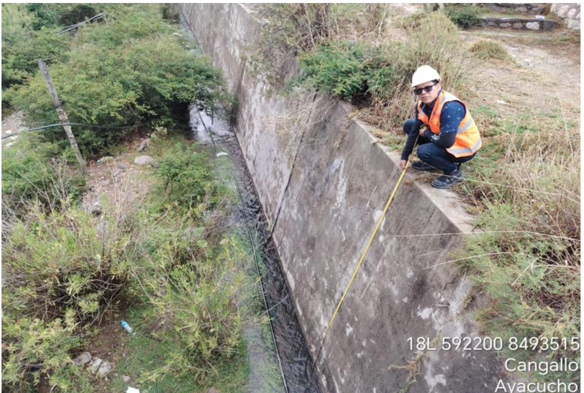
EVIDENCIA 04: Un muro de contención tipo con talón, el cual presenta una condición estructural regular.
