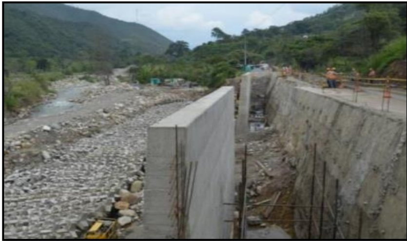
Figura N° 8: Muro de contención de concreto armado
