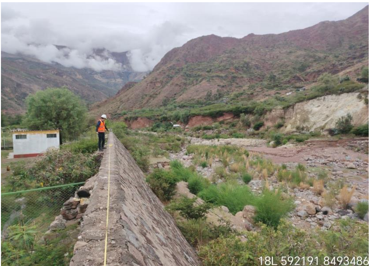
EVIDENCIA 06: Un muro de contención tipo con talón, el cual presenta una condición estructural regular.
