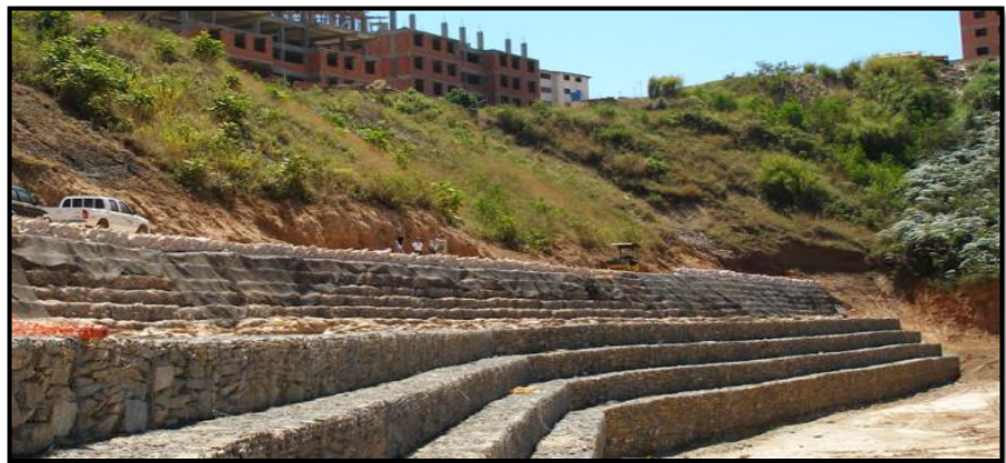
Figura N° 5: Muros de contención flexibles
