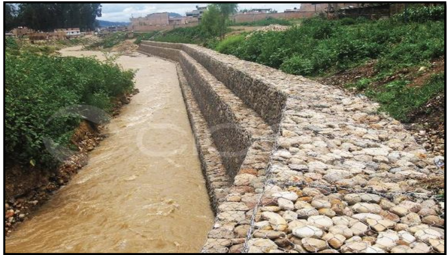
Figura N° 7: Muro de gaviones
