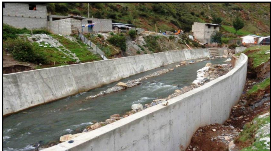
Figura N° 2: Muro de defensa ribereña Fuente: Agencia peruana de noticias (30)
