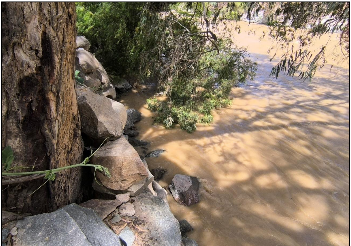
Fotografía 02: Zona 1, vegetación invasiva incrustado en el enrocado.
