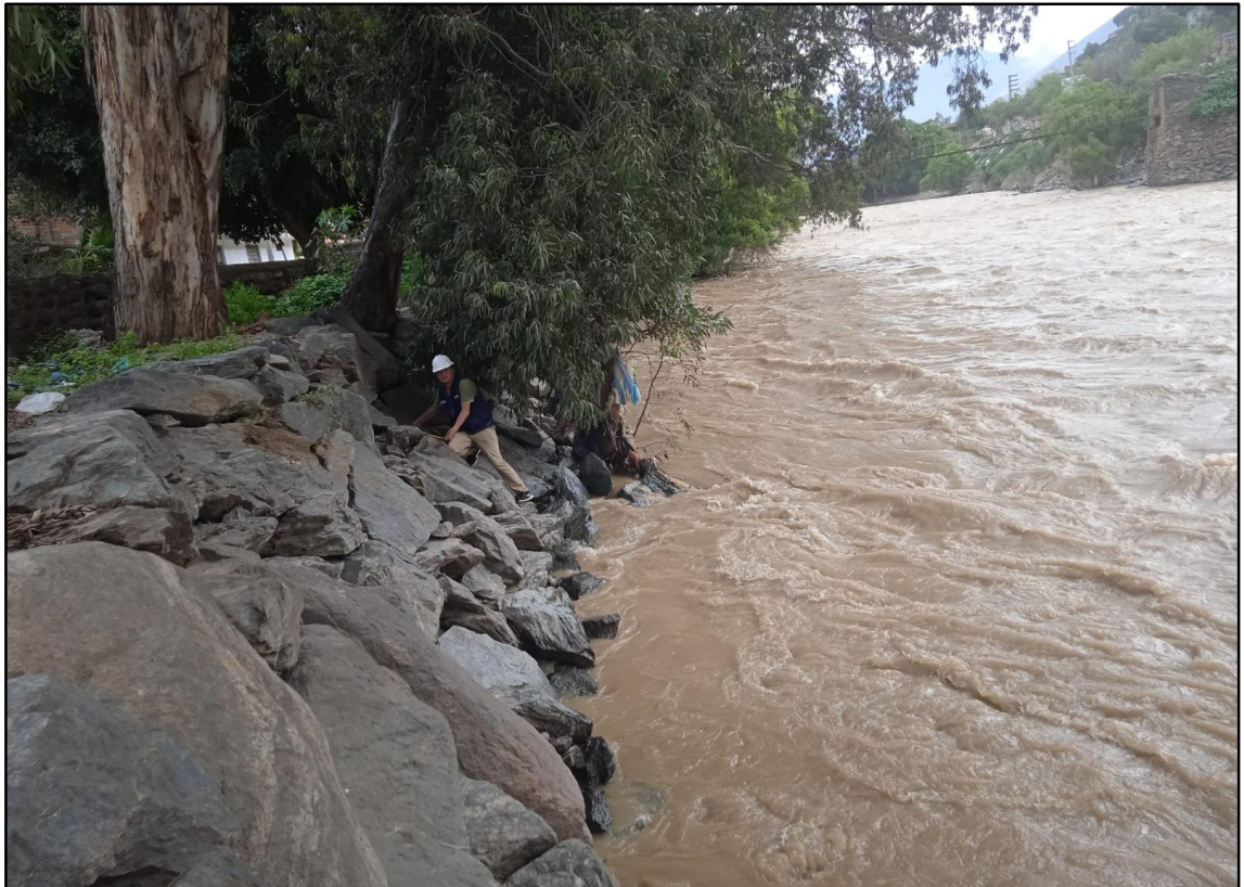
Fotografía 03: Zona 1, tomado medidas de las rocas, se evidencia deslizamiento parcial del material - Fecha: 22/03/2016.
