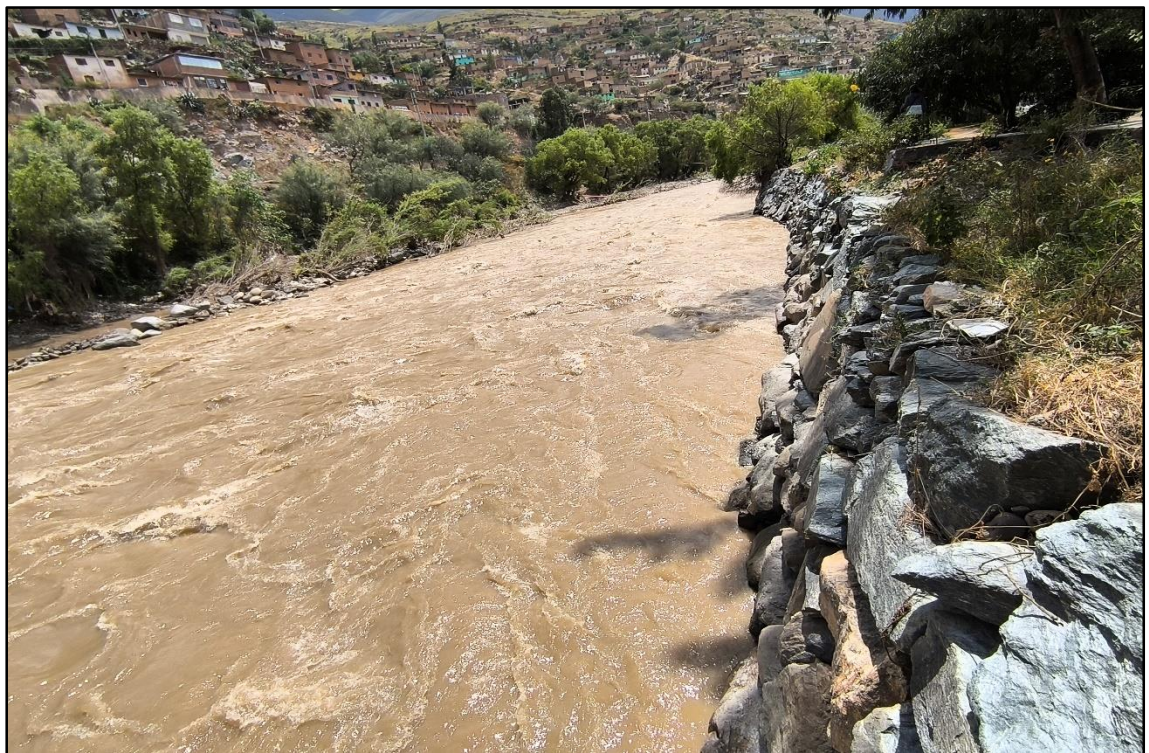
Fotografía 04: Zona 2, enrocado en buen estado.
