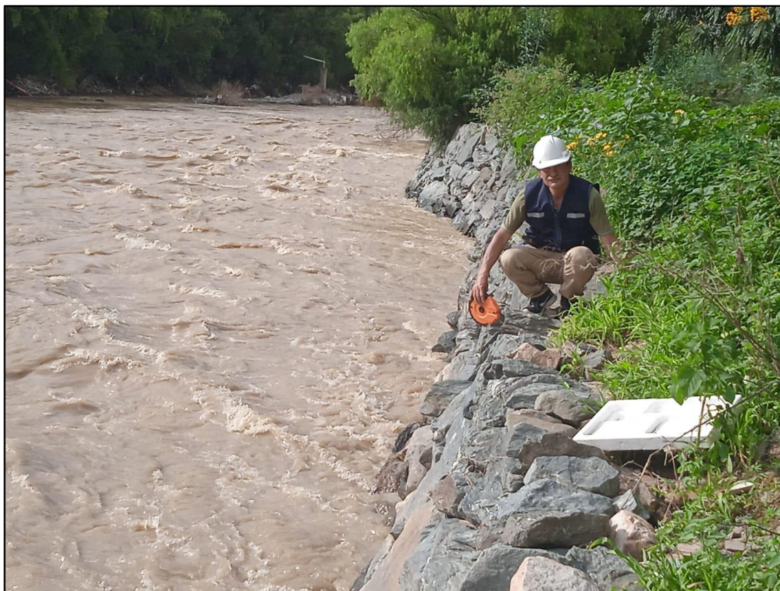
Fotografía 05: Zona 2, tomado medidas de la corona del enrocado, estructura en buen estado - Fecha: 23/03/2016. Fuente: Propia.
