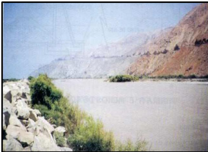
Figura 2: Enrocados con roca al volteo
