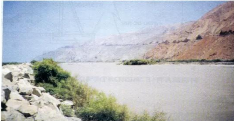
FOTO N° 2. DIQUE ENROCADO CONTINUO VALLE OCOÑA Q_{MAX} 3100 m 3 /seg.
